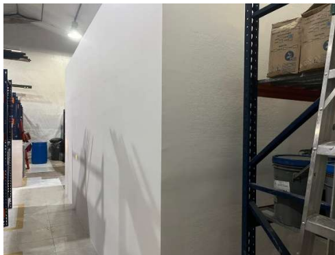
Muro en superboard.
