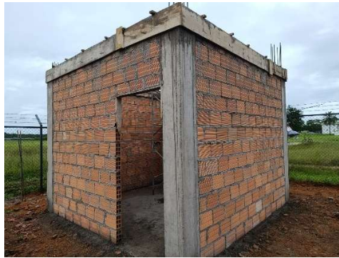
Viga de confinamiento.
