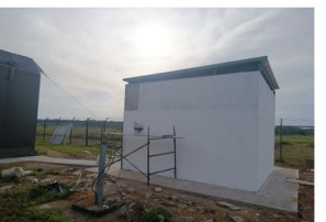
Estuco y pintura
