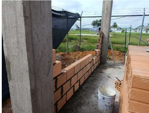
Muro en ladrillo.
