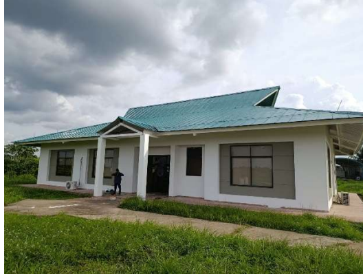
Estuco y pintura exterior
