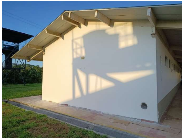
Estuco y pintura exterior.
