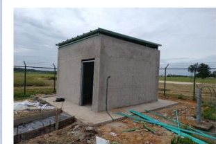
Acometida eléctrica exterior
