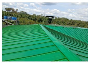
RESTAURACION DE CUBIERTA
