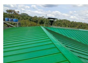
RESTAURACION DE CUBIERTA
