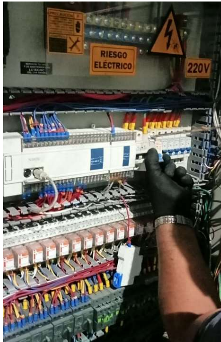
Mantenimiento de tableros.
