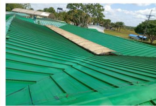
RESTAURACION DE CUBIERTA
