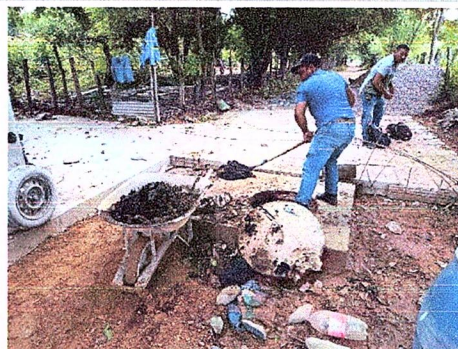
Fotografía 10. Limpieza de manhole.
