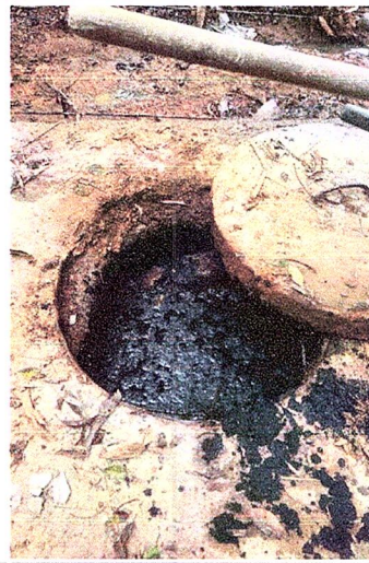
Fotografía 4. Manhole colapsado.
