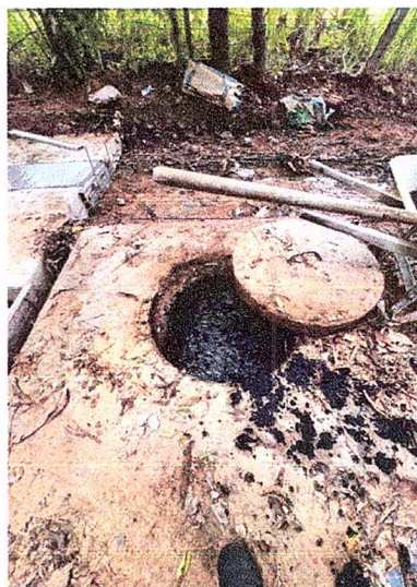
Ilustración 21. Manhole colapsado.
