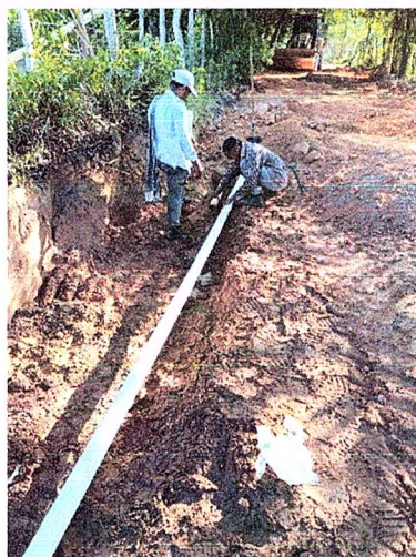
Ilustración 6. Reparación de tubería afectada durante excavación.
