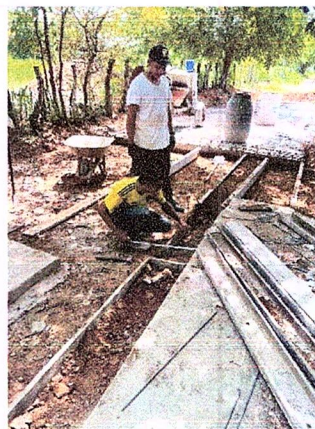
Ilustración 11. Enriado de placahuella.
