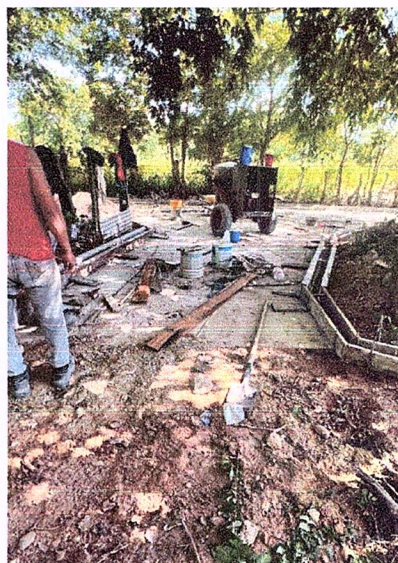
Ilustración 23. Enriado para bordillos.
