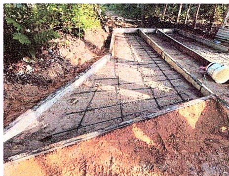
Ilustración 9. Acero para huella.
