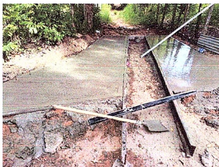
Ilustración 10. Concreto para huella.
