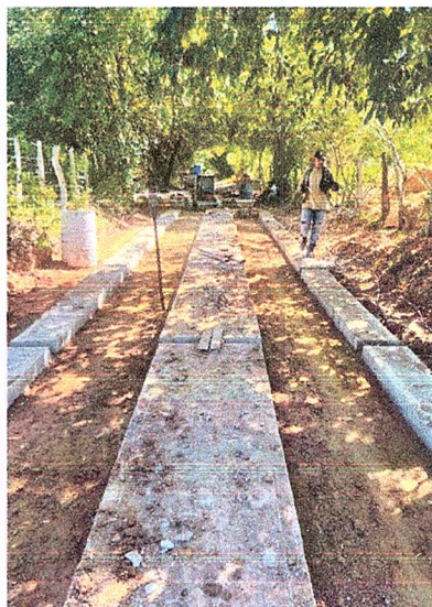
Ilustración 17. Huellas fundidas.
