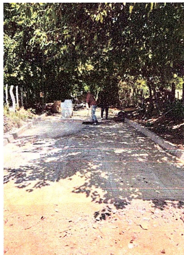
Ilustración 22. Placahuella terminada.
