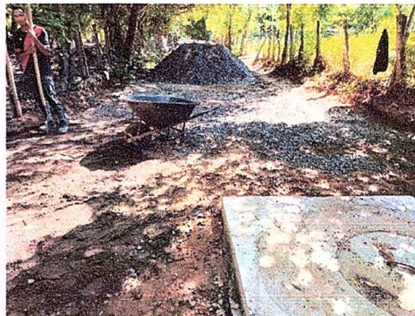
Ilustración 7. Compactación de subrasante.
