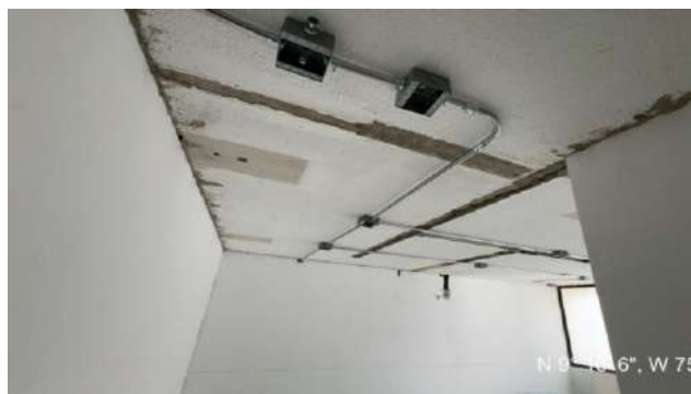
Instalacion de tuberia EMT para intalacion de luminarias
