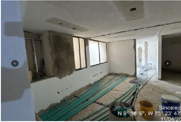
Pañete allanado en mortero oficina dirección
