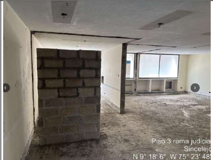
Levante de muro torre B y vaciado de machones
