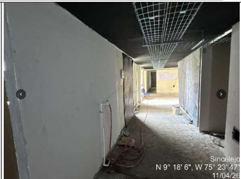
Instalacion de bandeja electrica por piso
