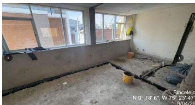
Pañete allanado en mortero oficina dirección
