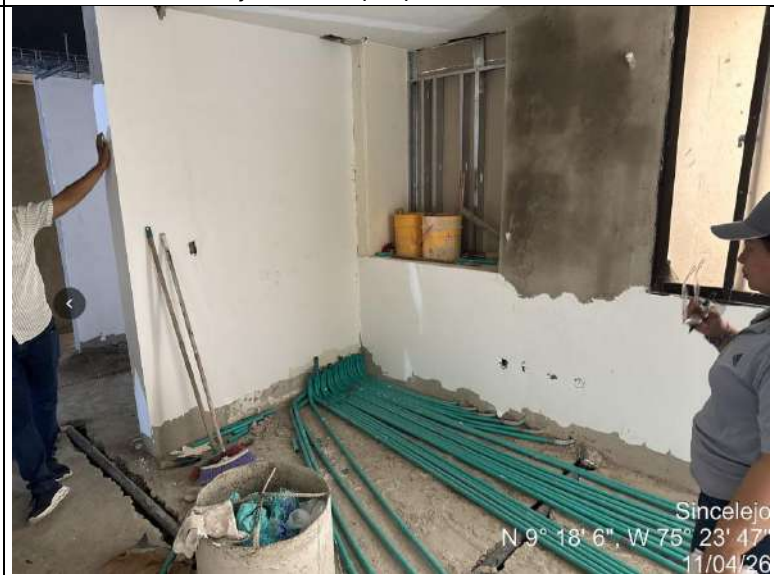
Instalacion de bandeja electrica por piso
