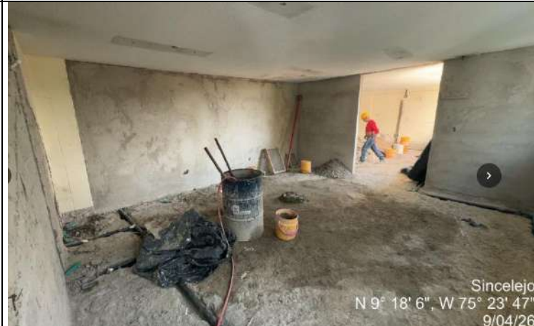
Levante de muro torre B y vaciado de machones
