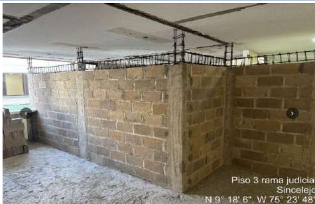
Levante de muro torre B y vaciado de machones
