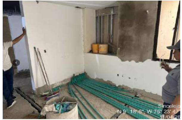
Pañete allanado en mortero oficina dirección
