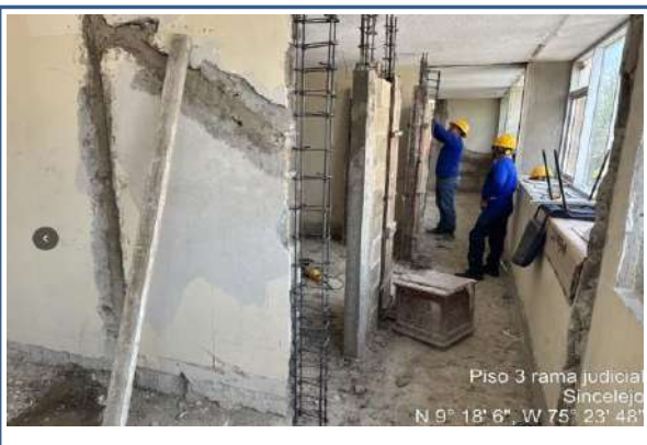
Levante de muro torre B y vaciado de machones
