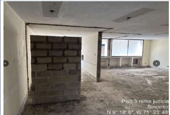
Levante de muro torre B y vaciado de machones
