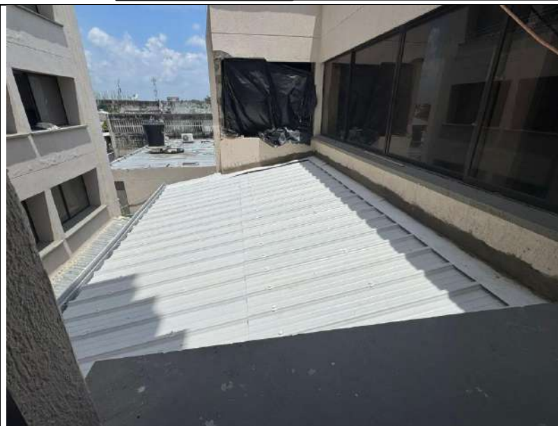
Instalacion de cubierta CCTV
