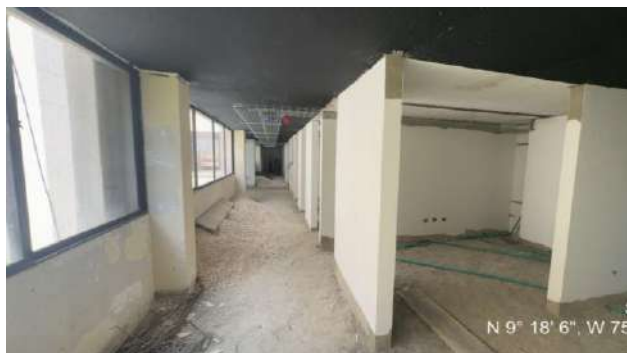
Instalacion de canal metalica por techo para cableado electrico del pasillo
