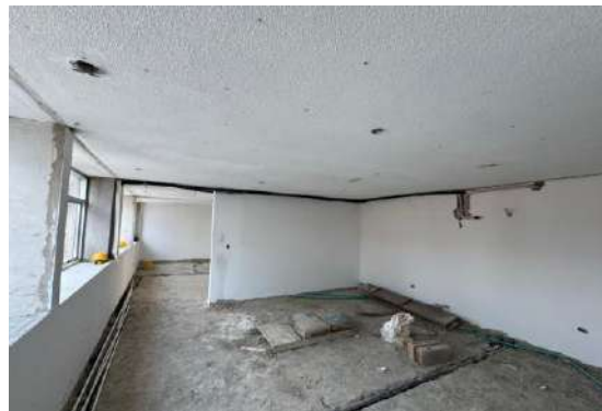
Instalacion de tuberia de cobre para aires acondicionados
