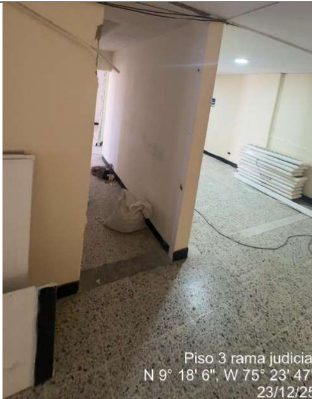
Foto inicial. oficina área sistemas 23-12-2025
