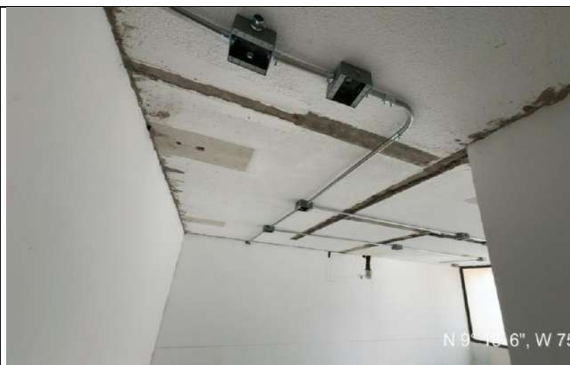
Instalacion de tuberia EMT para intalacion de luminarias
