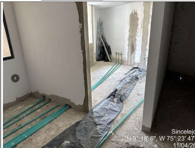
Instalacion de tuberia electrica por piso
