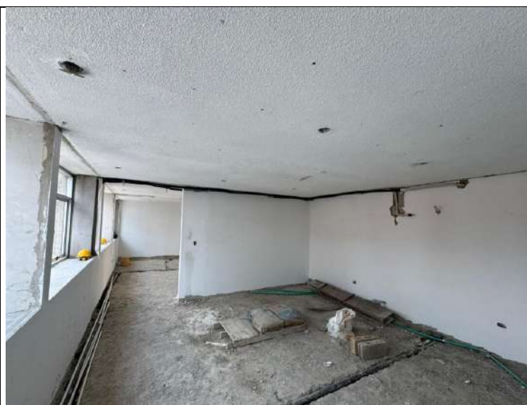
Instalacion de tuberia de cobre para aires acondicionados
