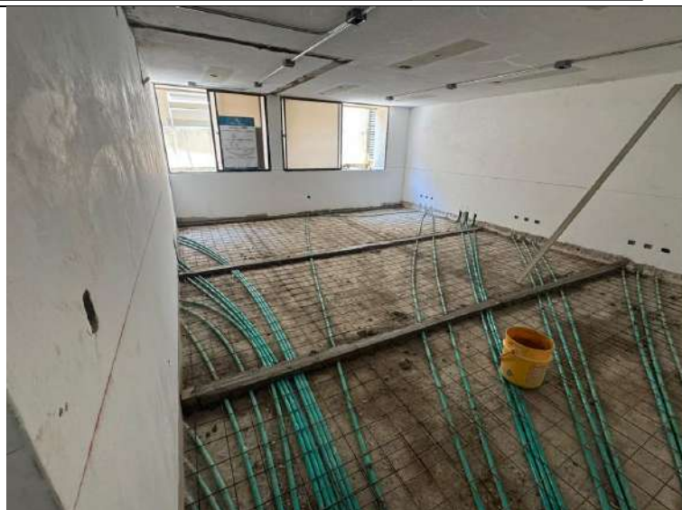
Instalacion de malla electrosoldada area bienestar
