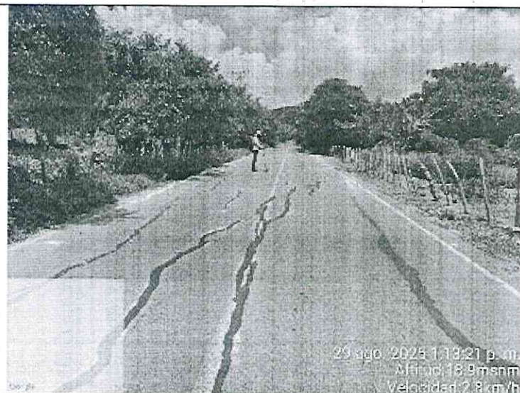
Evidencia 2. Visita a los Fretes de Obra mantenimiento Vial 2.
