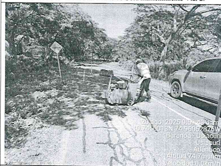
Evidencia 3. Visita a los Fretes de Obra mantenimiento Vial 2..
