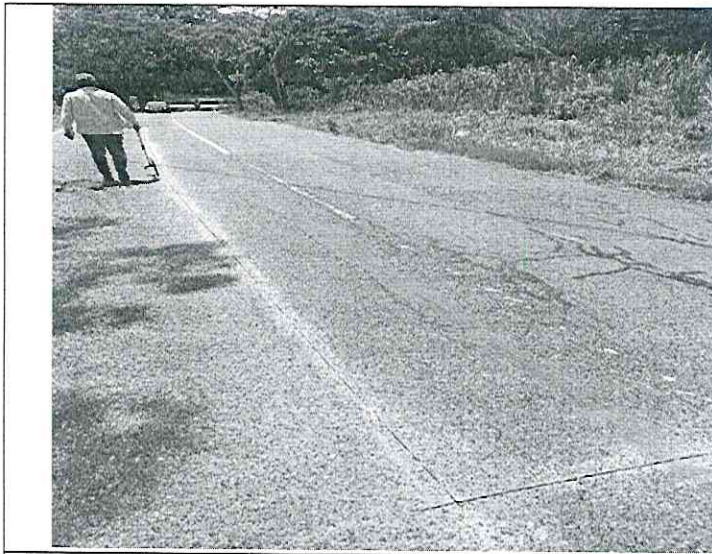
Evidencia 5. Visita a los Fretes de Obra mantenimiento Vial 2..
