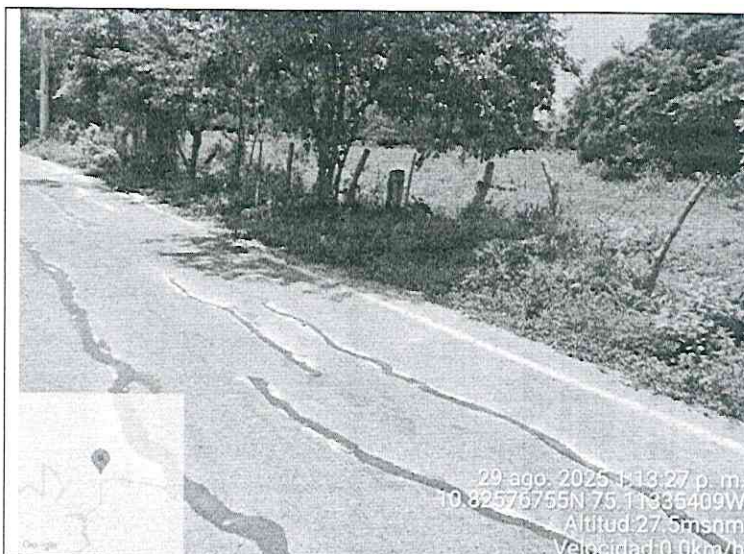
Evidencia 1. Visita a los Fretes de Obra mantenimiento Vial 2.
