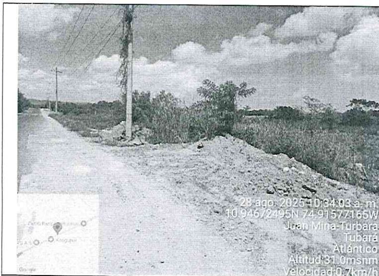
Evidencia 7. Visita a los Fretes de Obra mantenimiento Vial 2.
