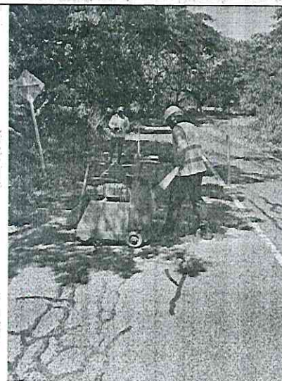
Evidencia 4. Visita a los Fretes de Obra mantenimiento Vial 2.
