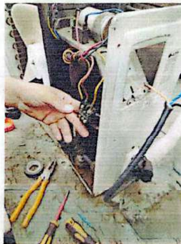
Mantenimiento correctivo reparación de borneras compresor
