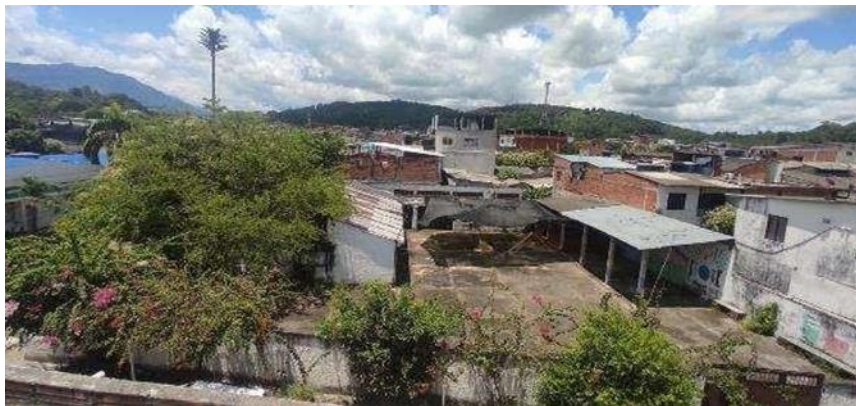
Imagen 3. Vista frontal por la Calle 10
