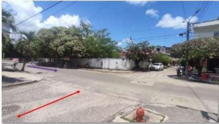
Imagen 5. Fotografías estado de la vía (CII.10). Fuente Alcaldía municipal y Dirección seccional Bucaramanga.
