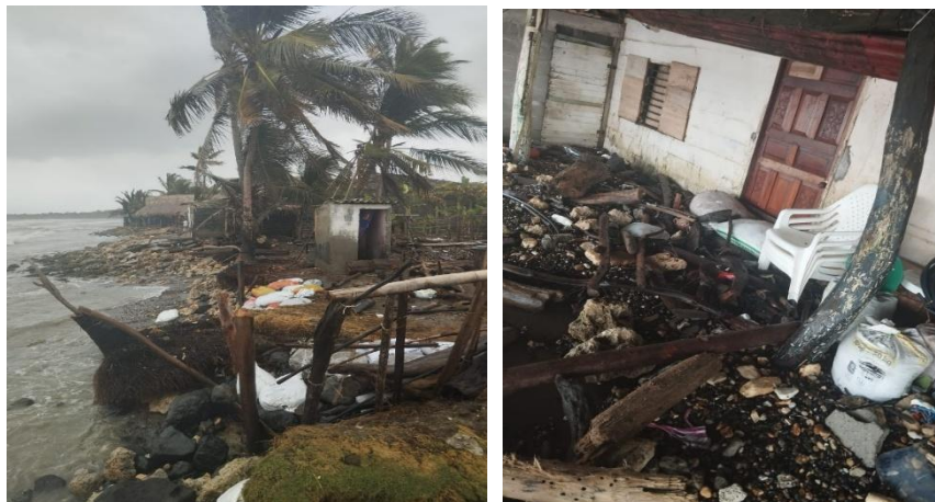
Figura 11 y 12. Afectaciones generadas en el sector de Santander de la Cruz, ante el aceleramiento de la erosión costera. Fuente: Alcaldía municipal de Moñitos
