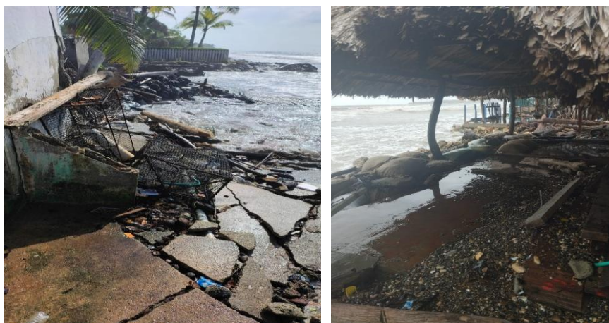
Figura 13 y 14. Afectaciones generadas en el sector de Santander de la Cruz, ante el aceleramiento de la erosión costera. Fuente: Alcaldía municipal de Moñitos.
