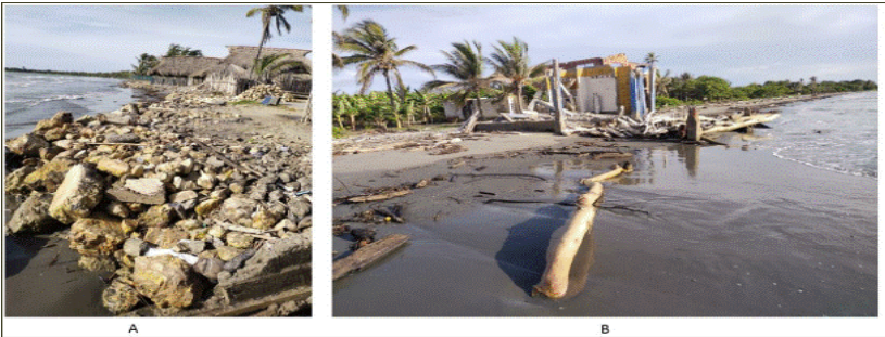
Figura 9 y 10. Imagen detallada de obras civiles Santander de la Cruz. Fuente: Aqua & Terra Consultores Asociados S.A.S., 2022.
