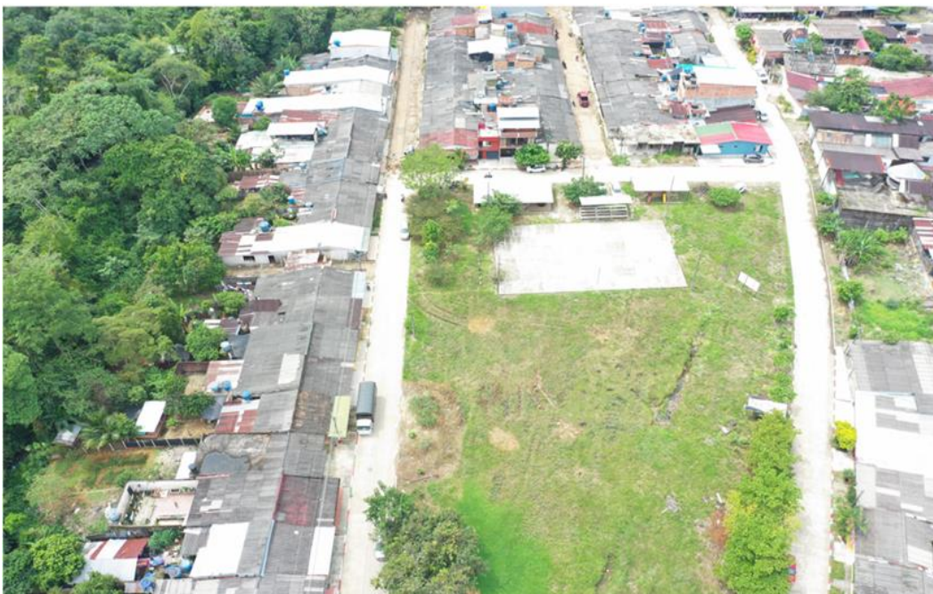
Ilustración 3 Registro Fotográfico Vista Aérea Obra Betania, tomada mediante un Dron.
