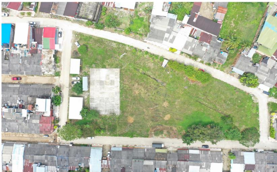
Ilustración 2 Registro Fotográfico Vista Aérea Obra Betania, tomada mediante un Dron.
