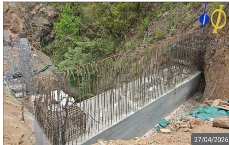
Fotografía 5-65 Puente 7. Estribo 2 – caisson 5 y 6
