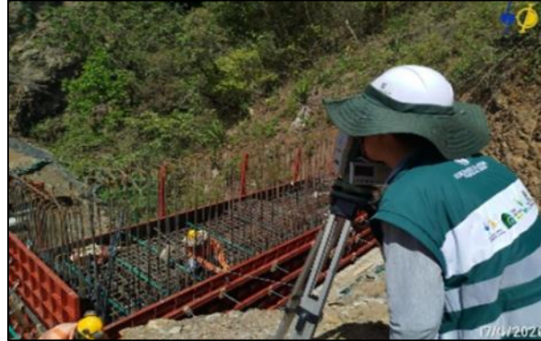
Fotografía 5-2 Puente 7. Liberación formaleta de encofrado y niveles de acabado estribo 2
