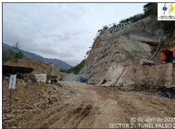
Fotografía 5-23 Túnel falso 2, Estabilización en la parte alta del talud.
