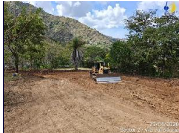
Fotografía 5-59 adecuación de la vía transitoria para llegar a puente 11
