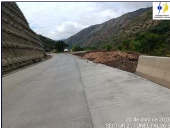
Fotografía 5-34 Túnel falso 3, paisajismo de costado izquierdo con material de excavación.
