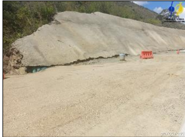
Fotografía 5-62 Puentes 5, Losa de aproximación Llena estructural material de subbase a nivel de subrasante Estribo 2
