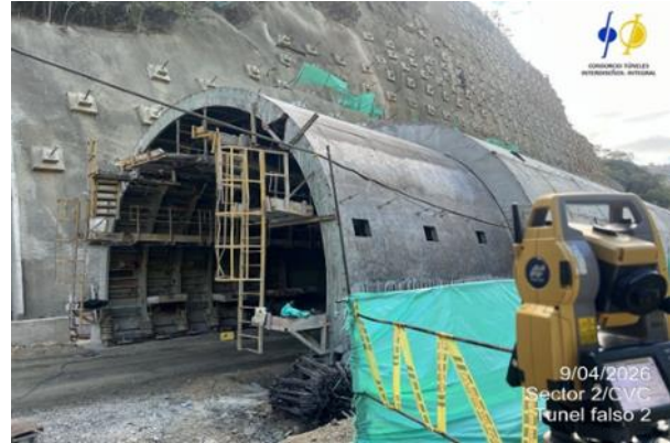
Fotografía 5-8 Chequeo y adecuación de radios en formaleta para inicio de actividades de armado de acero de brocal tipo flauta portal salida de K12+400 a K12+407,5.
