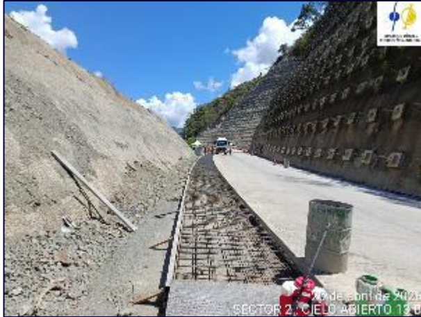
Fotografía 5-26 CA13B se realiza la instalación de acero de refuerzo y hormigonado de MR45 en berma derecha y berma izquierda
