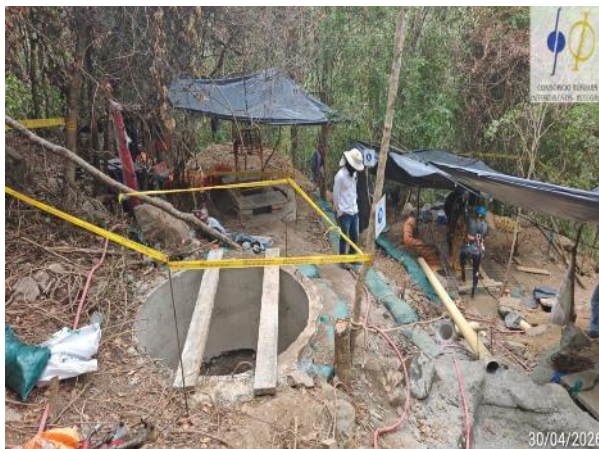
Fotografía 5-71 puente 11, pila 1, caisson 4
