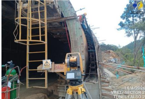
Fotografía 5-7 Chequeo y adecuación de radios en formaleta para inicio de actividades de armado de acero de brocal tipo flauta portal salida de K12+400 a K12+407,5.
