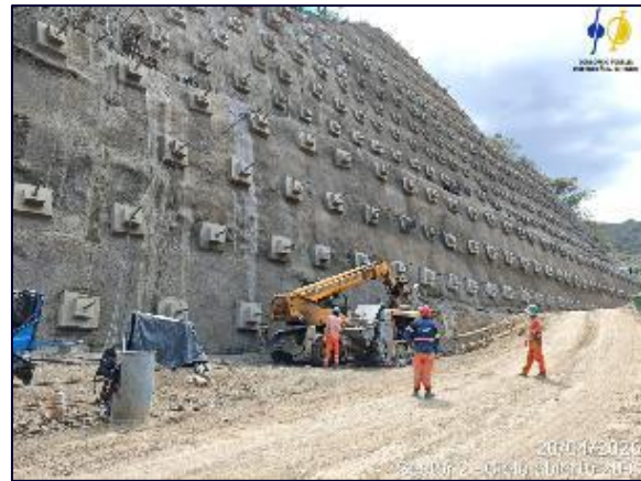
Fotografía 5-45 CA 20C. Tratamiento de sostenimiento del talud
