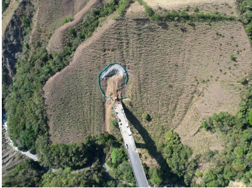
Fotografía 8-8 Portal Salida túnel 10
