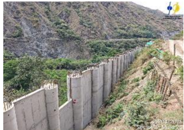
Fotografía 5-51 muro 25 se realiza excavaciones para caisson instalación de acero de refuerzo y hormigonado de pilas.
