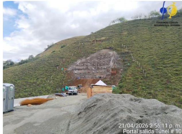
Fotografía 5-80 Túnel 10. Portal salida construcción cerramiento predial.
