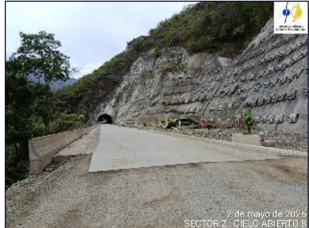
Fotografía 5-14 Cielo abierto 8 frente inactivo durante el mes.
