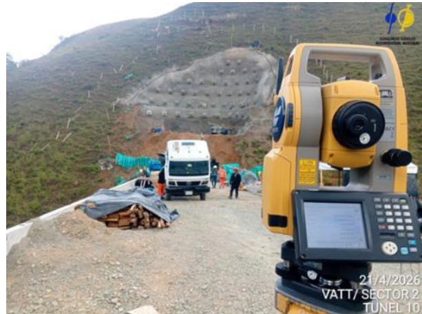
Fotografía 5-12 Levantamiento topográfico de corte y perfilación de talud
