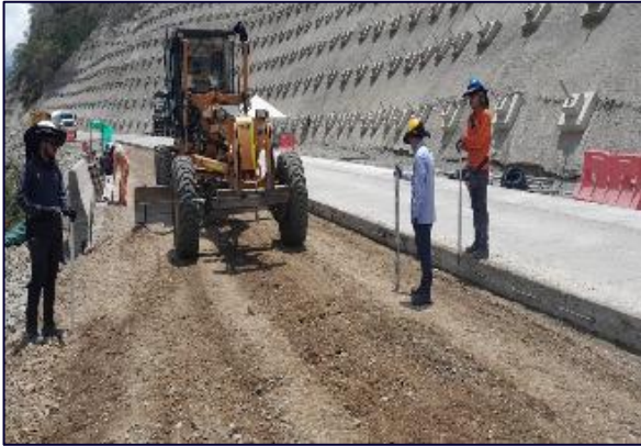
Fotografía 5-24 Cielo abierto 13B-4 calvario, Se realizan actividades Cerezo de capa de 15cm de subbase granular ambos carriles.
