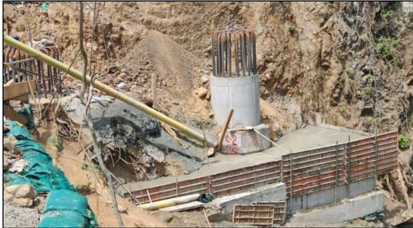
Fotografía 5-63 Puente 7. Caisson 1 y 2 Estribo 1
