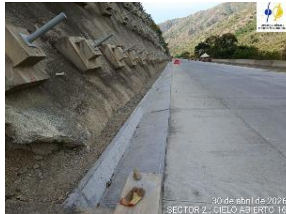
Fotografía 5-37 Cielo abierto 16, se realiza en la margen derecha la construcción de cunetas
