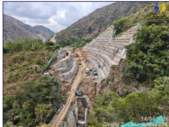
Fotografía 5-49 CA20E actividades de sostenimiento talud izquierdo
