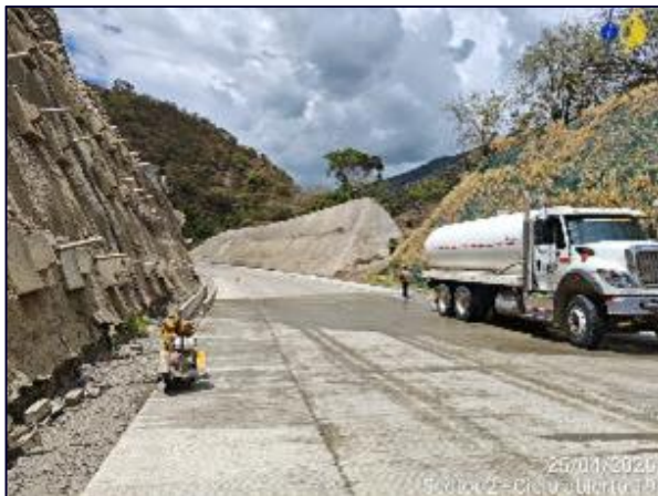
Fotografía 5-40 Cielo abierto 19, lavado y corte de las juntas transversales y longitudinales de las losas del MR45 bermas
