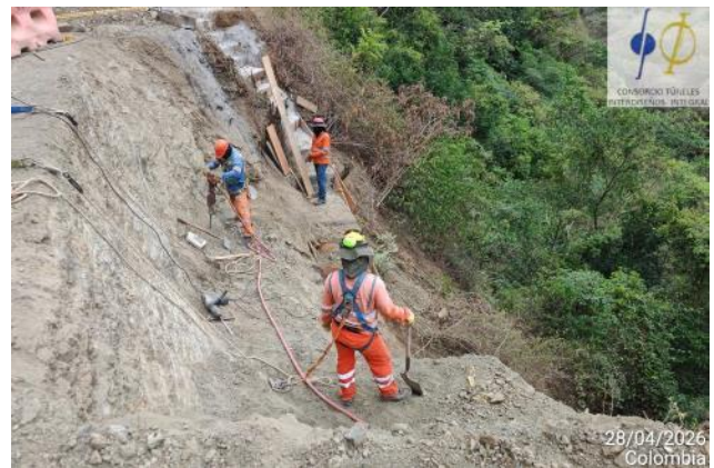
Fotografía 5-61 Puente 4A pila 1, adecuación plataforma caisson 4
