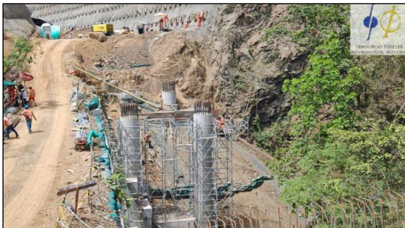
Fotografía 5-64 Puente 7. Pila 1 – Columnas 3 y 4
