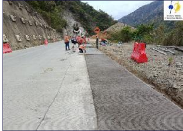
Fotografía 5-33 CA 15 instalación de acero de refuerzo e instalación de MR-45 en berma izq.
