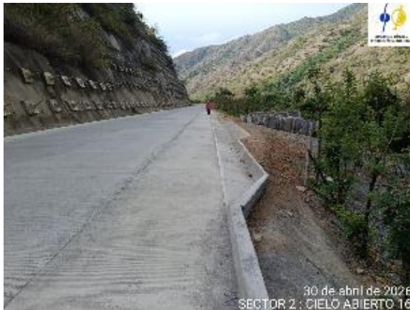
Fotografía 5-36 Cielo abierto 16, se realiza en el margen izquierdo la construcción de cunetas
