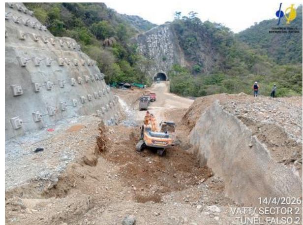
Fotografía 5-21 Retiro material sector portal entrada túnel falso 2
