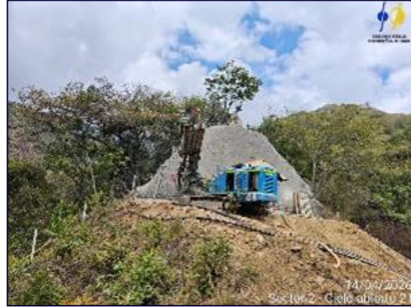
Fotografía 5-53 CA 23 construcción de vía transitoria para llegar a CA 24 y puente 11
