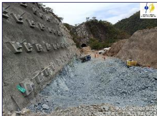
Fotografía 5-22 Túnel falso 2 perforaciones para anclajes de 30, y 40 ton
