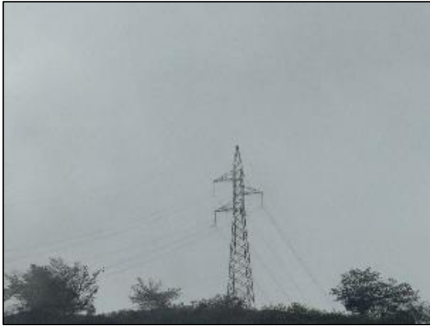
Fotografía 8-1 Torre 19 LT Santa Fe Chorodó 110 kV-1
