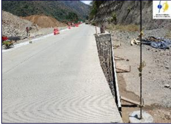
Fotografía 5-32 CA 15 instalación de acero de refuerzo e instalación de MR-45 en berma izq.
