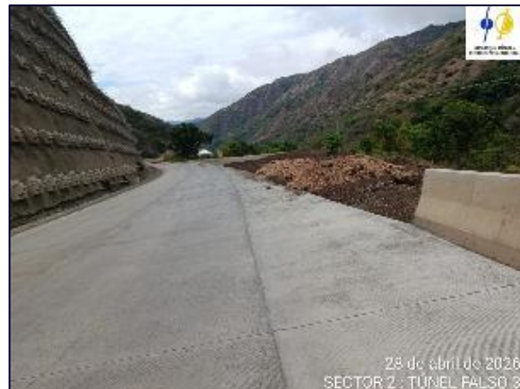
Fotografía 5-35 Túnel falso 3, paisajismo de costado izquierdo con material de excavación
