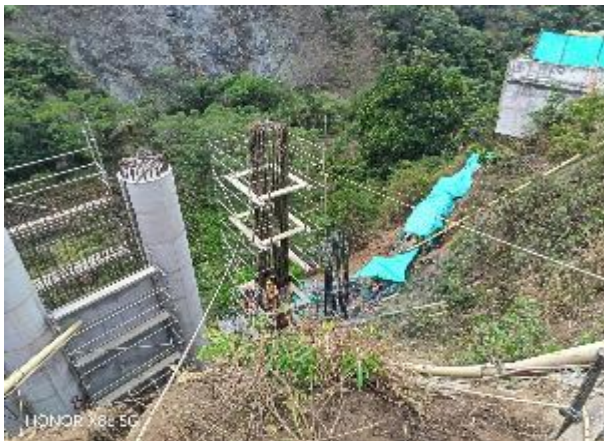
Fotografía 5-50 muro 25 se realiza excavaciones para caisson instalación de acero de refuerzo y hormigonado de pilas.
