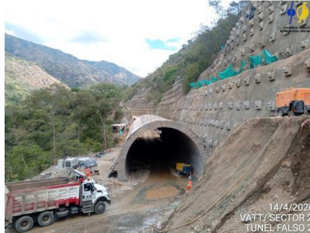
Fotografía 5-17 Túnel falso 2 de módulo 19 a 14
