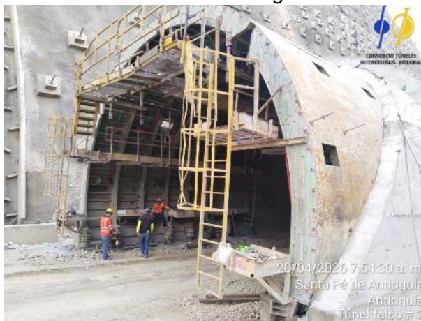
Fotografía 5-18 Brocal portal salida túnel falso 2
