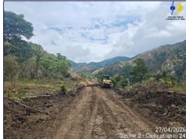
Fotografía 5-57 adecuación de la vía transitoria para llegar a puente 11
