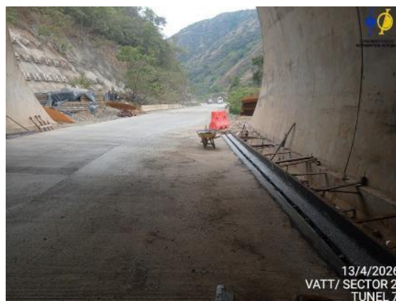
Fotografía 5-76 Actividades de construcción cárcamo de derrame.
