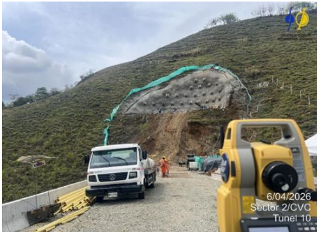
Fotografía 5-11 Levantamiento topográfico de corte y perfilación de talud
