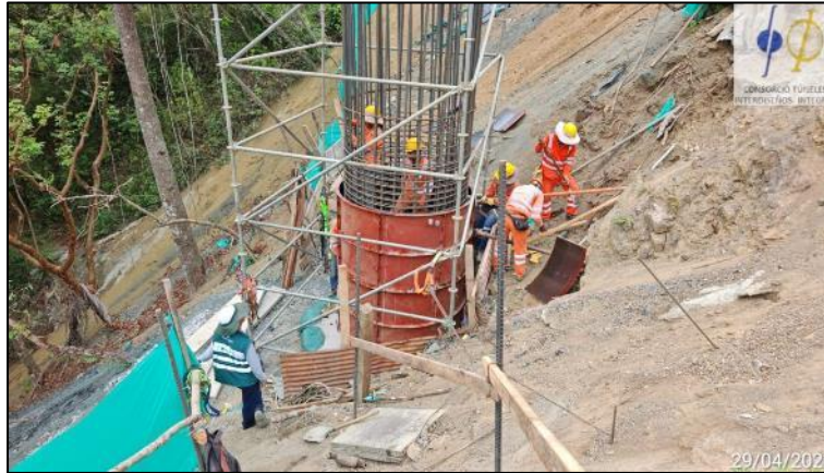
Fotografía 5-68 Pila 1. Columna 3, caisson 3
