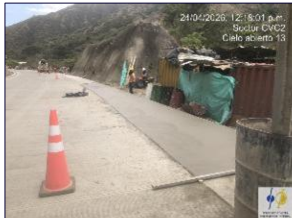
Fotografía 5-29 CA13C se inicia la instalación de acero de refuerzo y hormigonado de MR45 en berma derecha
