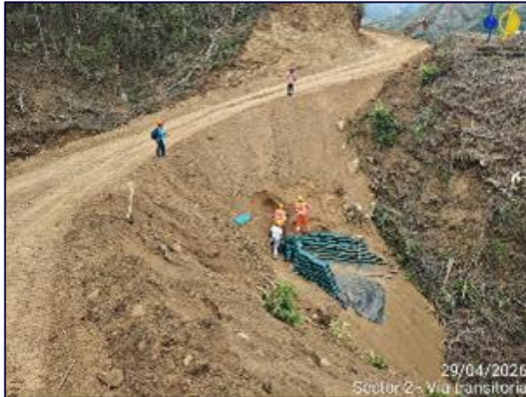
Fotografía 5-56 CA 21 adecuación de la vía transitoria y pasos de vaguadas para adecuar drenajes.
