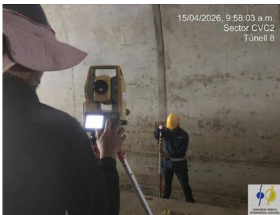
Fotografía 5-9 Marcación de referencias a ordenada de 3,40m desde eje, para cárcamo de derrame tipo gota de K15+013,50 a K15+089, margen izquierda.
