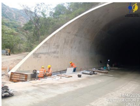
Fotografía 5-75 Actividades de construcción cárcamo de derrame.
