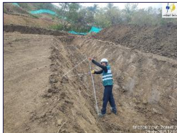
Fotografía 5-55 excavaciones para construcción de las trincheras del zodme 7.
