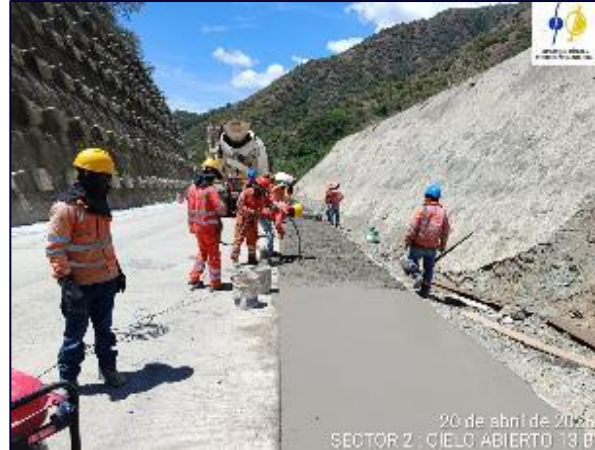
Fotografía 5-27 CA13B se realiza la instalación de acero de refuerzo y hormigonado de MR45 en berma derecha y berma izquierda
