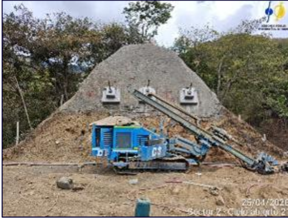
Fotografía 5-52 CA 21 construcción de vía transitoria para llegar a CA 24 y puente 11
