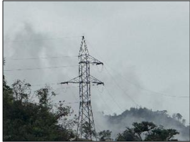
Fotografía 8-2 Torre 19 LT Santa Fe Chorodó 110 kV
