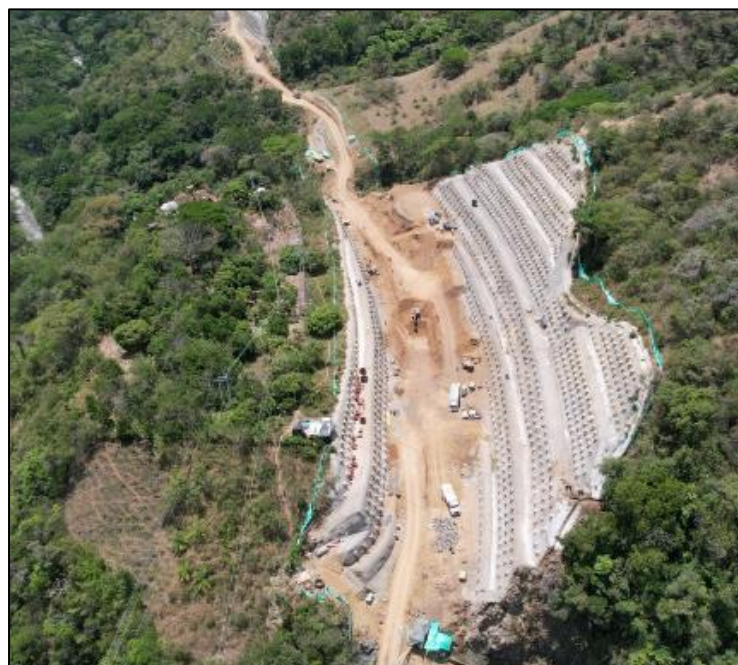
Fotografía 8-6 Cielo abierto 20E sostenimiento.
