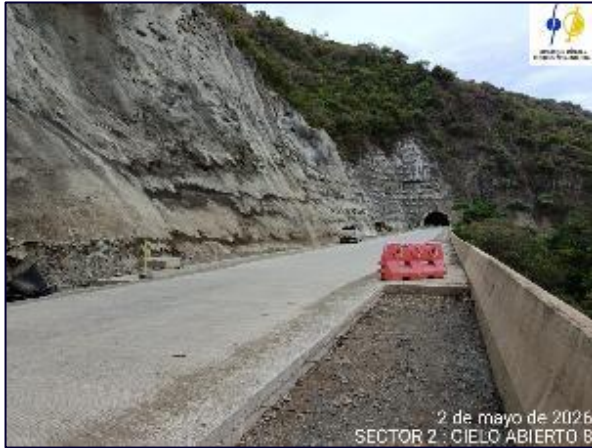
Fotografía 5-13 Cielo abierto 8, frente inactivo durante el mes
