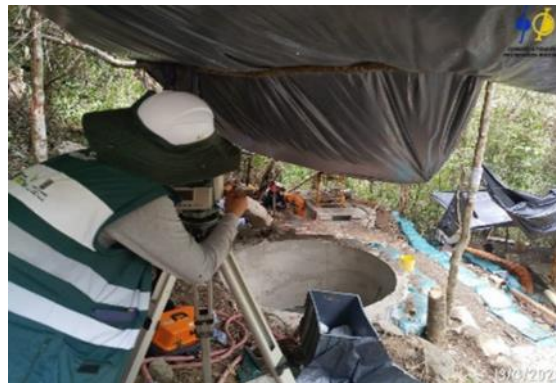
Fotografía 5-5 Puente 11. Chequeo de puntillas guía en caissons 3. 4. 5 y 6. Liberación verticalidad y excentricidad de anillos
