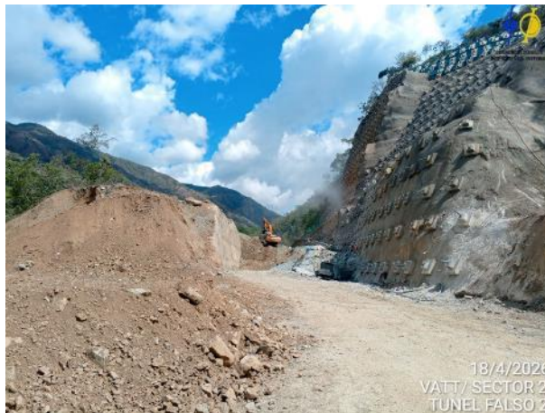
Fotografía 5-20 Retiro material sector portal entrada túnel falso 2
