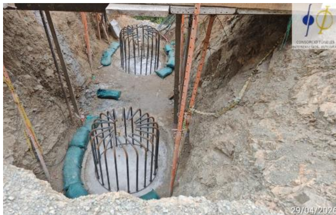
Fotografía 5-60 Puente 4A caisson 2 y 3.
