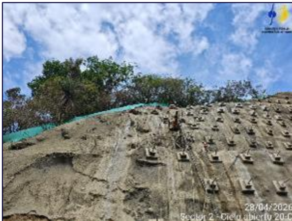
Fotografía 5-44 CA 20C Tratamiento de sostenimiento del talud
