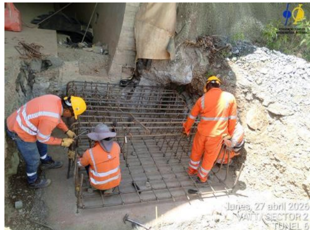
Fotografía 5-74 Actividades de instalación del acero de refuerzo para viga base izquierda brocal salida túnel.
