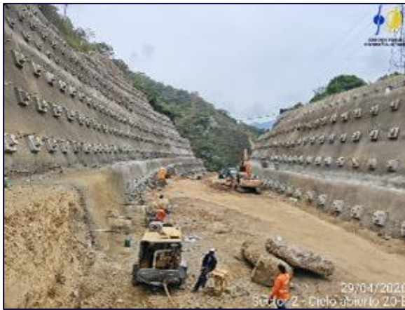
Fotografía 5-48 CA 20E actividades de sostenimiento talud derecho
