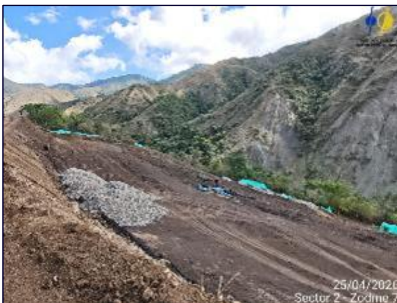
Fotografía 5-54 adecuación de la zona del zodme 7.
