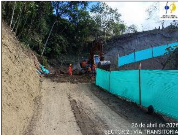
Fotografía 5-58 CA 21 adecuación de la vía transitoria y pasos de vaguadas para adecuar drenajes, cerramiento con tela verde
