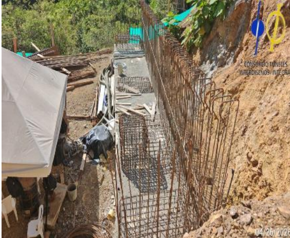
Fotografía 5-66 Estribo 1, puente 8
