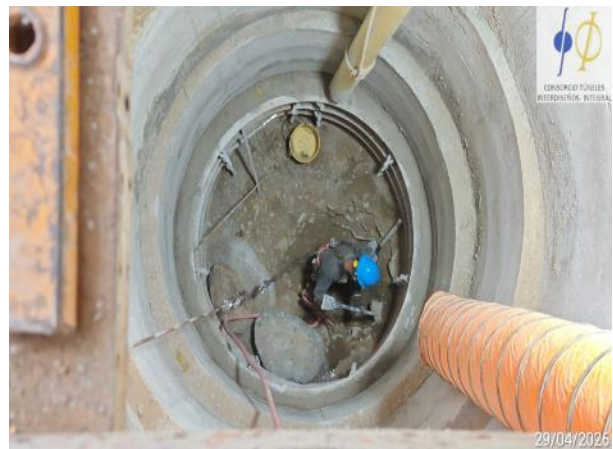
Fotografía 5-72 puente 11, pila 1, Caisson 6
