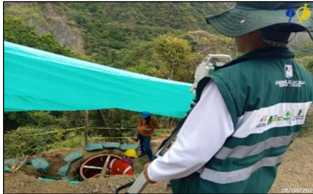
Fotografía 5-4 Puente 9. Chequeo aplome y excentricidad caissons 2 y 4.
