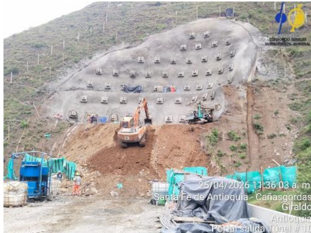
Fotografía 5-79 Túnel 10 portal salida. Estado de avance excavación y soporte en 2ta línea de talud inferior
