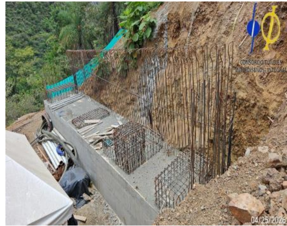
Fotografía 5-67 Viga cabezal, estribo 1
