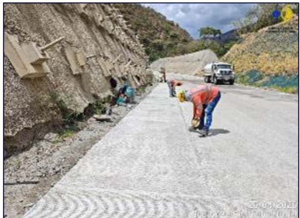
Fotografía 5-41 cielo abierto 19, instalación del sello de juntas de las losas del MR45 en las bermas derecha e izquierda
