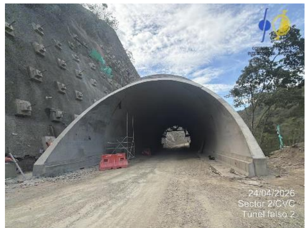
Fotografía 5-19 Brocal portal salida túnel falso 2
