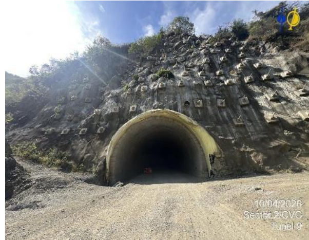
Fotografía 5-78 Estado de obras en portal salida túnel 9
