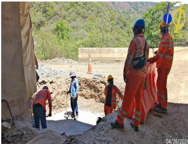
Fotografía 5-73 Actividades de instalación del solado de limpieza para viga base izquierda brocal salida túnel.
