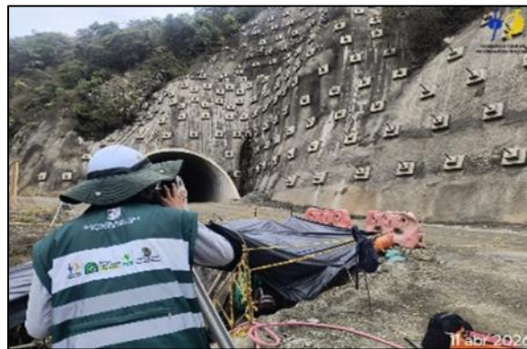
Fotografía 5-1 Puente 4A. Chequeo y liberación caissons 2, 3, 7 y 8
