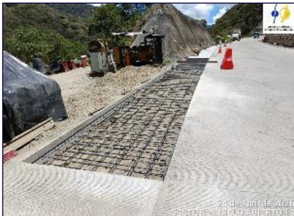
Fotografía 5-28 CA13C se inicia la instalación de acero de refuerzo y hormigonado de MR45 en berma derecha
