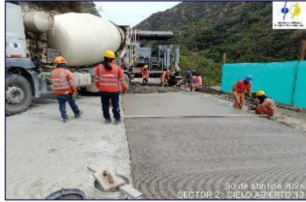
Fotografía 5-25 cielo abierto 13B-4 calvario, se realizan actividades de instalación de MR45 ambos carriles y berma derecha
