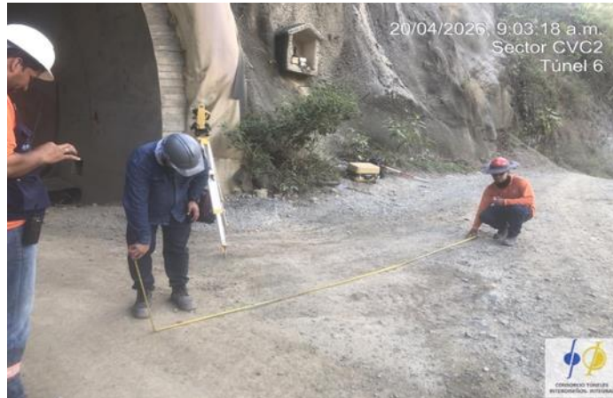
Fotografía 5-6 Marcación de localización cimentación de brocal portal salida margen izquierda del túnel 6.
