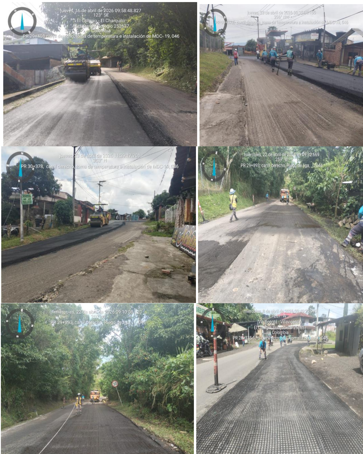
Ilustración 6. Instalación de Mezcla asfáltica, imprimación, Fresado.
