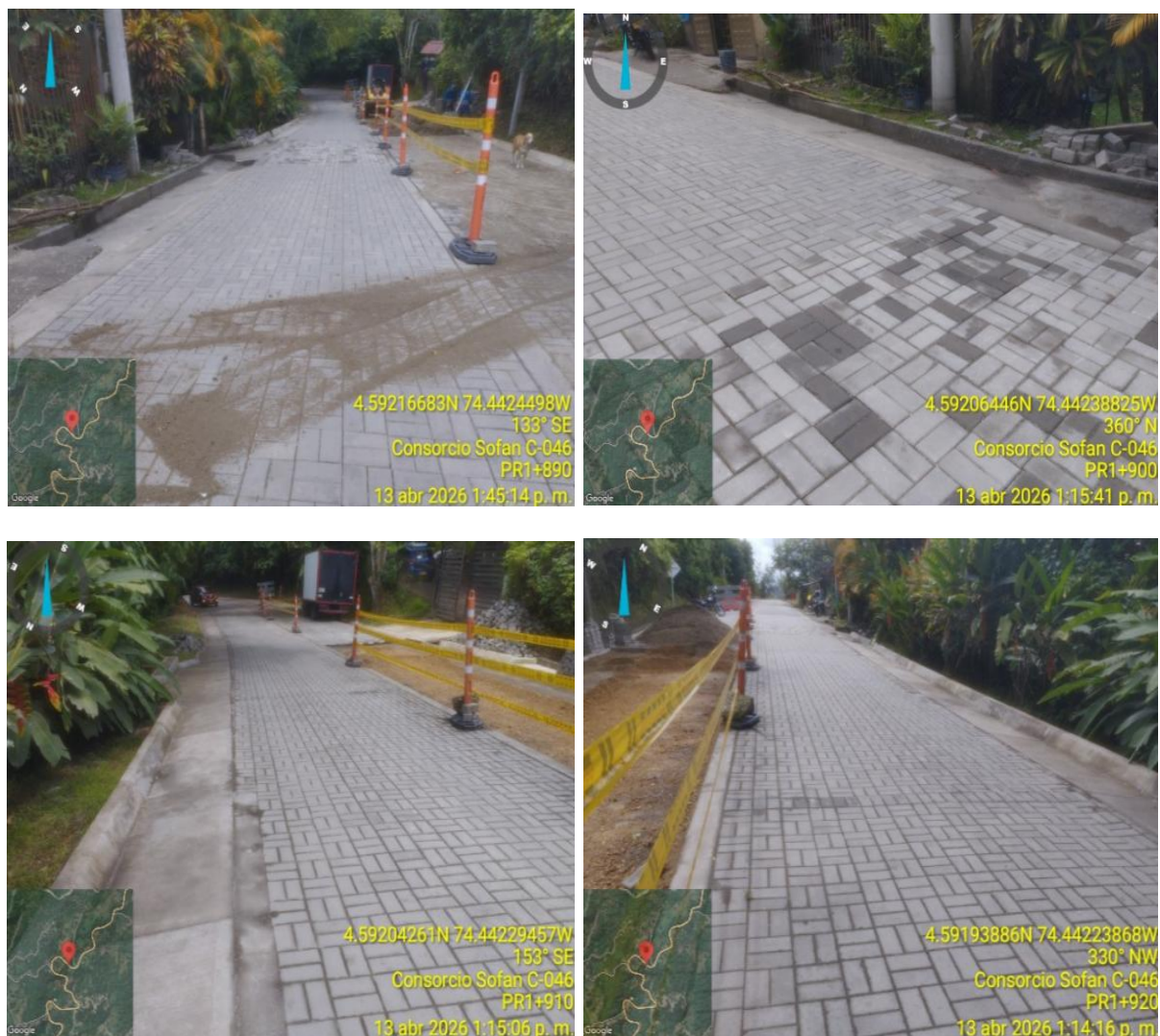
Ilustración 5. PR1+800, Conformación de adoquín.
