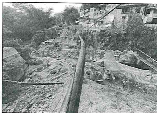
Anexo fotográfico 8: Manejo del caudal caño parrado margen izquierda y derecha caño parrado
