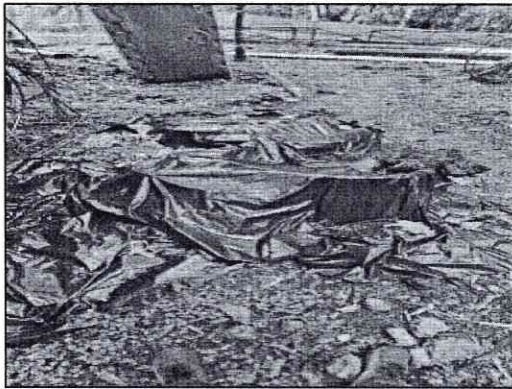
Anexo fotográfico 5: Cubrimiento de elementos de construcción con plástico.
