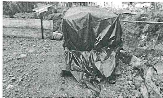
Anexo fotográfico 4: Cubrimiento de elementos de construcción con plástico.
