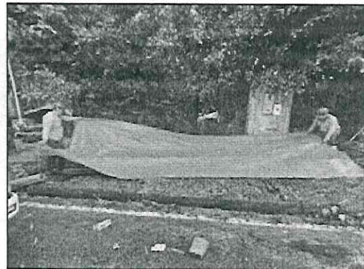
Anexo fotográfico 4: Cubrimiento de elementos de construcción con plástico.
