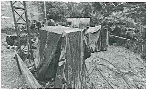
Anexo fotográfico 4: Cubrimiento de elementos de construcción con plástico.
