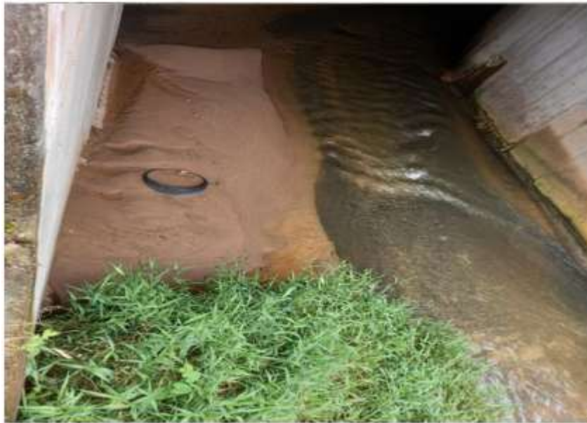
Afluente el Saperito Punto Inicial se observa gran cantidad de material vegetal sobre el cauce (Punto 13) Latitud: N 6°28'15.39768" Longitud: W 75°9'58.15908" Altitud: 1971 msnm
