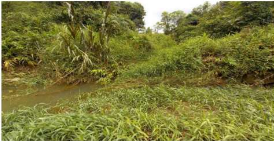
Calle Enríquez: Cerca de la obra hidráulica que pasa debajo de la vía pública se observa gran cantidad de material vegetal además de residuos de construcción sobre el margen derecho del cauce, Se sugiere Construcciones de gaviones u otro tipo de intervención ya que allí se nota socavación del terreno lo cual está comprometiendo el terreno de la parte superior derecha (14 metros de largo x 3,40 metros de alto) (Punto 9) Latitud: N 6°28'26.5314" - Longitud: W 75°9'51.69168" Altitud: 1951 msnm
