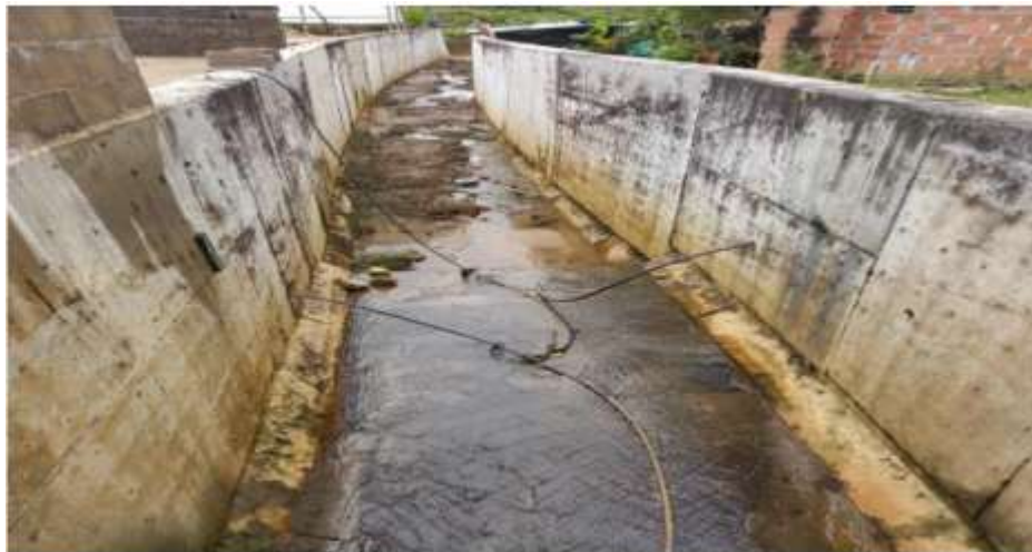
Tramo Final Afluente sin evidencia de material que obstruya (Punto 16) Latitud N 6°27'59" - Longitud: W 75°10'8" Altitud: 1953 msnm
