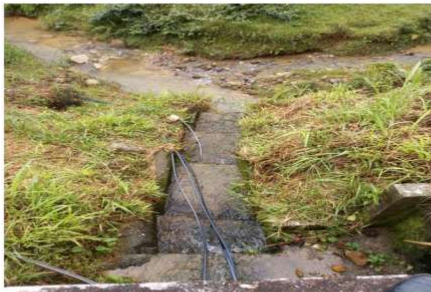
Afluente estación de servicios: Afluente sin evidencia de material que obstruya, obra hidráulica limpia (Punto 5) Latitud: N 6°28'44.82048" - Longitud: W 75°10'2.25624" Altitud: 1951 msnm
