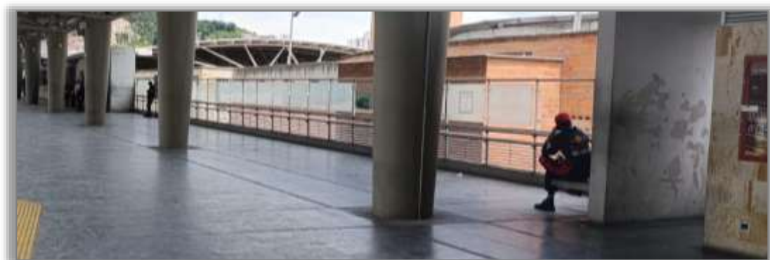
Fotografía 6 Barandas divisorias Alimentación del troncal
