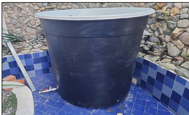
VISTA GENERAL TANQUE DE 5000 LTS
