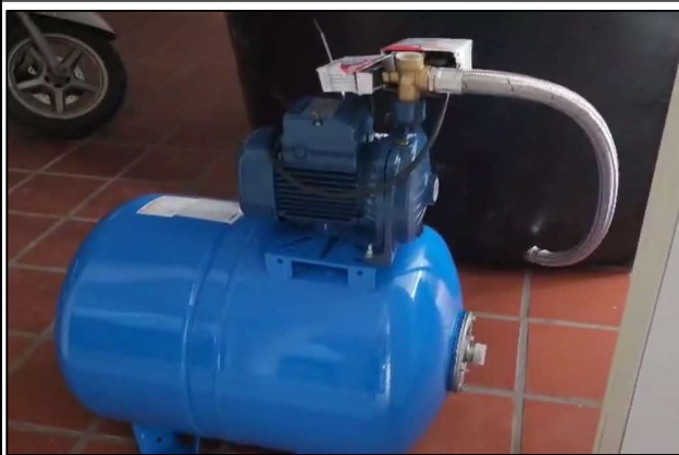
INSTALACIÓN EQUIPO HIDRONEUMÁTICO
