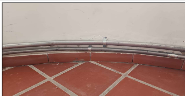
INSTALACIÓN DUCTOS METALICOS PARA PLANTA
