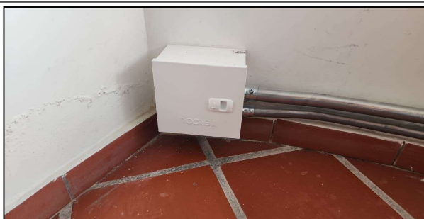
INSTALACIÓN CAJA DE PASO
