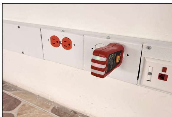
REVISIÓN FUNCIONAMIENTO CABLEADO ELECTRICO
