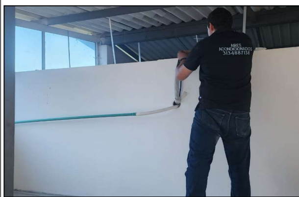
TRASLADO DE AIRES ACONDICIONADOS EXISTENTES
