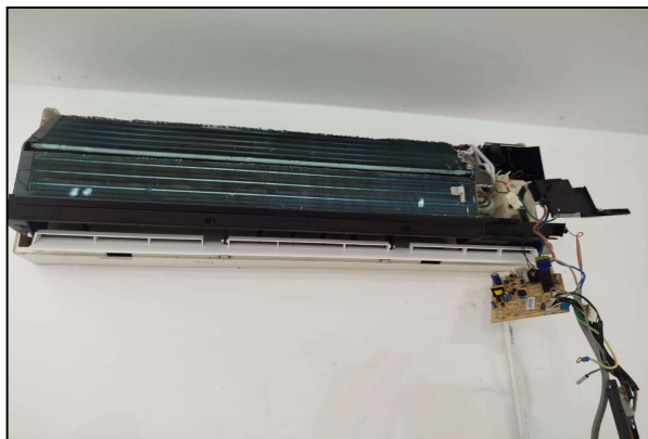
ARREGLO CAMBIO TARJETA ELECTRONICA PARA AIRE ACONDICIONADO
