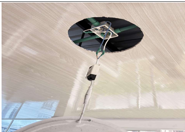
TRABAJOS DE INSTALACIÓN DE LUMINARIAS PARA LA DT
