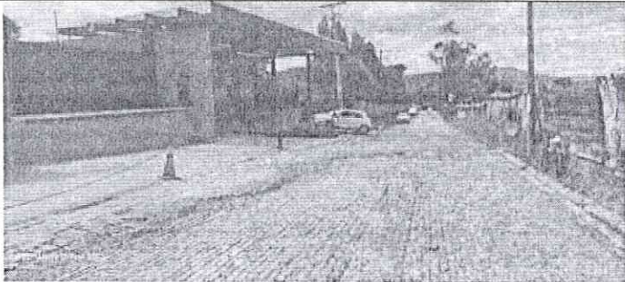
Figura 1.5. Fotografía de la vía en adoquín
