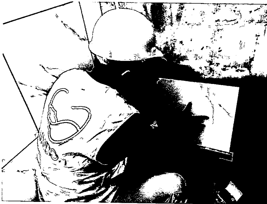
Instalación de Enchape en paredes de baños
