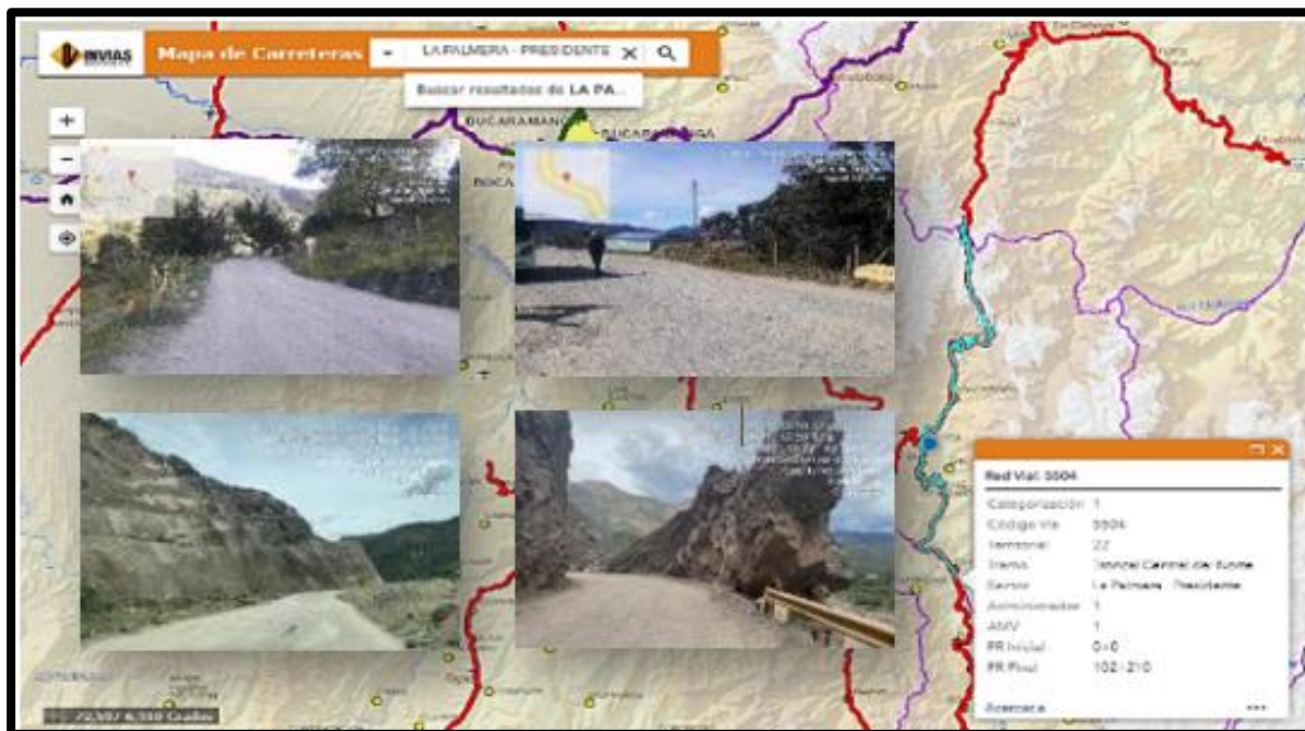
Ilustración 3. Estado inicial de la Ruta 5504.
