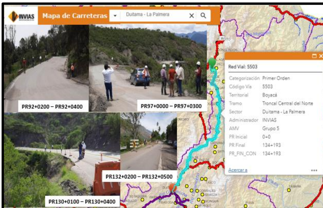
Ilustración 2. Estado inicial de la Ruta 5503.
