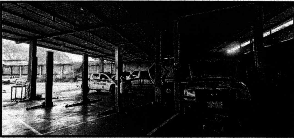
Ilustración 2 - Hangar 2, zona operativa, elevador de vehículos 4 y 5 toneladas
