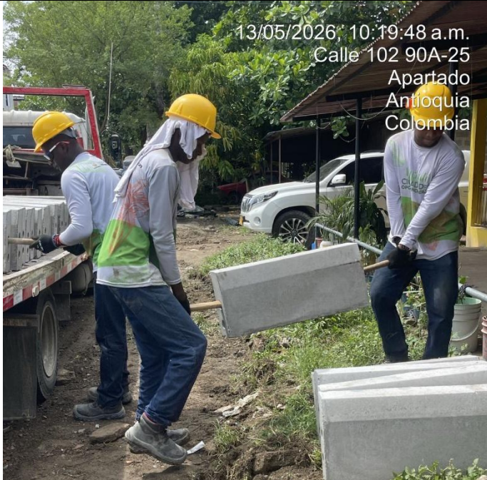
Fotografía 14. Supervisión de manipulación cargas
