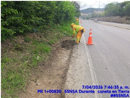
LIMPIEZA DE CUNETA (DURANTE)
