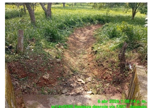
LIMPIEZA DE ENCOLE Y DESCOLE (DESPUES)
