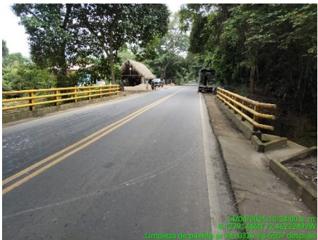
LIMPIEZA DE PUENTE (DESPUES)
