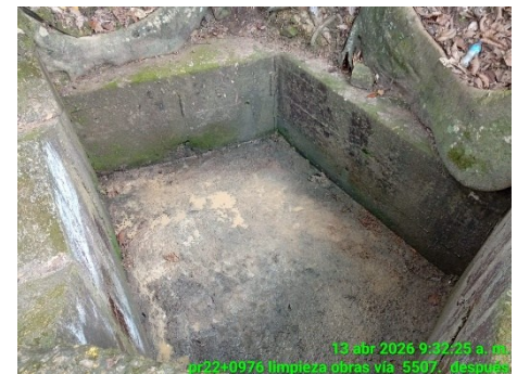
LIMPIEZA DE OBRA (DESPUES)
