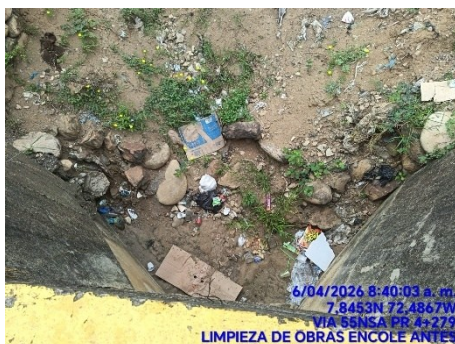
LIMPIEZA DE OBRAS (ANTES)
