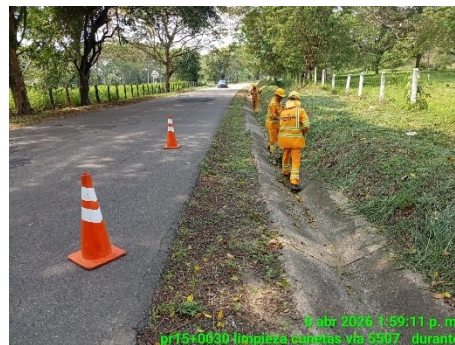
LIMPIEZA DE CUNETAS (DURANTE)
