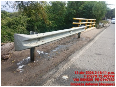
LIMPIEZA DE DEFENSAS (DESPUES)
