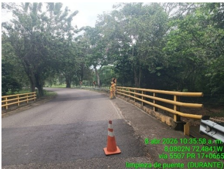
LIMPIEZA DE PONTON (DURANTE)
