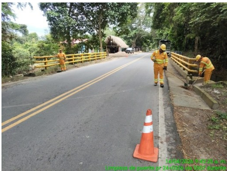
LIMPIEZA DE PUENTE (DURANTE)
