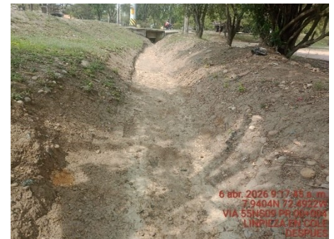
LIMPIEZA DE ENCOLE Y DESCOLE (DESPUES)
