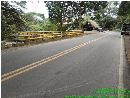
LIMPIEZA DE PUENTE (ANTES)
