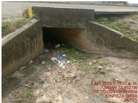
LIMPIEZA DE OBRA (ANTES)
