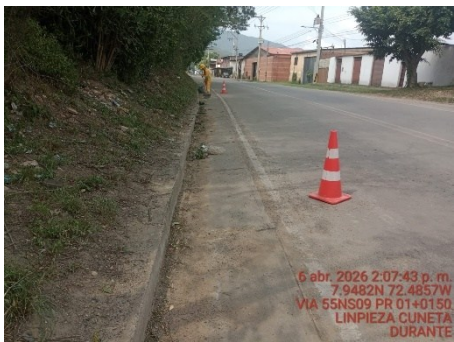
LIMPIEZA DE CUNETAS (DURANTE)
