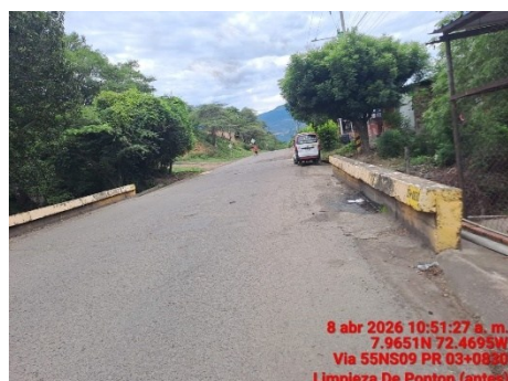
LIMPIEZA DE PONTON (ANTES)
