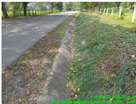
LIMPIEZA DE CUNETAS (ANTES)
