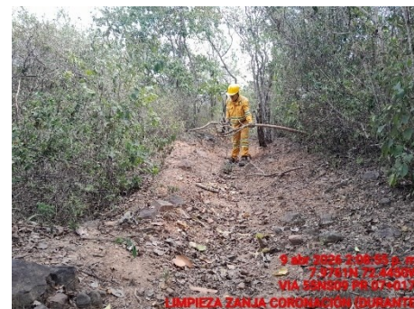
LIMPIEZA DE ZANJA DE CORONACION (DURANTE)
