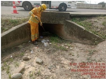
LIMPIEZA DE OBRA (DURANTE)
