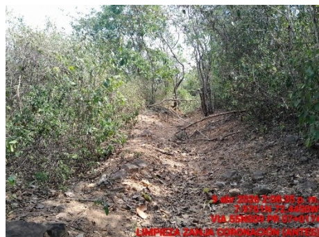
LIMPIEZA DE ZANJA DE CORONACION (ANTES)
