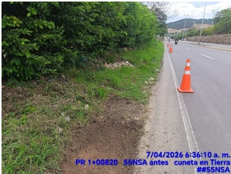
LIMPIEZA DE CUNETA (ANTES)
