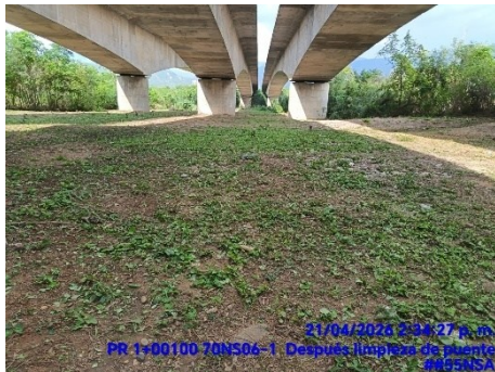
LIMPIEZA DE PUENTE (DESPUES)
