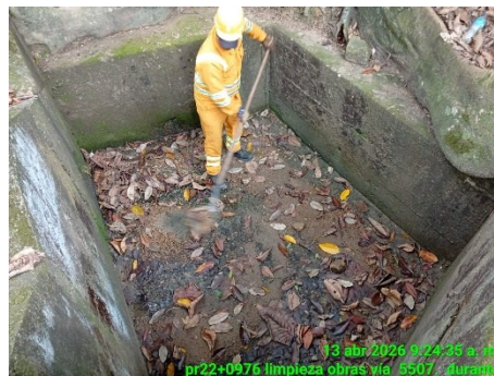
LIMPIEZA DE OBRA (DURANTE)
