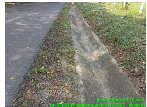
LIMPIEZA DE CUNETAS (DESPUES)
