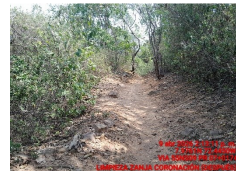
LIMPIEZA DE ZANJA DE CORONACION (DESPUES)
