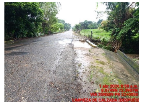
LIMPIEZA DE CALZADA (DESPUES)
