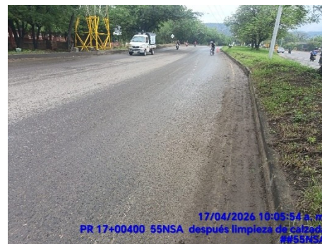
LIMPIEZA DE BERMA (DESPUES)
