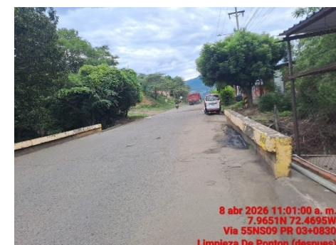
LIMPIEZA DE PONTON (DESPUES)
