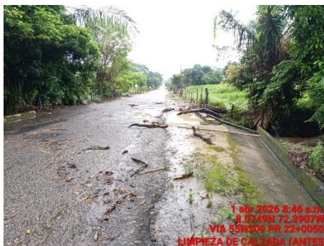
LIMPIEZA DE CALZADA (ANTES)
