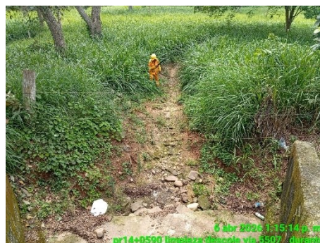
LIMPIEZA DE ENCOLE Y DESCOLE (DURANTE)
