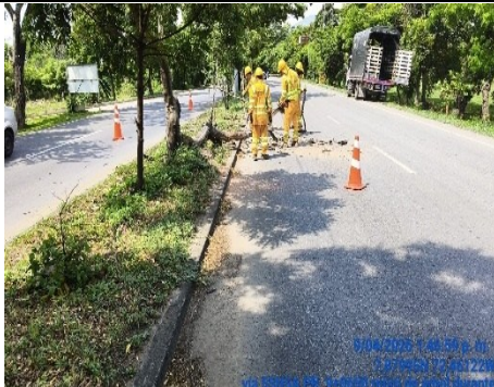
RETIRO DE ARBOL (DURANTE)
