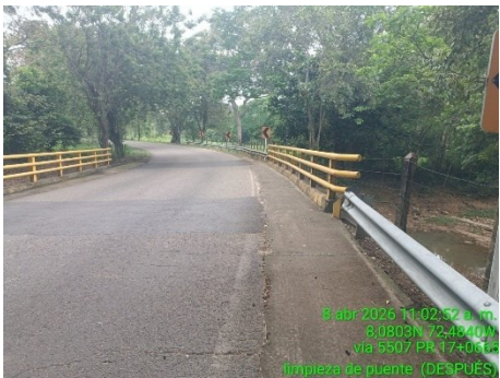
LIMPIEZA DE PONTON (DESPUES)
