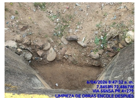
LIMPIEZA DE OBRAS (DESPUES)
