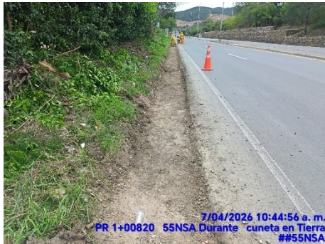
LIMPIEZA DE CUNETA (DESPUES)
