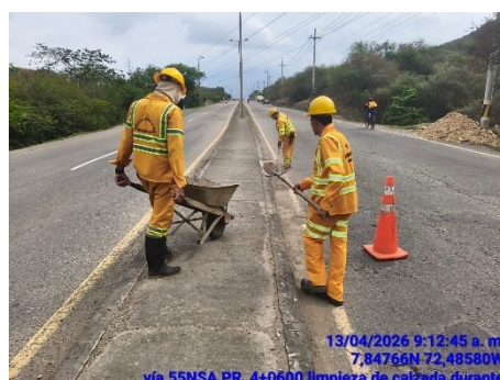
LIMPIEZA DE CALZADA (DURANTE)
