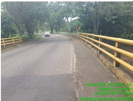
LIMPIEZA DE PONTON (ANTES)
