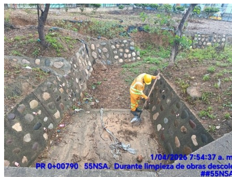
LIMPIEZA DE ENCOLE Y DESCOLE (DURANTE)
