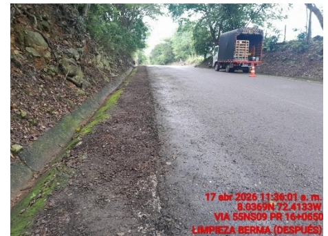
LIMPIEZA DE BERMA (DESPUES)
