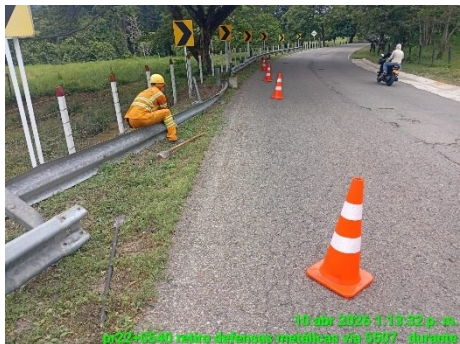
RETIRO DE DEFENSAS (DURANTE)
