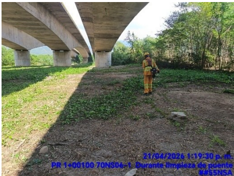
LIMPIEZA DE PUENTE (DURANTE)
