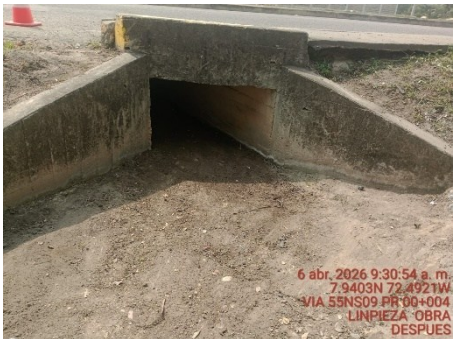
LIMPIEZA DE OBRA (DESPUES)
