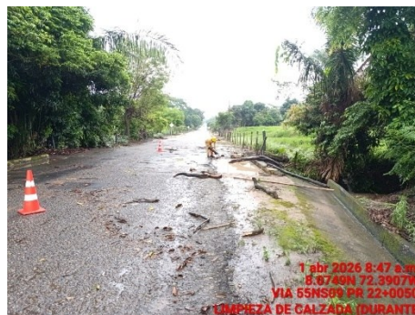
LIMPIEZA DE CALZADA (DURANTE)
