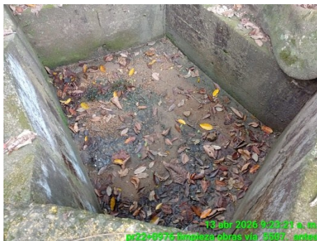
LIMPIEZA DE OBRA (ANTES)
