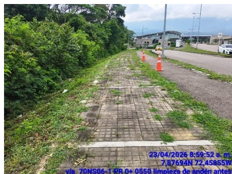
LIMPIEZA DE ANDEN (ANTES)
