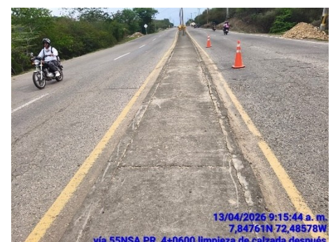
LIMPIEZA DE CALZADA (DESPUES)
