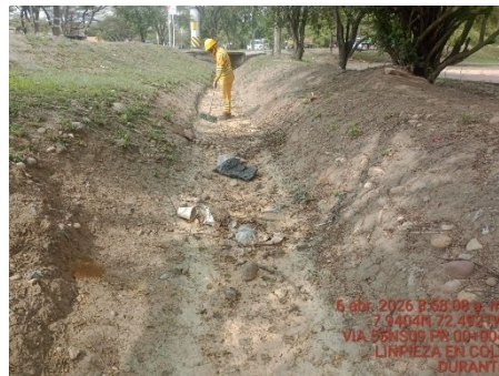
LIMPIEZA DE ENCOLE Y DESCOLE (DURANTE)
