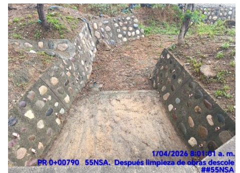
LIMPIEZA DE ENCOLE Y DESCOLE (DESPUES)
