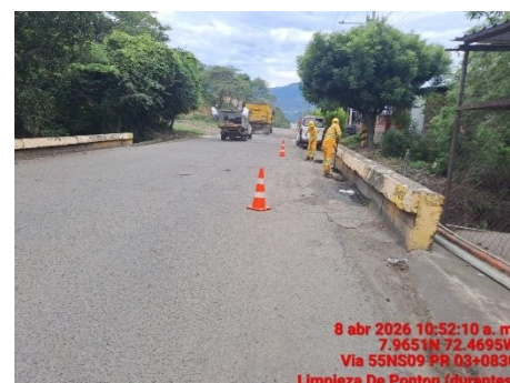
LIMPIEZA DE PONTON (DURANTE)
