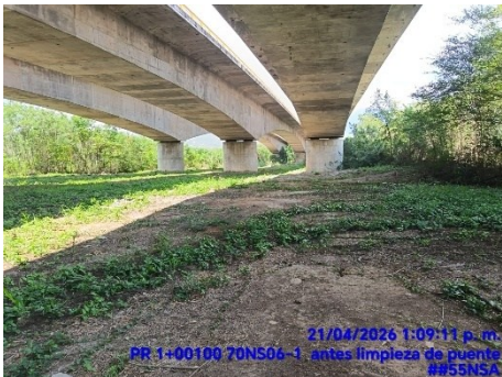
LIMPIEZA DE PUENTE (ANTES)
