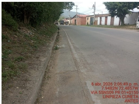
LIMPIEZA DE CUNETAS (ANTES)
