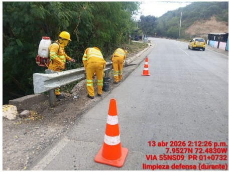
LIMPIEZA DE DEFENSAS (DURANTE)
