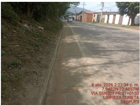
LIMPIEZA DE CUNETAS (DESPUES)
