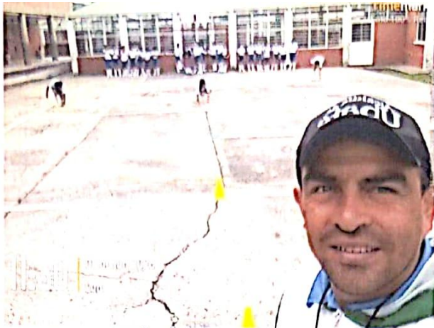
REGISTRO FOTOGRÁFICO: N° 23 LUGAR: COLEGIO SANTA MARIA FECHA: 01/06/2026
