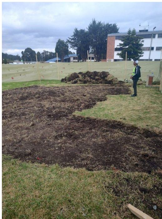
Foto 3. Descapote H=0.20 m, incluye retiro de sobrantes.
