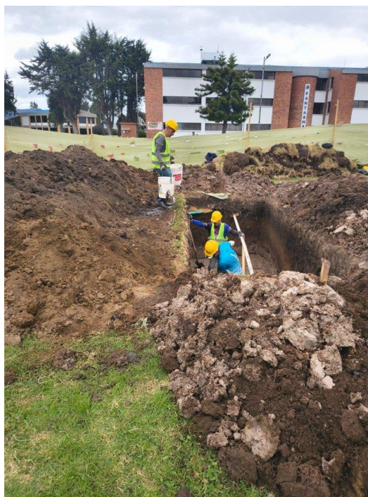
Foto 5. Excavación manual en terreno consistente.
