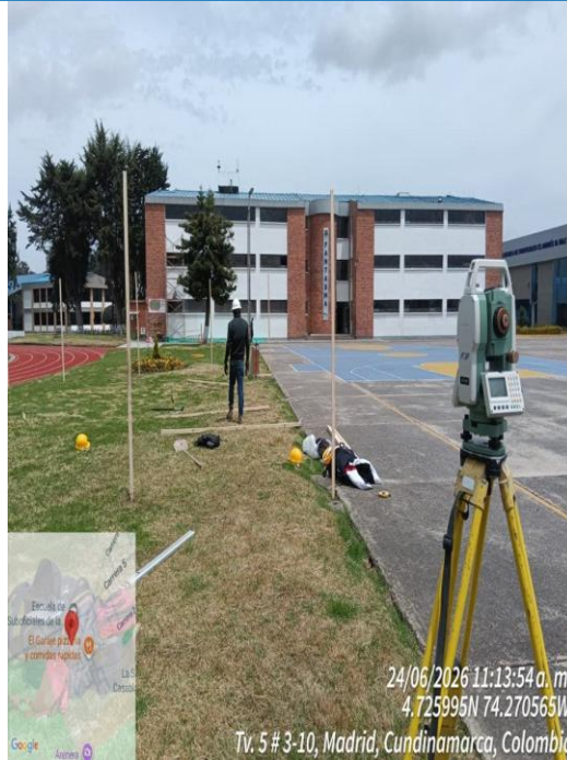
Foto 2. Localización y replanteo con elementos de precisión (24/06/2026, Madrid, Cundinamarca).
