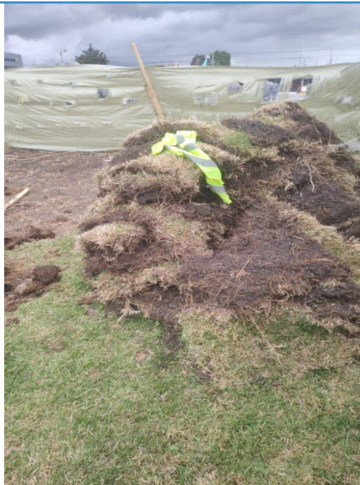
Foto 4. Descapote - acopio de césped y sobrantes.
