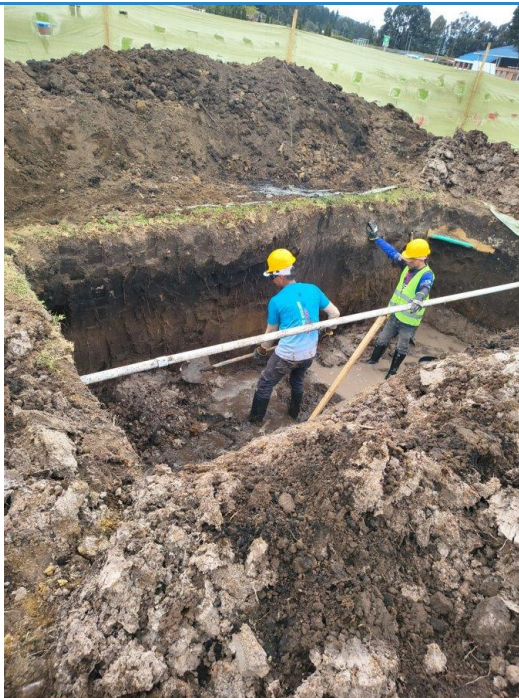
Foto 6. Excavación manual en terreno consistente.
