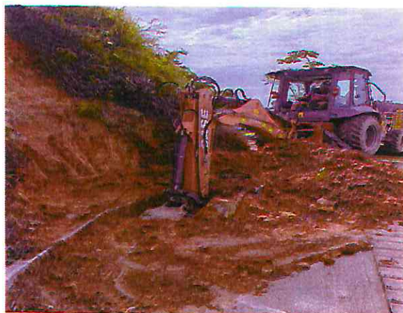
DESTAPONAMIENTO VDA CIELO ROTO ALCANTARILLA 19 DE JUNIO DEL 2026
