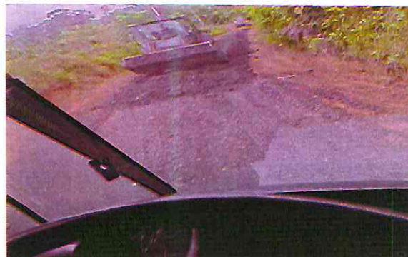
ADECUACION VIA KM 25 - BORUGAS 29 DE MAYO DEL 2026
