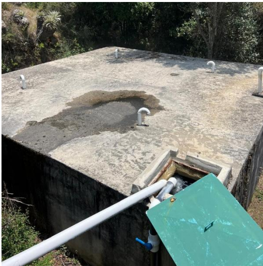
Planta de Tratamiento Compacta
