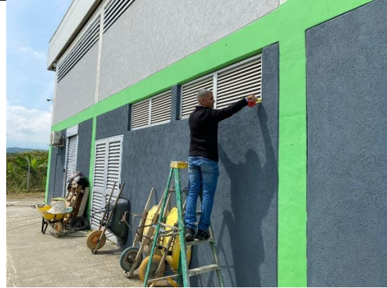
Fecha: 1/06/2026 medición para instalación campana extractora laboratorio ambiental la samaria.
