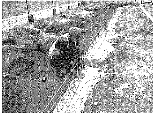
ACERO REFUERZO FLEJADO 60000 PSI 420Mpa
