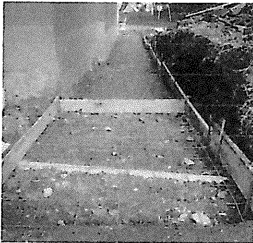
Ilustración 3: Durante de ejecutada la obra.
