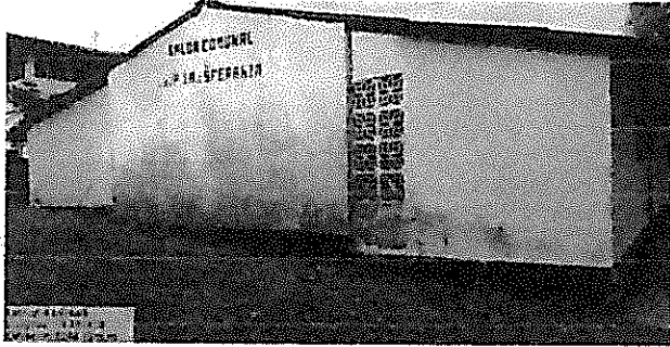
Ilustración 1: Antes del inicio de obra
