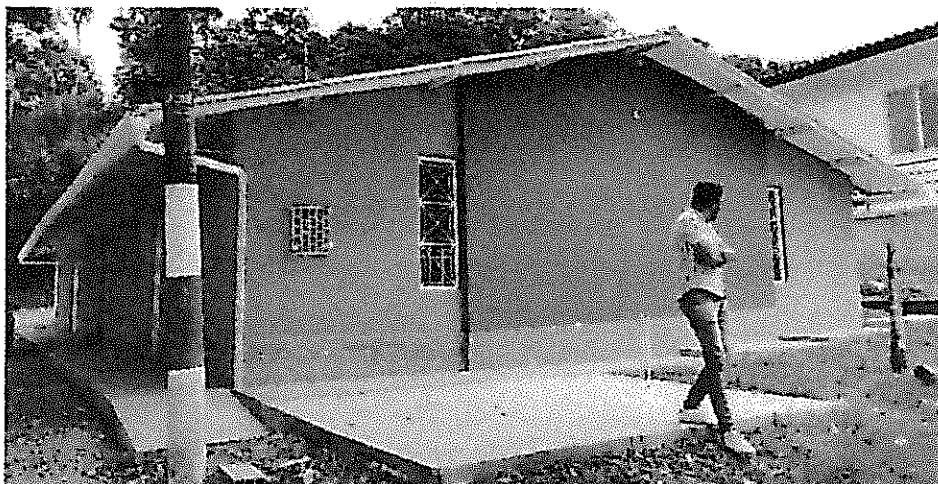
Ilustración 5- terminada la obra.
