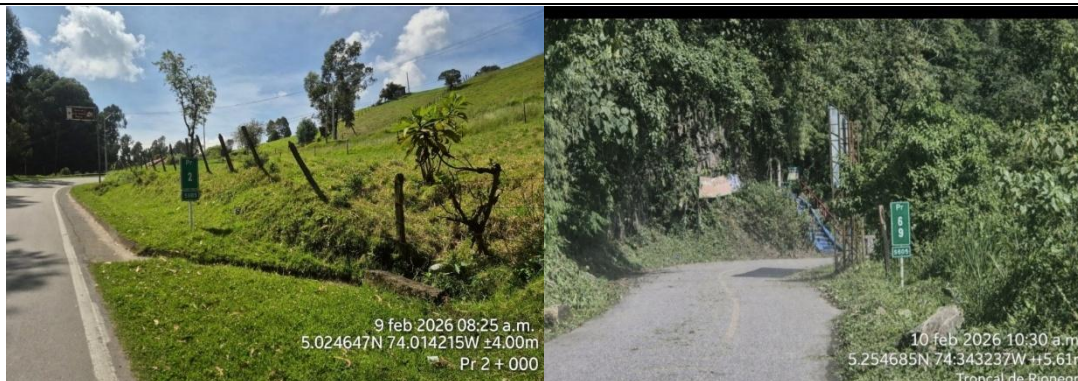
Ilustración 4. Estado inicial troncal Pacho. Fuente Propia Interventoría
