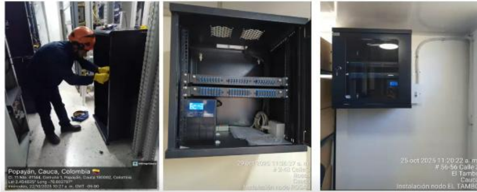
Imagen 4. Instalación de equipos y nodos. Fuente: presentación gobernación de Cauca.
