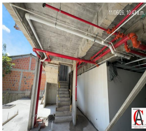
Fotografía No. 2. instalación de tubería rci en primer piso.
