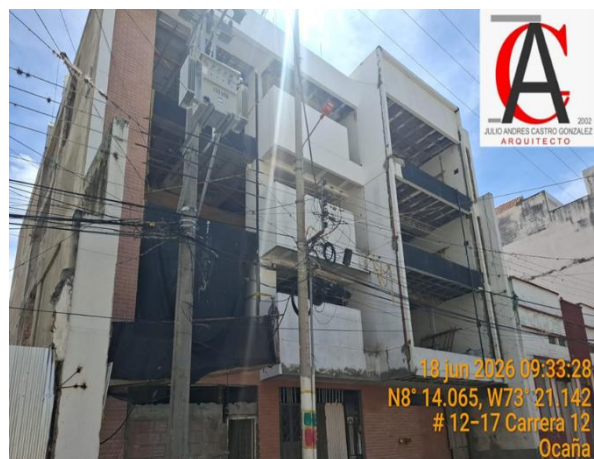
Fotografía No. 7. ESTRUCTURA METÁLICA EN FACHADA
