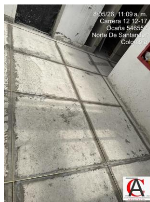
Fotografía No. 2. Instalación de dilataciones metálicas para piso en granito, piso 3.
