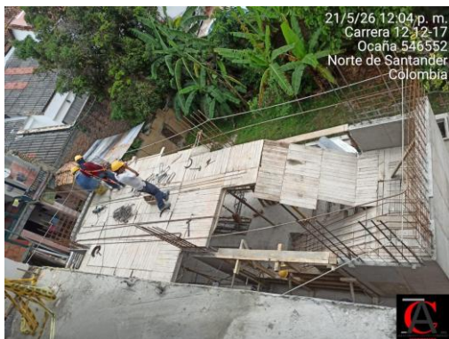
Fotografía No. 11. Formaleta para construcción de placa N+5.14, edificio anexo.
