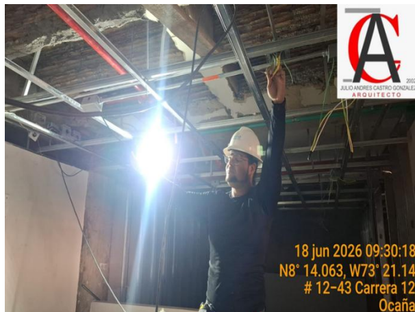
Fotografía No. 13. energizado de tomas aéreas 1 piso
