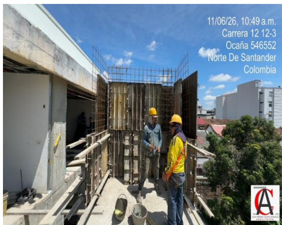
Fotografía No. 5. ARMADO DE ACERO Y ENCOFRADO DE MUROS 2 Y 5 DE NIVEL 8,62 A 11,46
