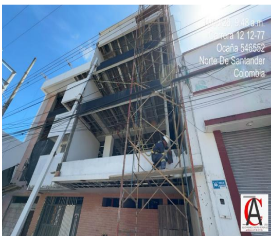
Fotografía No. 1. anclajes de estructura metálica en fachada
