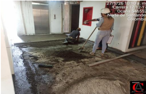
Fotografía No. 13. Actividad de mortero de contrapiso, piso 2.
