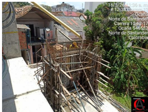
Fotografía No. 8. Construcción de muro en concreto, edificio anexo.
