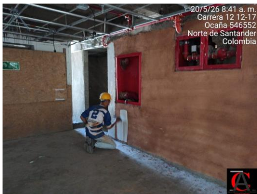
Fotografía No. 9. Actividades de estuco sobre muro, piso 2.
