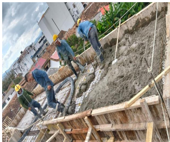
Fotografía No. 16. Vaciado de losa nivel 11,46m.
