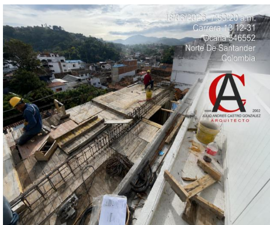
Fotografía No. 11. Formaleta para construcción de placa N+5.14, edificio anexo.
