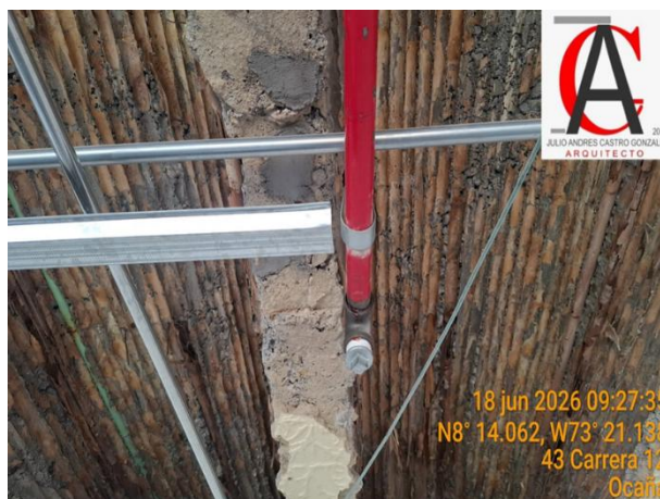
Fotografía No. 8. INSTALACION DE TAPONES RCI EN PRIMER PISO PARA REALIZAR PRUEBAS
