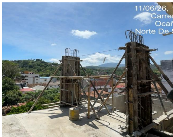
Fotografía No. 6. VACIADO DE MUROS 3 Y 4 DEL NIVEL 8,62 A NIVEL 11,46
