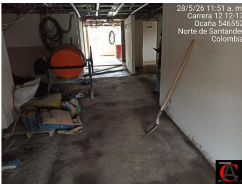
Fotografía No. 15. Contrapiso terminado, piso 2.
