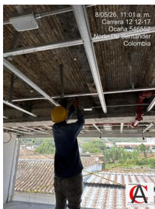
Fotografía No. 1. Instalación de estructura metálica para cielo raso, piso 2.
