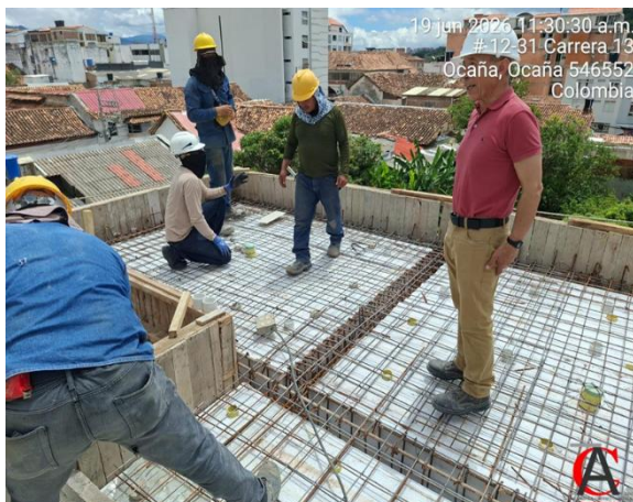
Fotografía No. 15. Instalación de casetones, Armado de acero de refuerzo para vaciado de losa nivel 11,46m
