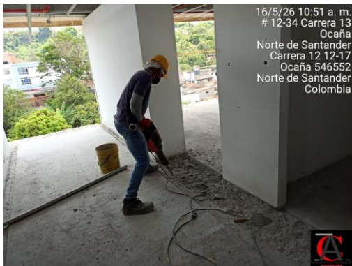
Fotografía No. 7. Demolición de piso para nivelar, piso 3.
