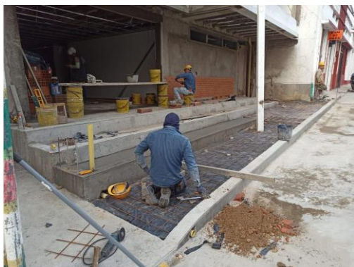
Fotografía No. 3. Instalación de malla electrosoldada para andén.
