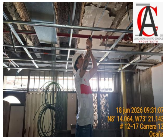
Fotografía No. 14. energizado de tomas aéreas 1 piso
