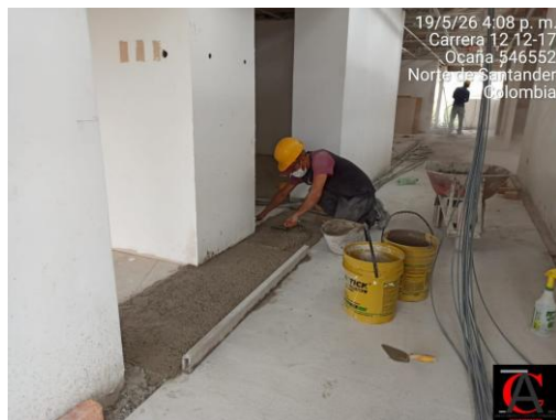
Fotografía No. 12. Trabajos de piso en granito, piso 3.
