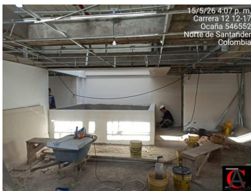
Fotografía No. 5. Actividades de estuco sobre piso 3.
