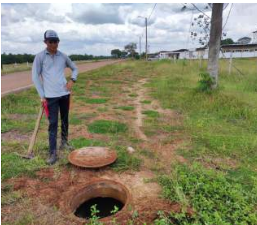
Fotografía 2. Inspección de pozos - Mapiripán, Meta. (Fuente propia).
