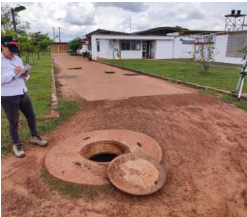
Fotografía 1. Inspección de pozos – Mapiripán, Meta. (Fuente propia).
