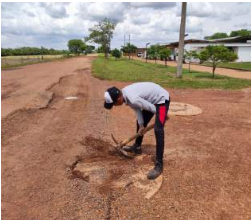
Fotografía 3. Inspección de pozos - Mapiripán, Meta. (Fuente propia).
