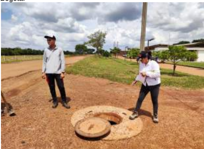
Ilustración 6. Inspección de pozos – Mapiripan – Meta. (Fuente propia).
