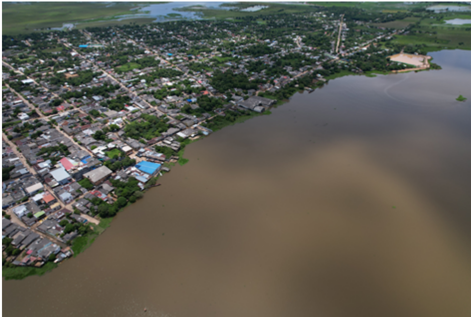
Obras noviembre de 2025
