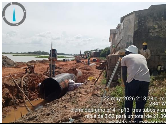
Instalación de tubería de 1100mm (43")
