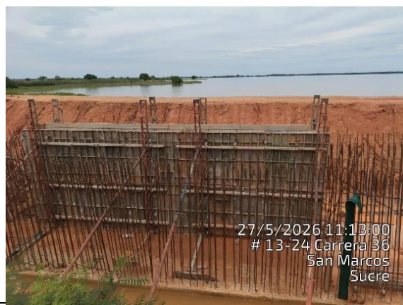
Vaciado de concreto 4 módulos del boxculvert P4A-P4
