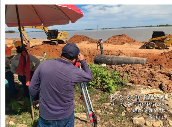
Verificacion de niveles y pendientes tuberia de 1100mm
