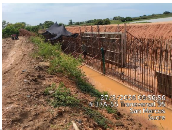
Liberación de aceros de refuerzo boxculvert P4A-P4
