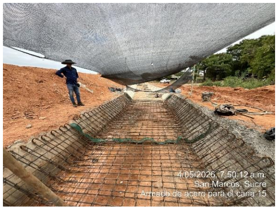
Liberacion de acero losa inferior y muros- canal 15
