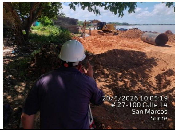
Chequeo y liberación por niveles de los tubos # 7 y 8 entre pozos 21 y 20
