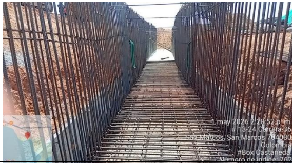
Liberacion de acero losa inferior -carcamo K0+000 - K0+080 (PONDAJE 4-4A)
