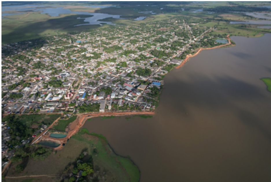
Obras enero de 2026
