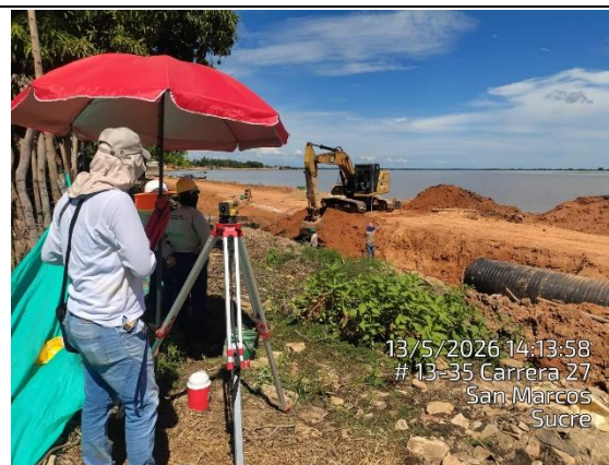
Verificacion de niveles y pendientes tuberia de 1100mm
