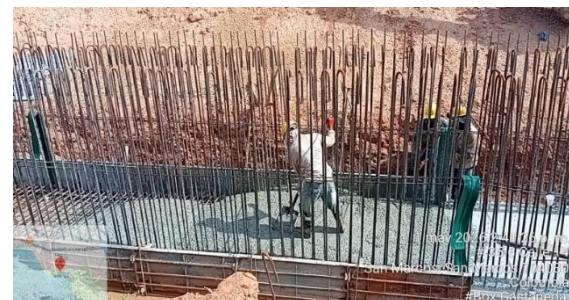
vaciado de concreto placa inferior - carcamo K0+000 - K0+080 (PONDAJE 4-4A)
