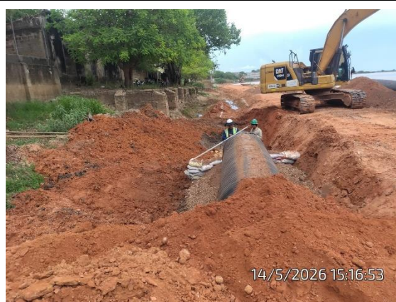
Excavacion e instalacion de tuberia HDPE de 1100mm
