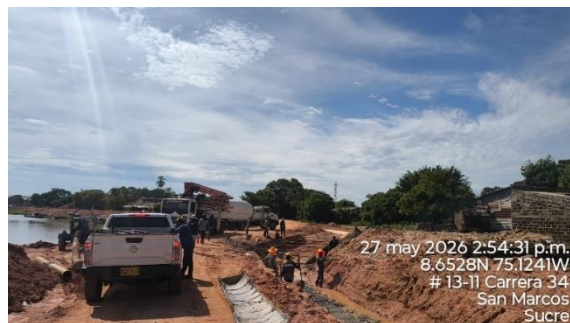
Vaciado de concreto - canal 15
