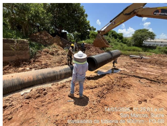
Excavacion e instalacion de tuberia HDPE de 900mm
