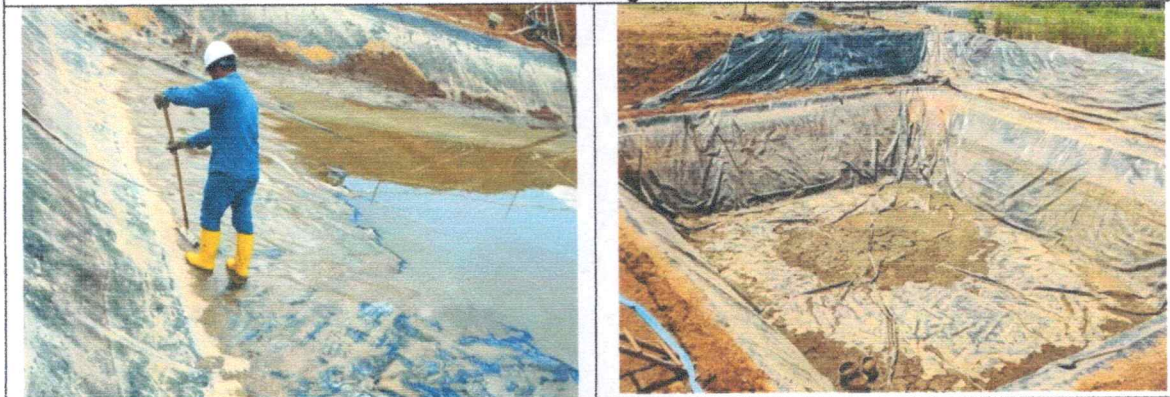
Extracción de lodos en laguna de oxidación.
