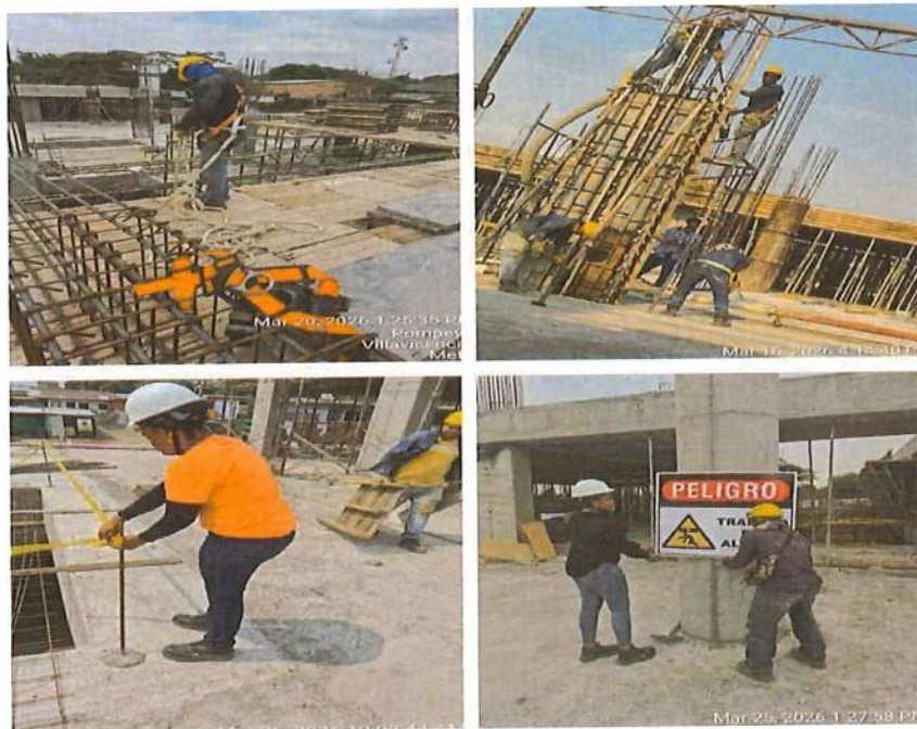
Foto No 5 Aseguramiento y acompañamiento en las actividades en obra (Anexo 4).
