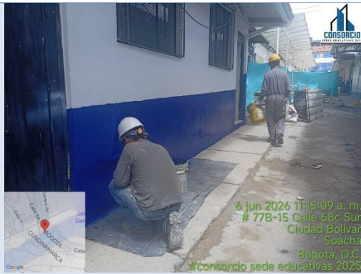
Aplicación de pintura exteriores en zona de aulas.
