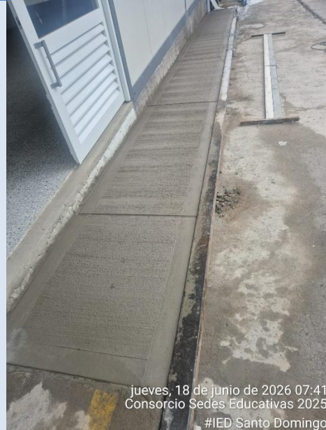
adecuación de placa de concreto y corte para andenes de circulación en área de comedor
