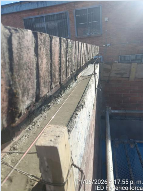
Adecuacion de vigas de amarre en zona de aulas y profesores. Incluye acero de refuerzo
