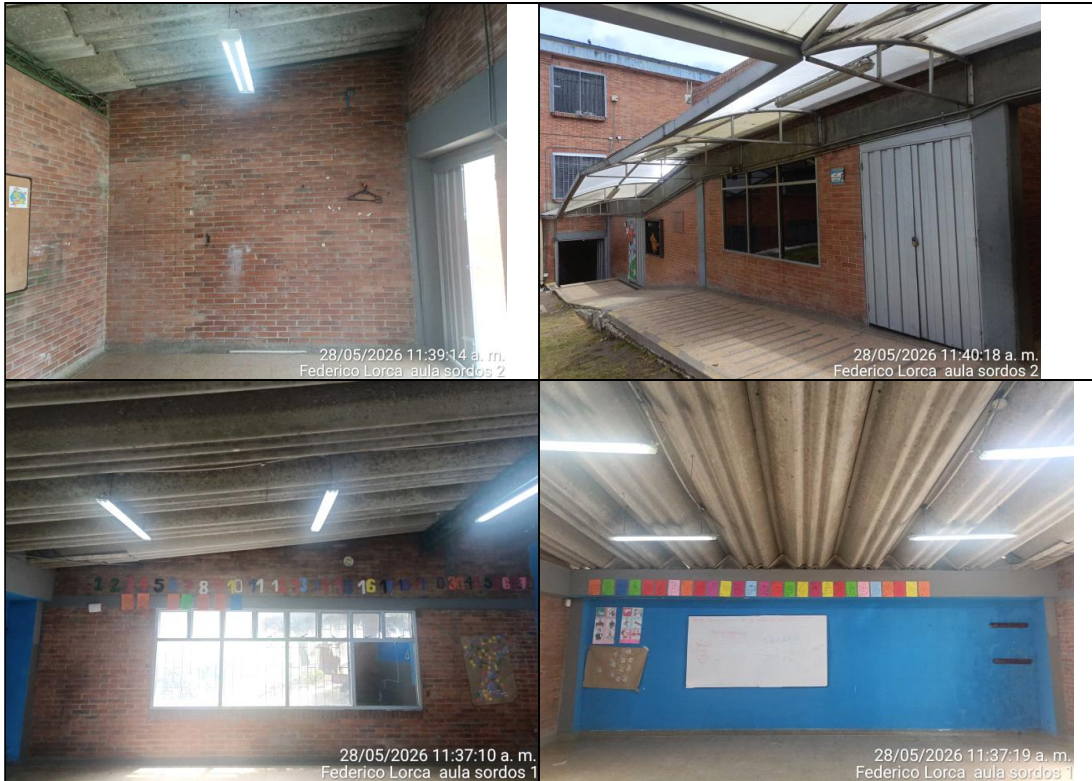
CUBIERTA DE AULAS Y CUARTO DE MAQUINAS
