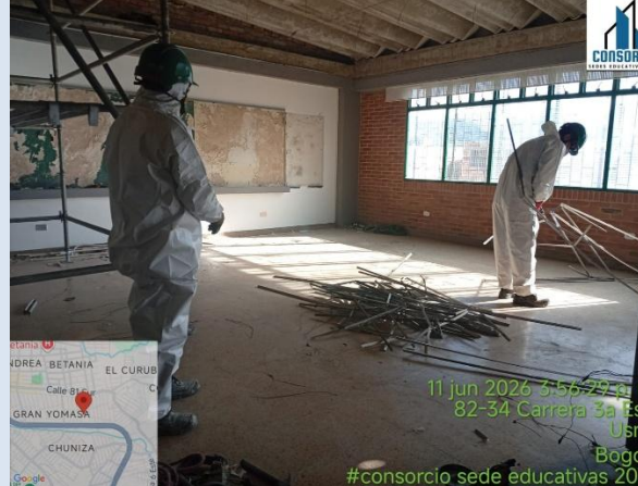
Desmote de estructura y cubierta existen en aulas y sala de profesores.
