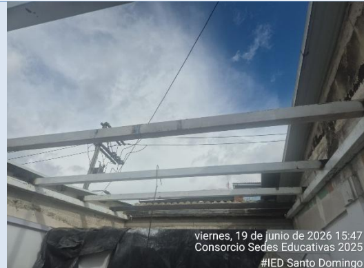
Suministro e instalación de estructura metálica para área de coordinación
