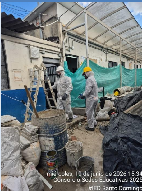
Desmonte de cubierta y cielo raso existente en coordinación.
