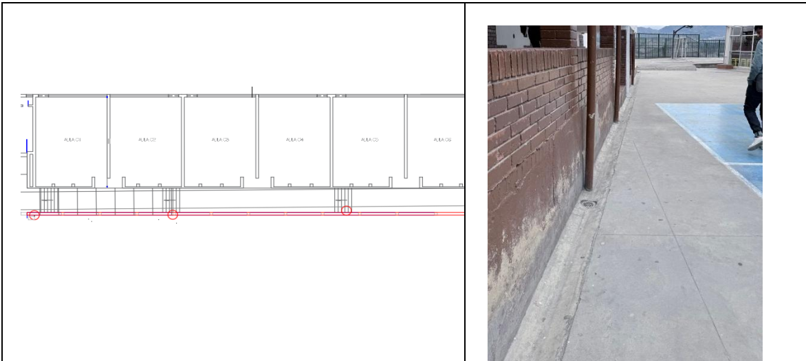
Suministro e instalación de cárcamos
