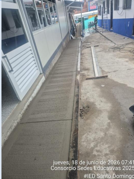
adecuación de placa de concreto y corte para andenes de circulación en área de comedor
