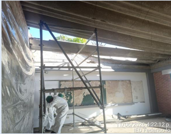
Desmote de estructura y cubierta existen en aulas y sala de profesores.
