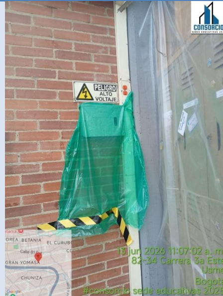
Protección de elementos con plástico.
