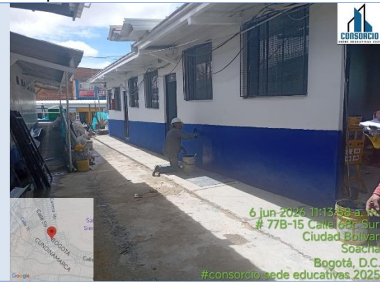
Aplicación de pintura exteriores en zona de aulas.
