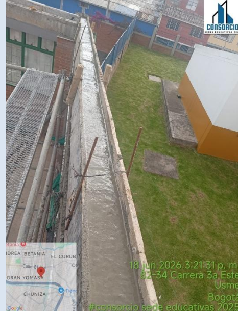
Adecuacion de vigas de amarre en zona de aulas y profesores. Incluye acero de refuerzo
