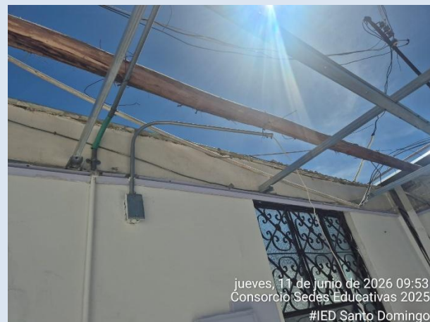
Desmonte de cubierta y cielo raso existente en coordinación.
