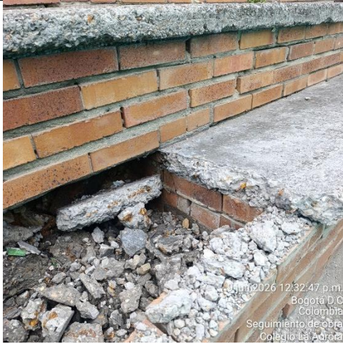
Ilustración No.35: Evidencia muros internos transversales para apoyo de placas
