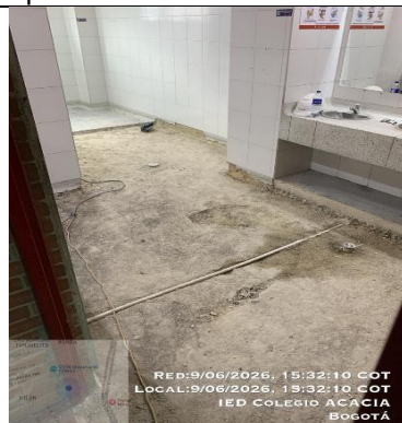
Ilustración No.18: Demolición de acabado y alistado de piso
