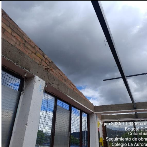
Ilustración No.25: Demolición encorizado de cubierta y desmonte de cubierta
