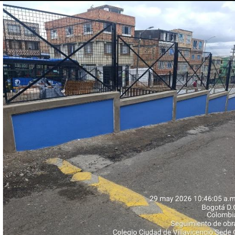
Ilustración No.30: Aplicación de pintura azul pacifico para acabado final de muros y gris basalto en vigas y columnas
