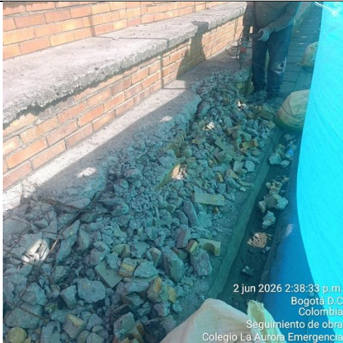
Ilustración No.7: Demolición de placa y muro en mampostería
