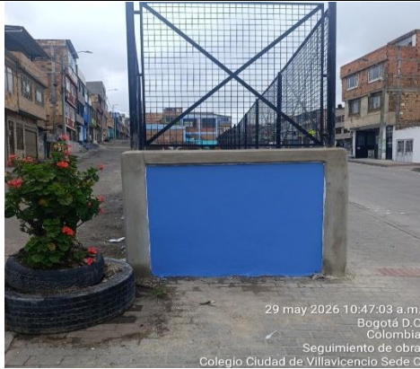
Ilustración No.31: Aplicación de pintura azul pacifico para acabado final de muros y gris basalto en vigas y columnas
