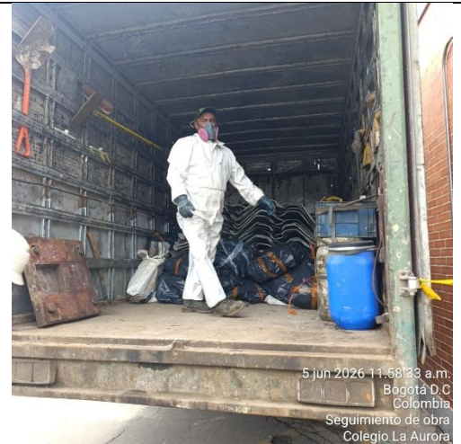
Ilustración No.19: Disposición final teja de asbesto
