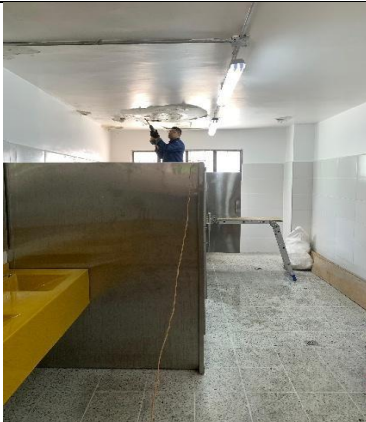
Ilustración No.11: Demolición de losa baño niñas primer piso
