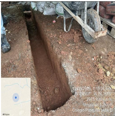
Ilustración No.166: Excavación para ciclópe en eje
