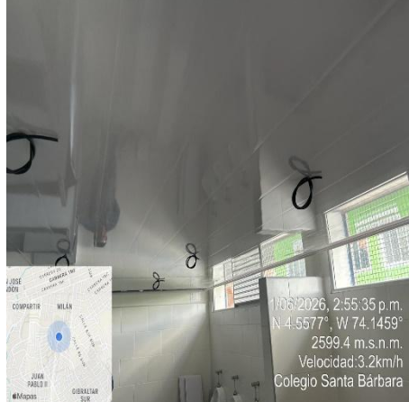
Ilustración No.329: Suministro e instalación de techo en PVC.
