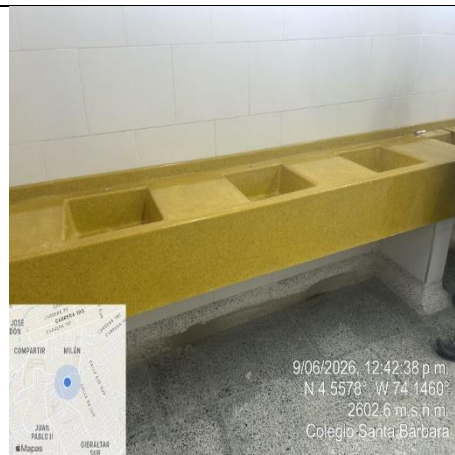
Ilustración No.317: Suministro e instalación de
