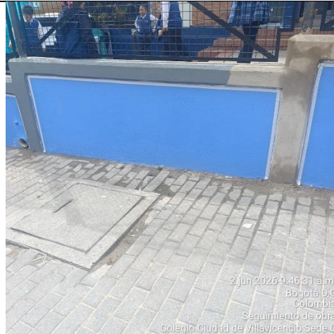
Ilustración No.28: Aplicación de pintura azul pacifico para acabado final de muros y gris basalto en vigas y columnas
