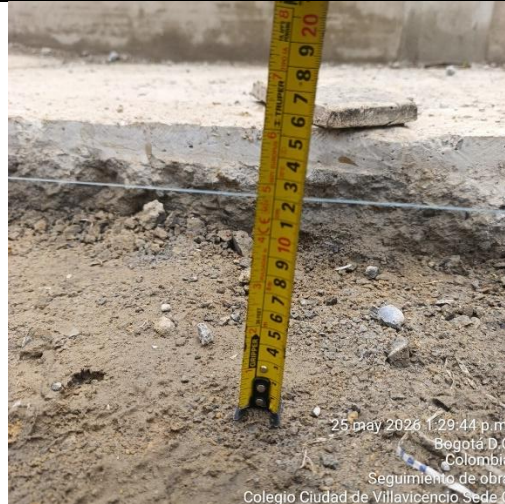
Ilustración No.10: Toma de niveles para determinar pendiente 1.5%
