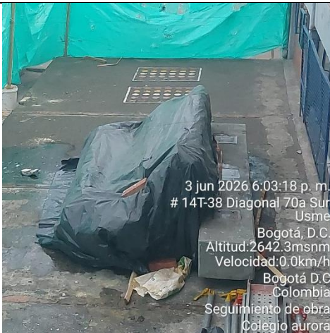
Ilustración No.31: Embalaje en plástico para teja en asbesto en punto de acopio
