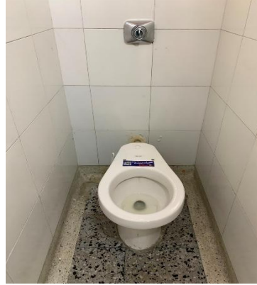
Ilustración No.20: desmonte y desconexion de aparatos sanitarios
