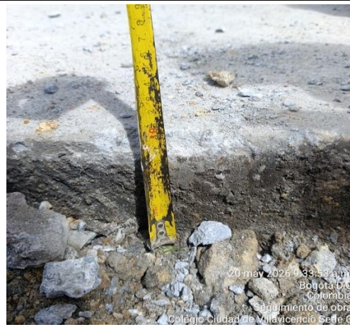
Ilustración No.4: Demolición de placa en zona recreativa 3
