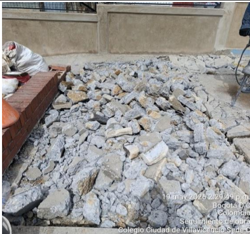
Ilustración No.3: Demolición de placa en zona recreativa 3
