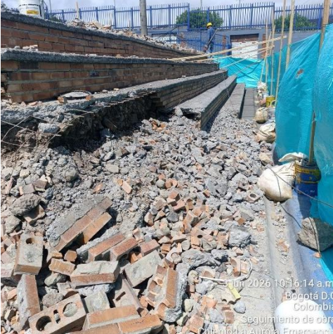
Ilustración No.25: Demolición de placa y muro en
