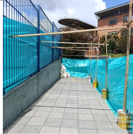
Ilustración No.6: Cerramiento punto de acopio
