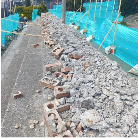
Ilustración No.17: Demolición de placa y muro en mampostería
