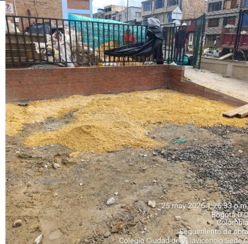
Ilustración No.12: Relleno con subbase granular (actividad suspendida por lluvias)
