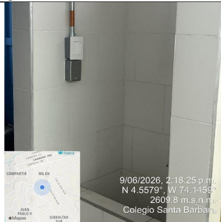
Ilustración No.299: Suministro e instalación de interruptor sencillo.
