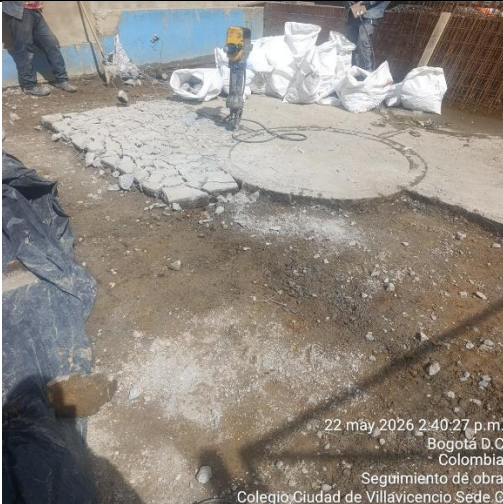
Ilustración No.9: Demolición de placa en zona recreativa 2
