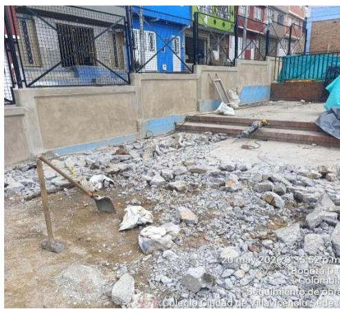
Ilustración No.4: Demolición de placa en zona recreativa 3
