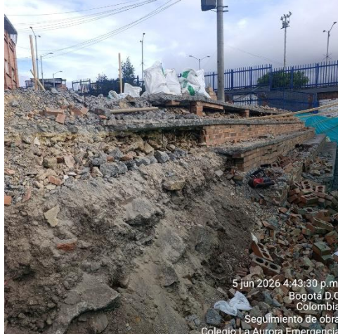
Ilustración No.26: Evidencia de relleno de gradería
