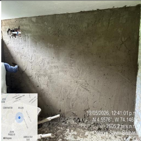
Ilustración No.324: Pañete impermeabilizado.
