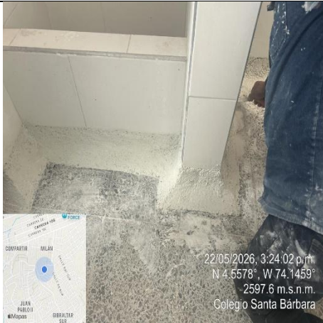
Ilustración No.312: Instalación de media caña en granito.
