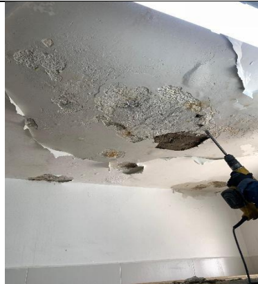
Ilustración No.12: Demolición de losa baño niñas primer piso
