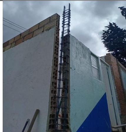
Ilustración No.26: Suministro e instalación acero de refuerzo 60000 PSI.
