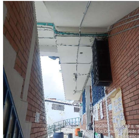
Ilustración No.8: Instalación de iluminarias pasillo primer piso
