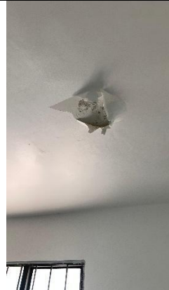
Ilustración No.10: Demolición de losa baño niñas primer piso
