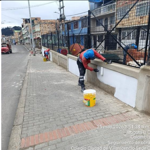
Ilustración No.21: Aplicación de pintura para fondo en muros
