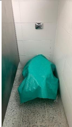
Ilustración No.3: cubrimiento de sanitarios
