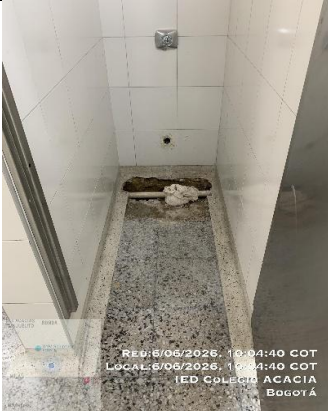
Ilustración No.21: desmonte y desconexion de aparatos sanitarios
