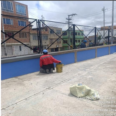
Ilustración No.25: Aplicación de pintura azul pacifico para acabado final
