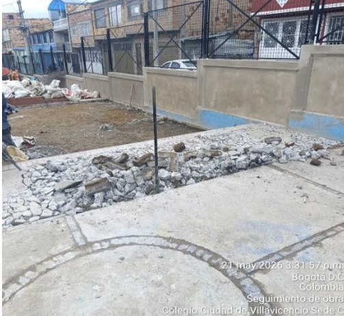
Ilustración No.5: Demolición de placa en zona recreativa 3
