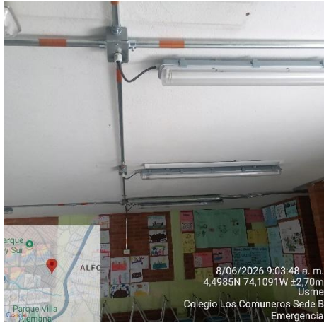
Ilustración No.5: Instalación de iluminarias salón 201
