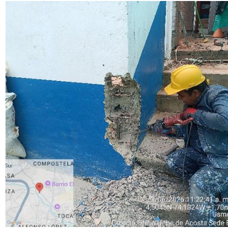
Ilustración No.16: Demolición en estructura en concreto
