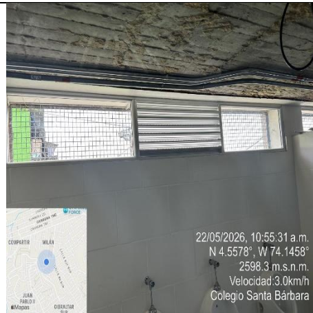
Ilustración No.315: Suministro e instalación de ventanería en aluminio.
