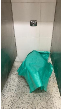
Ilustración No.5: cubrimiento de sanitarios
