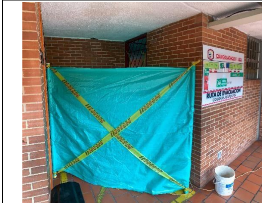
Ilustración No.1: Cerramiento áreas a intervenir
