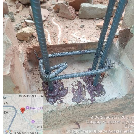
Ilustración No.14: Perforación y anclaje de refuerzo
