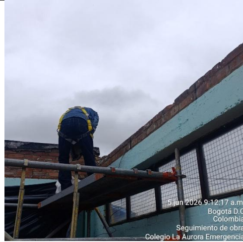
Ilustración No.22: Demolición encorizado de cubierta y cuchillas
