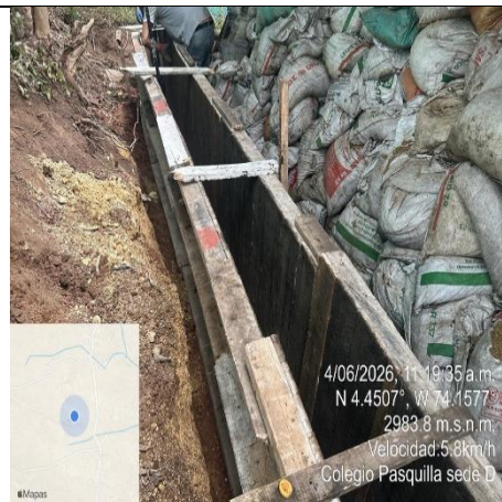
Ilustración No.167: Encofrado para ciclópe y
