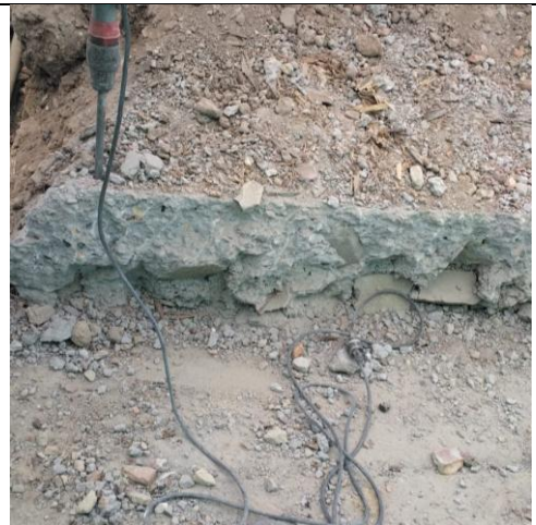
Ilustración No.33: Evidencia muro en concreto 10cm
