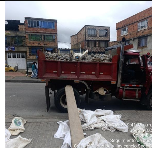
Ilustración No.18: Recolección de escombros a destino final
