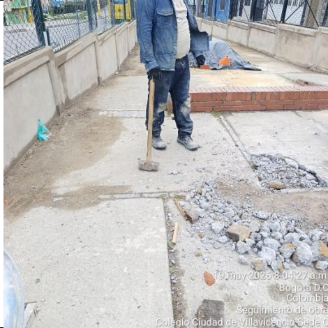
Ilustración No.1: Demolición de placa en zona recreativa 3
