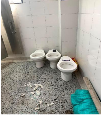
Ilustración No.19: desmonte y desconexion de aparatos sanitarios
