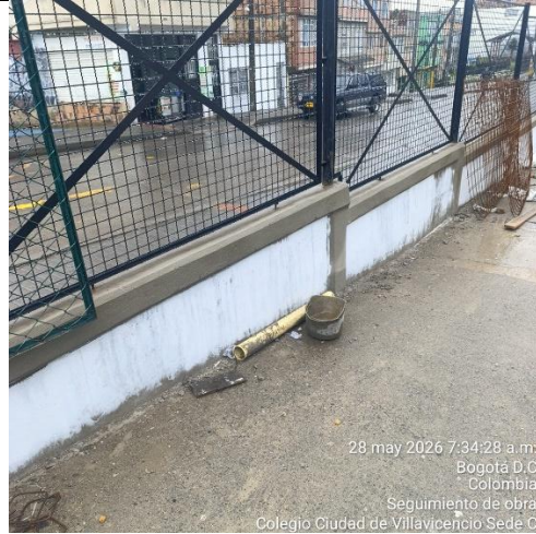
Ilustración No.20: Aplicación de pintura para fondo en muros
