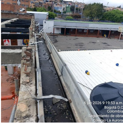
Ilustración No.13: Desmonte de canal
