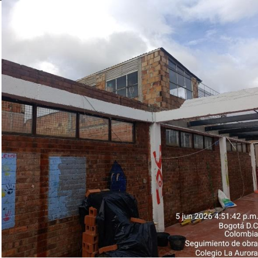
Ilustración No.17: Demolición encorizado de cubierta
