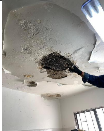
Ilustración No.13: Demolición de losa baño niñas primer piso
