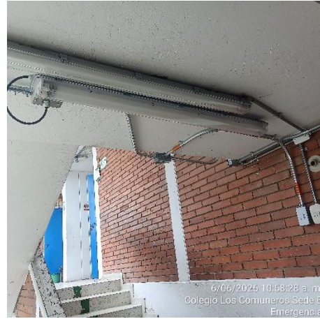
Ilustración No.6: Instalación de iluminarias pasillo segundo piso
