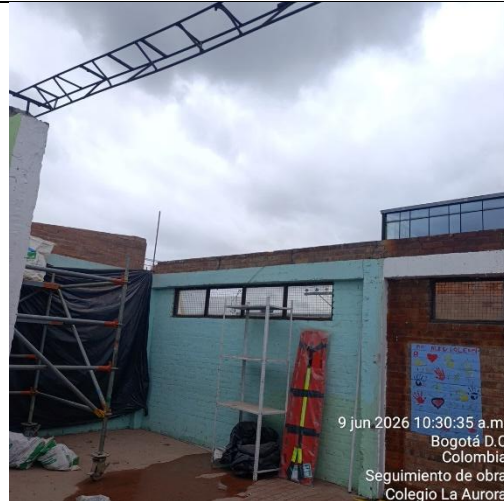
Ilustración No.26: Demolición encorizado de cubierta y desmonte de cubierta
