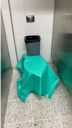
Ilustración No.7: cubrimiento de sanitarios
