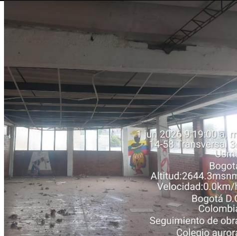
Ilustración No.28: Desmonte de cielorraso
