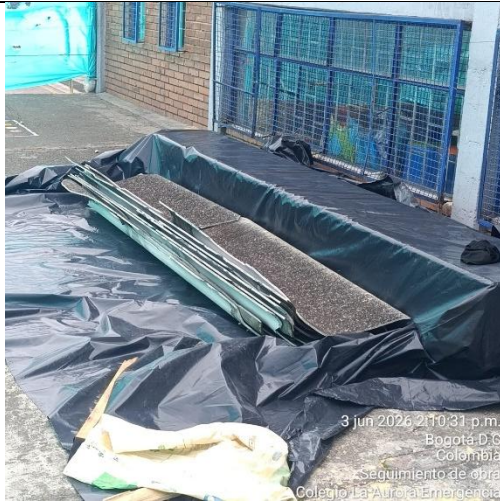
Ilustración No.7: Embalaje provisional teja de asbesto
