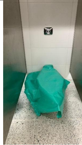
Ilustración No.6: cubrimiento de sanitarios
