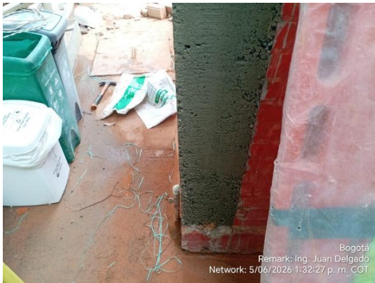
Ilustración No.21: Columnetas de confinamiento en concreto.
