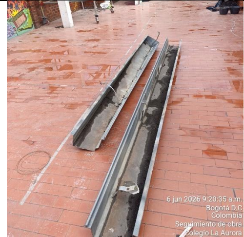
Ilustración No.12: Desmonte de canal
