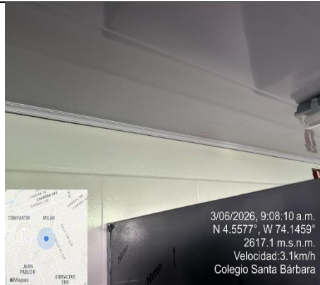
Ilustración No.327: Aplicación de pintura epóxica.
