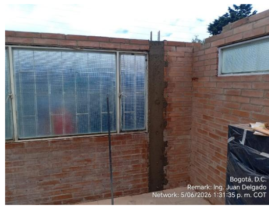
Ilustración No.22: Columnetas de confinamiento en concreto.
