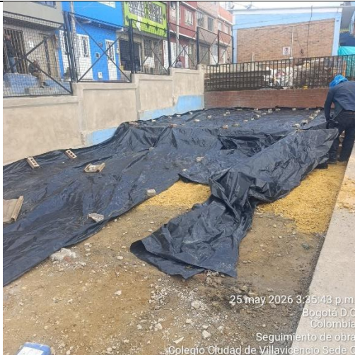
Ilustración No.13: Protección de suelos por malas condiciones climáticas
