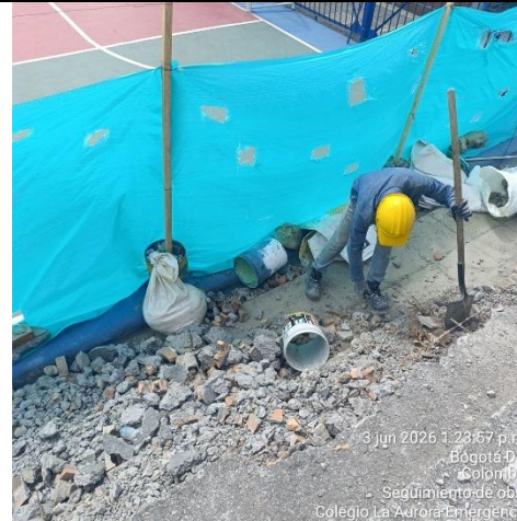
Ilustración No.16: Demolición de placa y muro en mampostería
