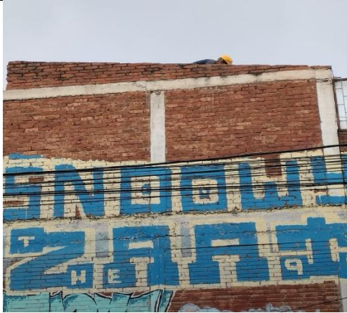
Ilustración No.39: Demolición mampostería de cuchillas
