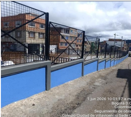
Ilustración No.35: Aplicación de pintura azul pacifico para acabado final de muros y gris basalto en vigas y columnas
