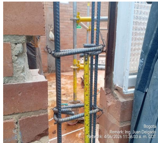
Ilustración No.26: Suministro e instalación acero de refuerzo 60000 PSI.
