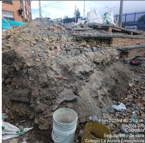
Ilustración No.29: Evidencia de relleno de gradería
