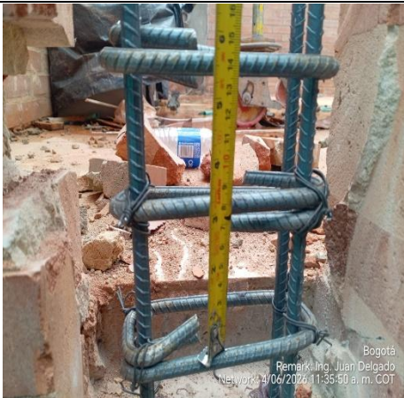
Ilustración No.25: Suministro e instalación acero de refuerzo 60000 PSI.
