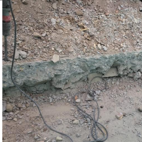
Ilustración No.32: Evidencia muro en concreto 10cm
