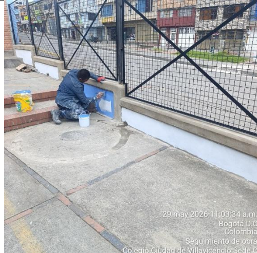
Ilustración No.24: Aplicación de pintura azul pacifico para acabado final
