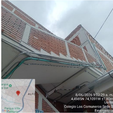
Ilustración No.19: Tubería emt 1"
