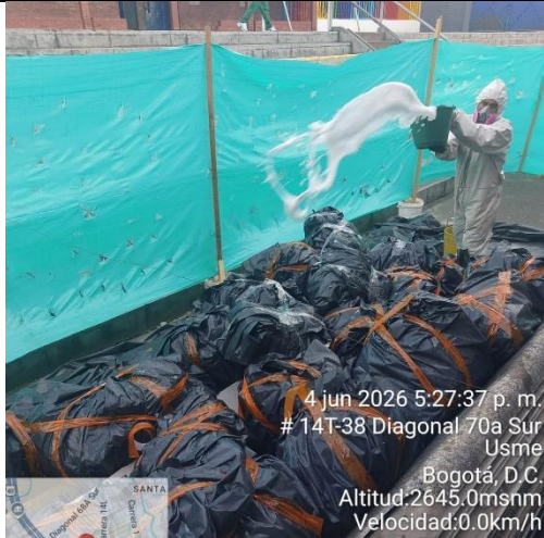
Ilustración No.35: Embalaje en plástico para teja en asbesto en punto de acopio y protocolo
