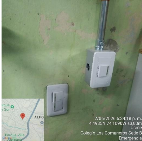
Ilustración No.9: Instalación de interruptores
