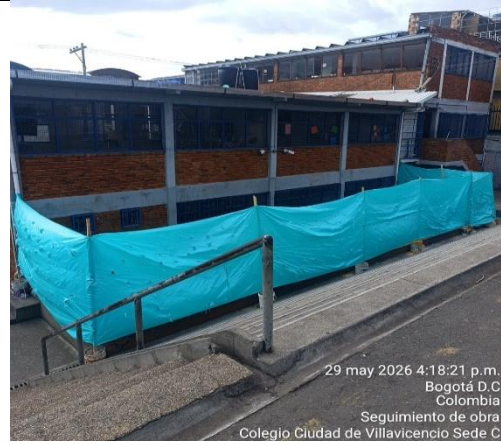
Ilustración No.40: Cerramiento punto de acopio material y residuos de obra
