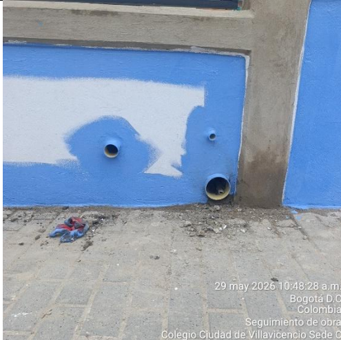
Ilustración No.23: Instalación de tubería para desagües de placa que atraviesan muros de cerramiento
