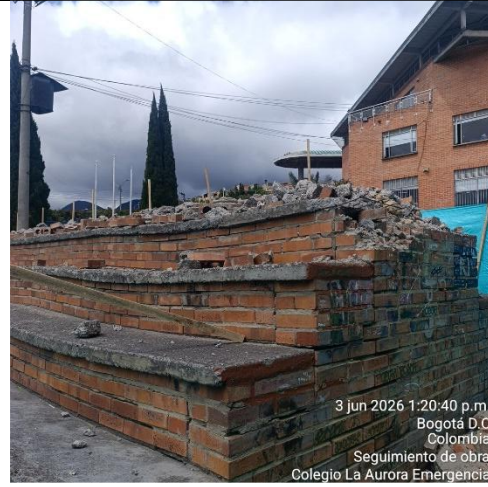
Ilustración No.18: Demolición de placa y muro en mampostería
