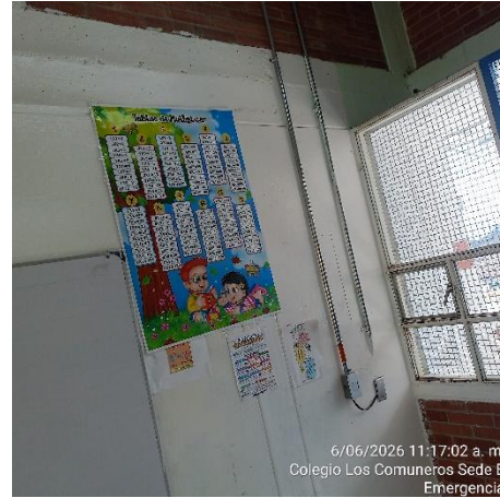
Ilustración No.10: Instalación de interruptores
