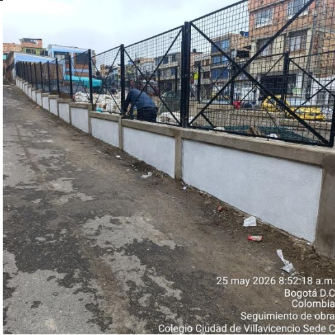
Ilustración No.19: Aplicación de pintura para fondo en muros
