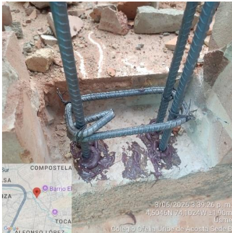
Ilustración No.31: Suministro e instalación de anclajes epóxico 3/8".
