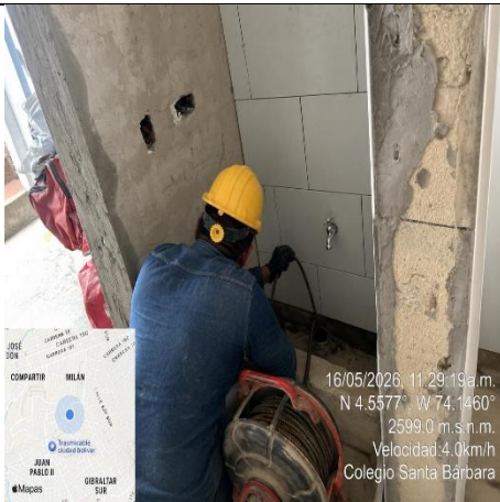
Ilustración No.298: Sondeo de desagües.
