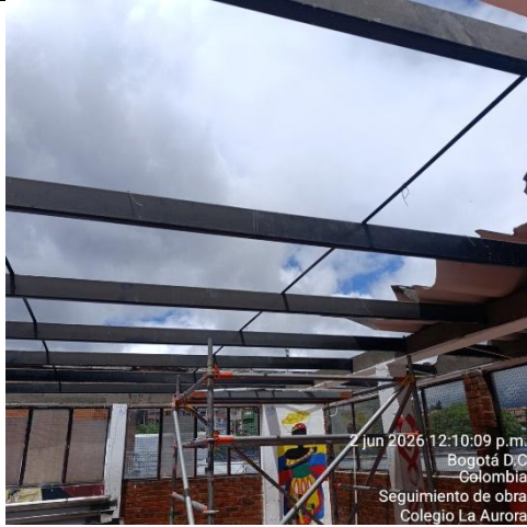
Ilustración No.5: Desmonte de cubierta
