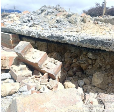
Ilustración No.23: Evidencia de relleno de gradería
