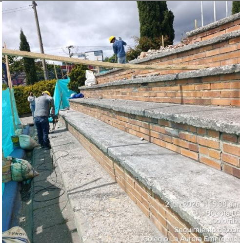
Ilustración No.12: Demolición de placa y muro en mampostería
