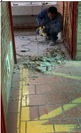
Ilustración No.15: Demolición de acabado y alistado de piso
