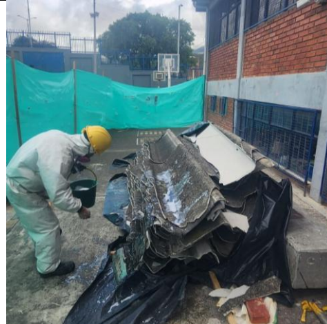
Ilustración No.30: Protocolo para teja de asbesto con agua jabonosa
