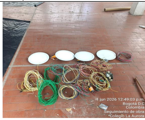
Ilustración No.42: Desmante eléctrico
