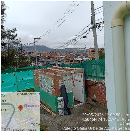
Ilustración No.5: Desmonte de teja orientación
