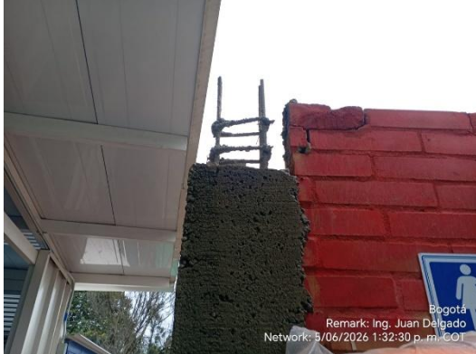
Ilustración No.23: Columnetas de confinamiento en concreto.
