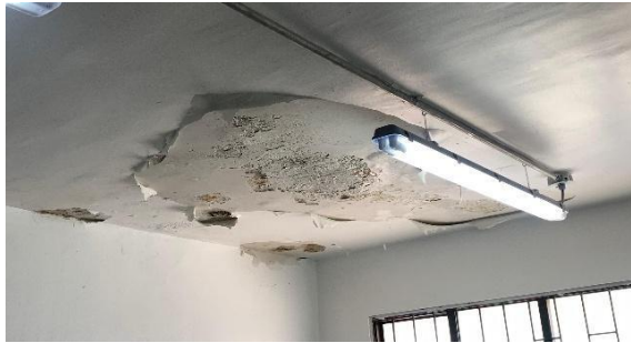
Ilustración No.9: Demolición de losa baño niñas primer piso
