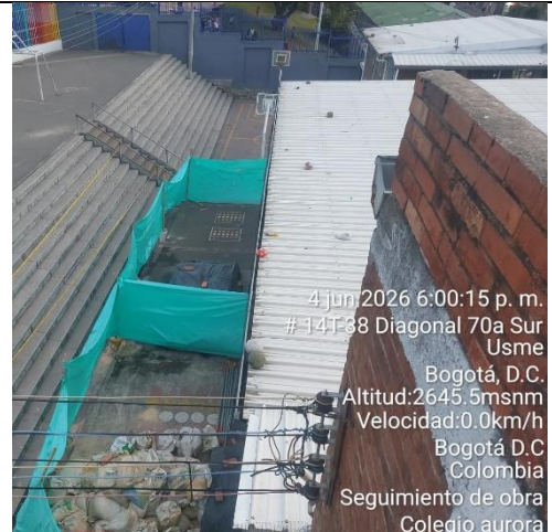
Ilustración No.37: Separación de punto de acopio de teja asbesto con otros materiales
