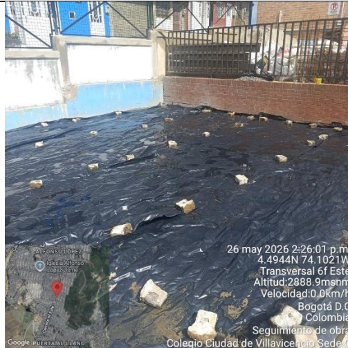
Ilustración No.14: Protección de suelos por malas condiciones climáticas
