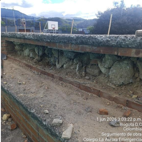
Ilustración No.31: Evidencia de relleno de gradería
