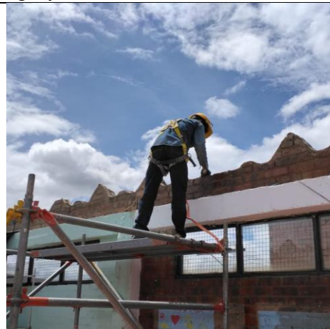
Ilustración No.32: Demolición encorizado de cubierta y desmonte de cubierta
