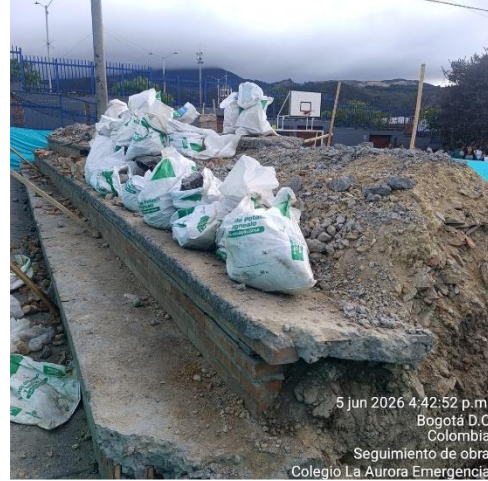
Ilustración No.28: Demolición de placa y muro en mampostería
