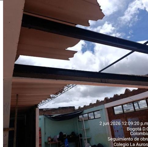
Ilustración No.6: Desmonte de cubierta
