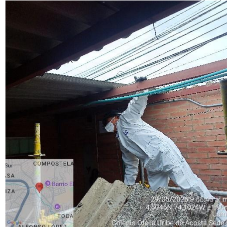
Ilustración No.4: Desmonte de teja de asbesto cemento
