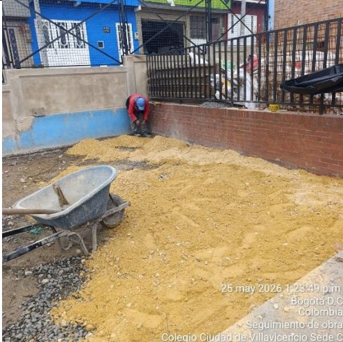
Ilustración No.11: Relleno con subbase granular (actividad suspendida por lluvias)
