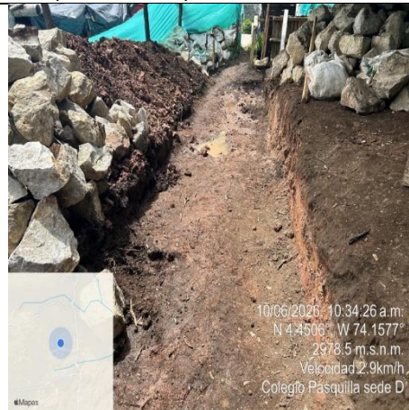
Ilustración No.165: Excavación preliminar para muro de contención.
