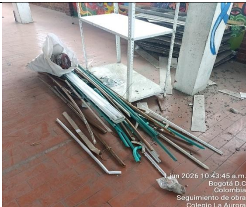
Ilustración No.41: Desmante eléctrico
