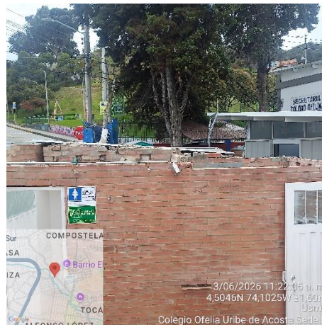
Ilustración No.10: Demolición de muros de cuchilla
