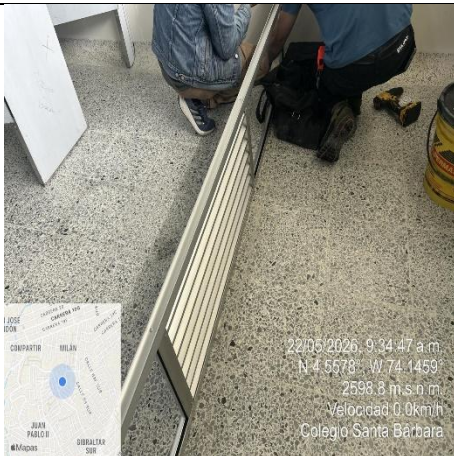
Ilustración No.314: Suministro e instalación de ventanería en aluminio.
