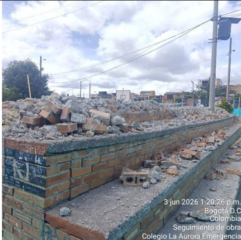
Ilustración No.19: Demolición de placa y muro en mampostería
