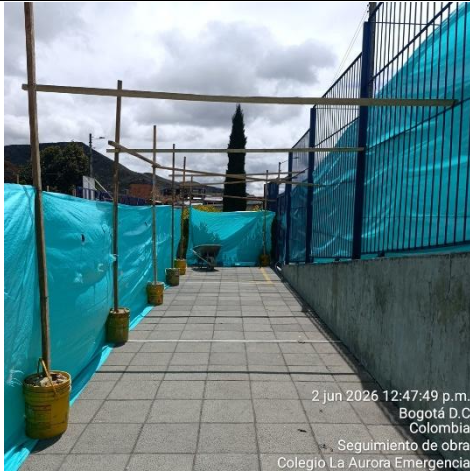
Ilustración No.5: Cerramiento punto de acopio
