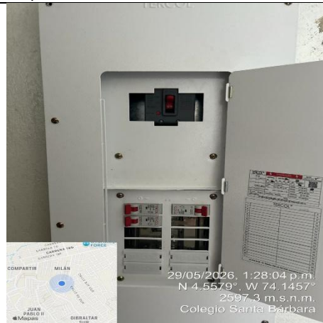
Ilustración No.301: Suministro e instalación de
