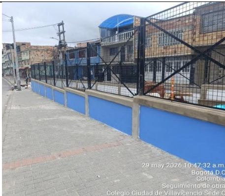
Ilustración No.33: Aplicación de pintura azul pacifico para acabado final
