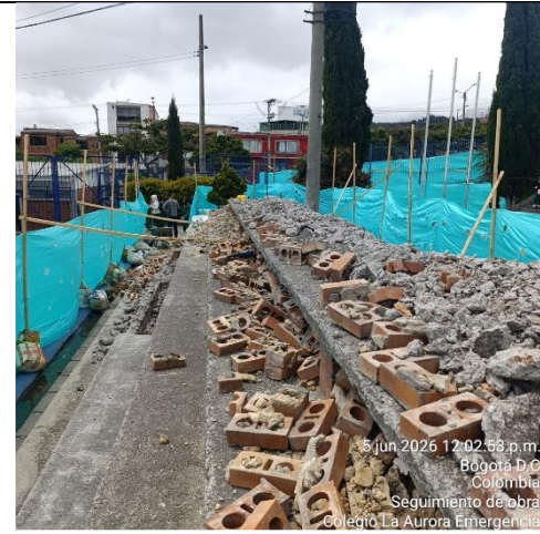
Ilustración No.30: Demolición de placa y muro en mampostería
