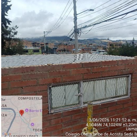
Ilustración No.11: Demolición de muros de cuchilla
