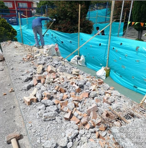
Ilustración No.11: Demolición de placa y muro en mampostería
