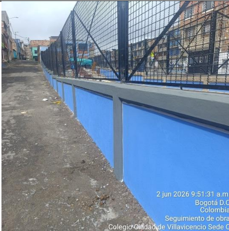
Ilustración No.27: Aplicación de pintura azul pacifico para acabado final de muros y gris basalto en vigas y columnas
