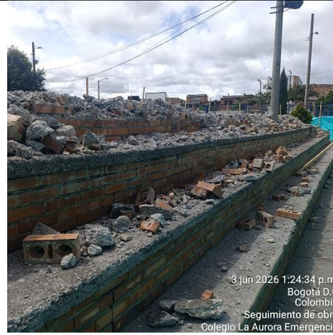
Ilustración No.14: Demolición de placa y muro en mampostería
