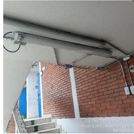
Ilustración No.14: Interruptores de pasillos
