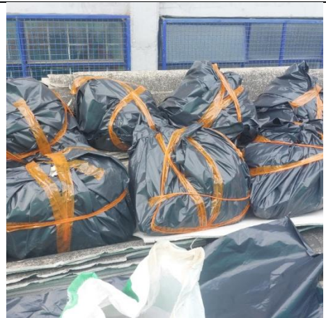
Ilustración No.31: Embalaje en plástico para teja en asbesto en punto de acopio
