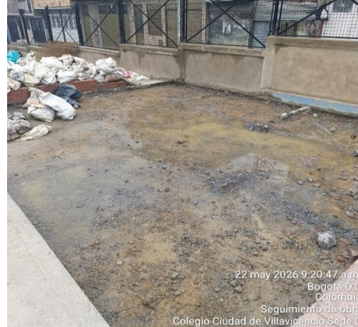
Ilustración No.6: Demolición de placa en zona recreativa 3
