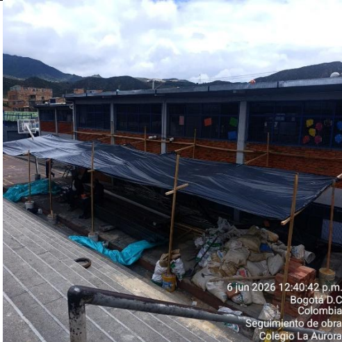
Ilustración No.9: Armado estructura provisional para pintura de perfiles
