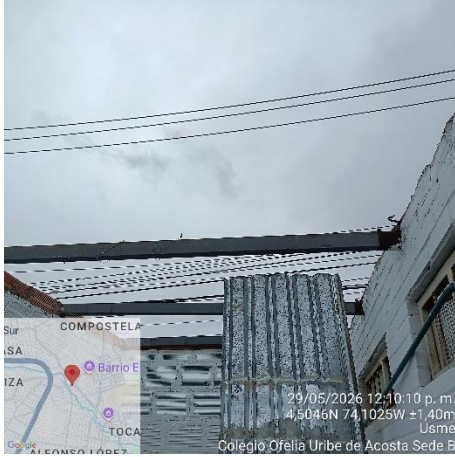
Ilustración No.7: Desmonte de teja cuarto de deportes
