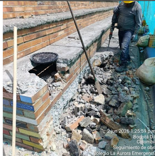
Ilustración No.8: Demolición de placa y muro en mampostería
