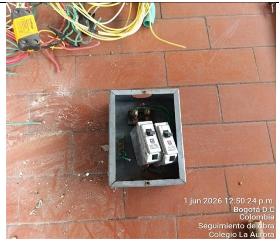
Ilustración No.44: Desmante tablero
