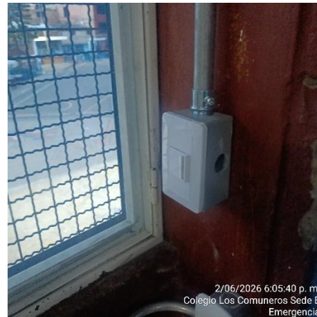
Ilustración No.12: Instalación de interruptores
