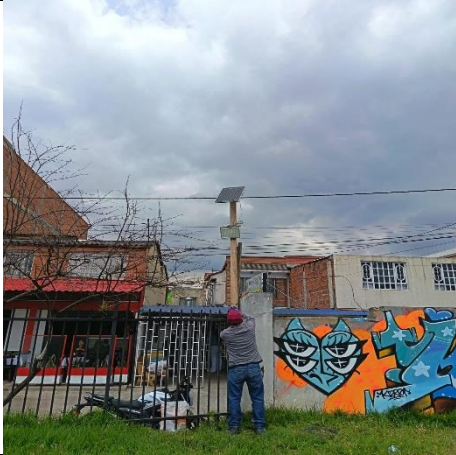
Ilustración No.281: Instalación de lámparas.
