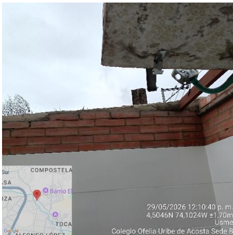
Ilustración No.9: Desmonte red y aparatos eléctricos
