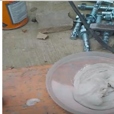
Ilustración No.291: Anclaje de pernos con epóxico.
