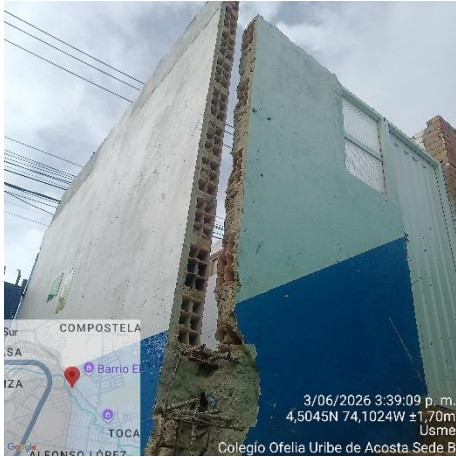
Ilustración No.13: Corte y regata de muro en ladrillo
