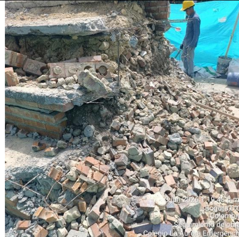
Ilustración No.20: Demolición de placa y muro en mampostería
