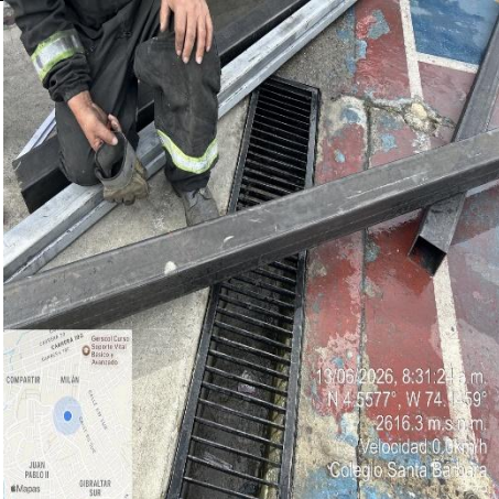
Ilustración No.290: Suministro de perfilería para estructura de cubierta en placa de tanques.
