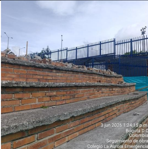
Ilustración No.15: Demolición de placa y muro en mampostería
