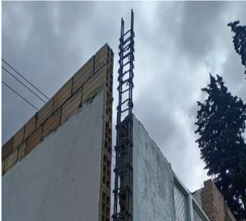
Ilustración No.29: Muro divisorio bloque estirado No. 5.
