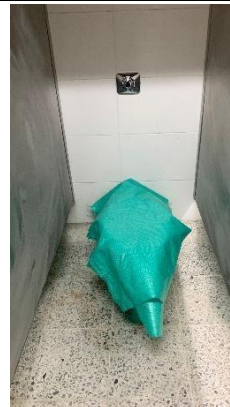
Ilustración No.4: cubrimiento de sanitarios
