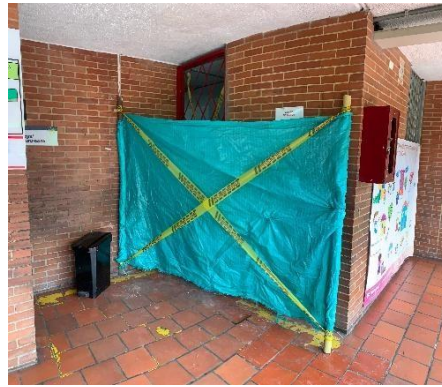
Ilustración No.2: Cerramiento área a intervenir
