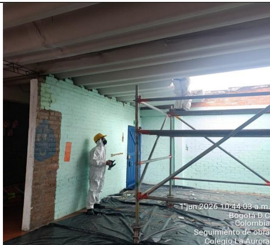
Ilustración No.43: Protección de pisos para desmante de teja en asbesto
