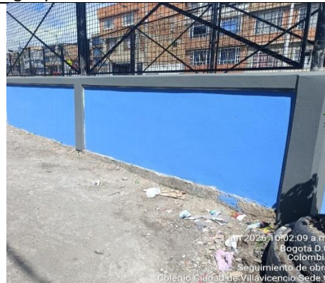
Ilustración No.36: Aplicación de pintura azul pacifico para acabado final de muros y gris basalto en vigas y columnas
