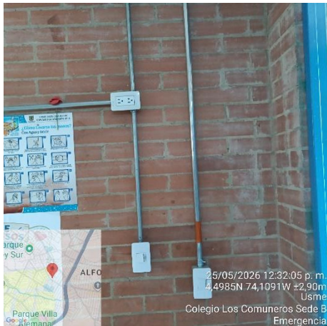
Ilustración No.11: Instalación de interruptores
