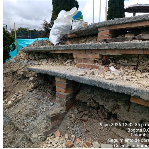
Ilustración No.36: Evidencia muros internos transversales para apoyo de placas
