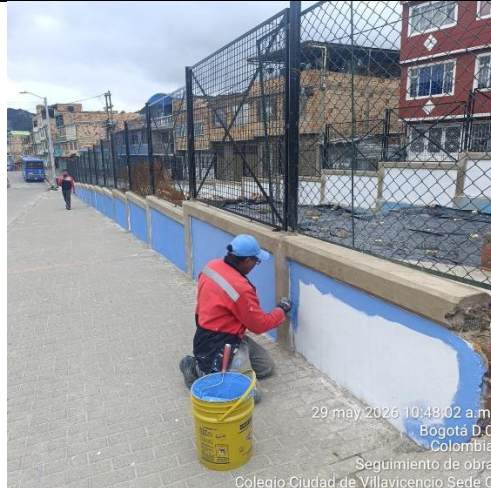
Ilustración No.22: Aplicación de pintura azul pacifico para acabado final
