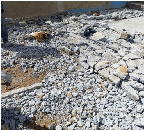
Ilustración No.3: Demolición de placa en zona recreativa 3
