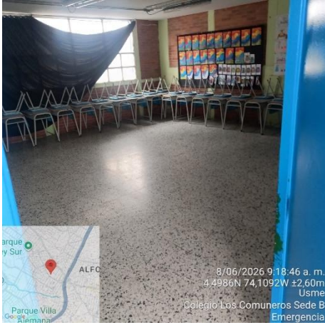
Ilustración No.23: Aseo áreas intervenidas
