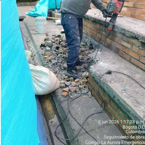
Ilustración No.9: Demolición de placa y muro en mampostería
