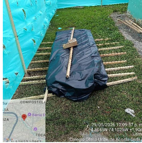
Ilustración No.8: Empacado de teja de asbesto cemento
