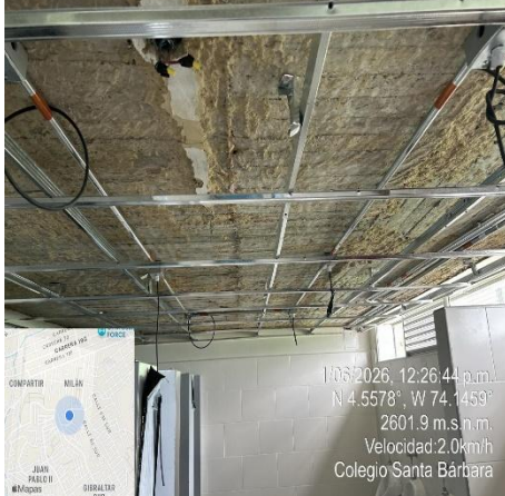
Ilustración No.328: Estructura para techo en PVC.
