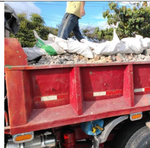
Ilustración No.34: Retiro de escombros para disposición final
