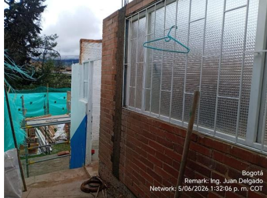
Ilustración No.24: Columnetas de confinamiento en concreto.
