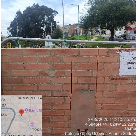
Ilustración No.19: Perforación regatas en muros.
