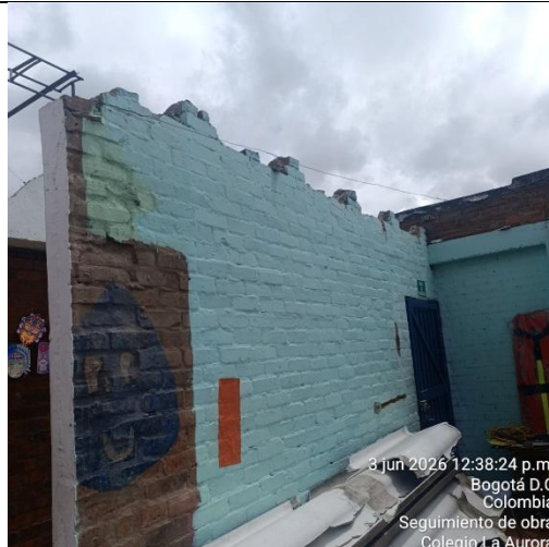
Ilustración No.8: Demolición encorizado de cubierta
