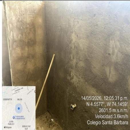
Ilustración No.325: Pañete impermeabilizado.
