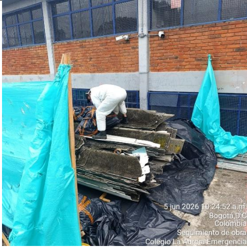
Ilustración No.21: Disposición final teja de asbesto
