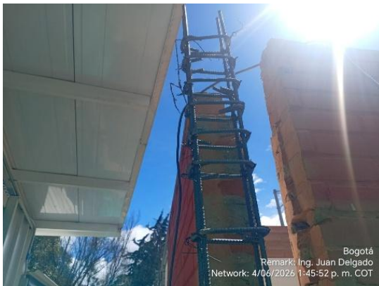
Ilustración No.25: Suministro e instalación acero de refuerzo 60000 PSI.
