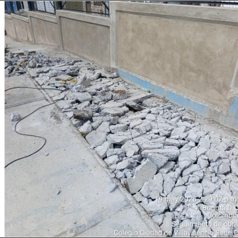
Ilustración No.2: Demolición de placa en zona recreativa 3
