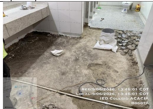
Ilustración No.14: Demolición de losa baño niñas primer piso
