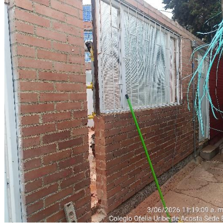
Ilustración No.12: Corte y regata de muro en ladrillo
