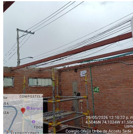
Ilustración No.6: Desmonte de teja sala de profesores y baño
