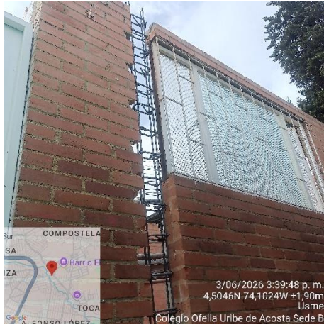
Ilustración No.15: Instalación de refuerzo de columna
