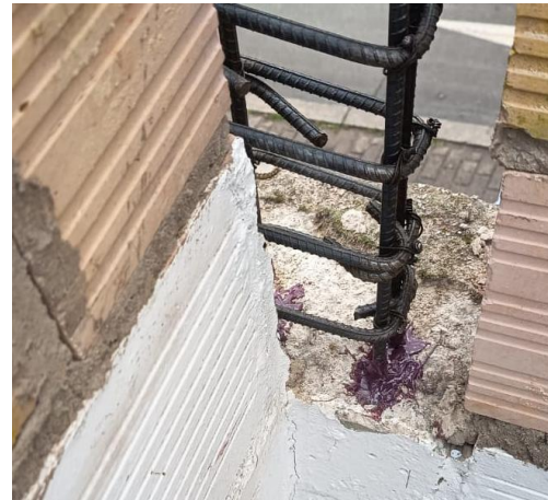
Ilustración No.32: Suministro e instalación de anclajes epóxico 3/8".
