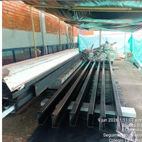
Ilustración No.24: Aplicación de anticorrosivo en perfilaría
