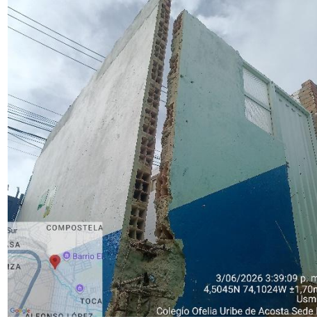
Ilustración No.20: Perforación regatas en muros.
