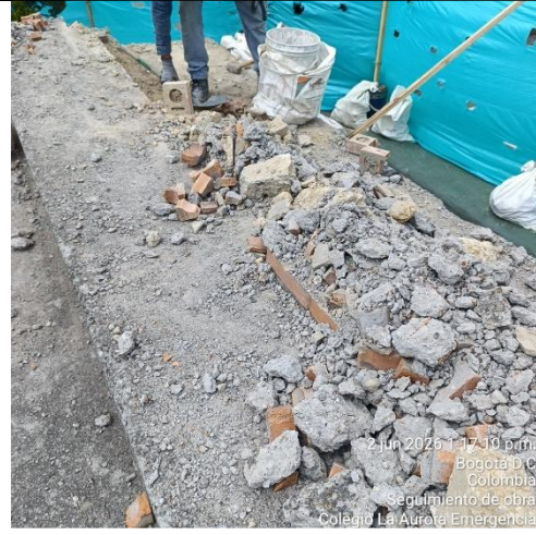
Ilustración No.10: Demolición de placa y muro en mampostería
