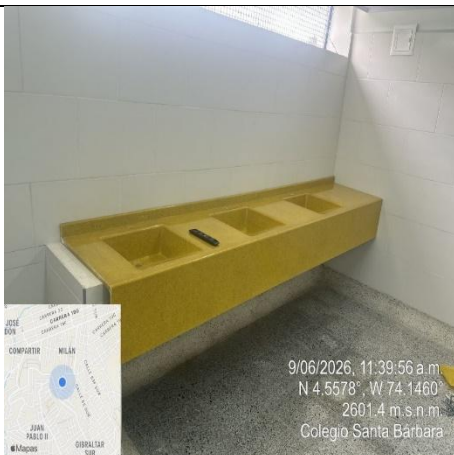
Ilustración No.316: Suministro e instalación de
