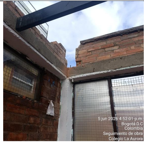
Ilustración No.16: Demolición de cuchillas de mampostería
