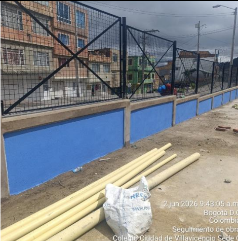
Ilustración No.29: Aplicación de pintura azul pacifico para acabado final de muros y gris basalto en vigas y columnas
