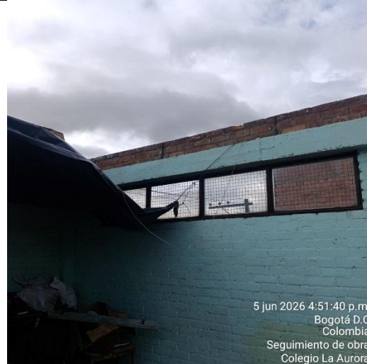
Ilustración No.18: Demolición encorizado de cubierta
