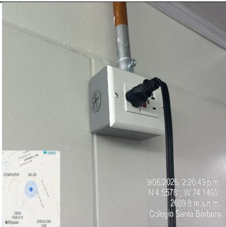
Ilustración No.300: Suministro e instalación de
