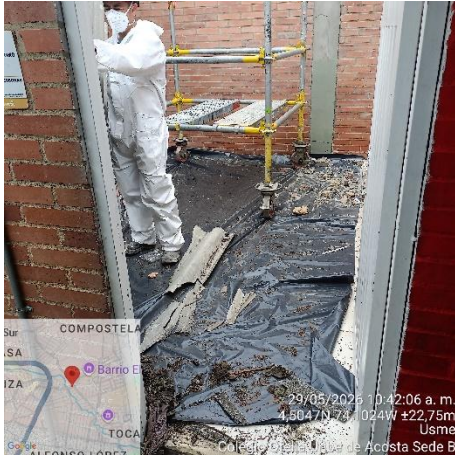
Ilustración No.3: Instalación de plástico al piso
