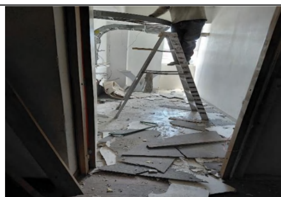
DEMOLICIÓN TECHO DRYWALL CUARTO ELÉCTRICO
