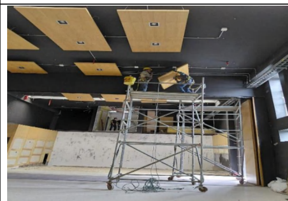
DESMONTE DE PANELES DE MADERA TECHO AUDITORIO
