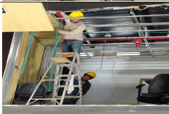
DESMONTE DE CABLE LÁMPARAS Y TUBERÍA EMT DE ½"
