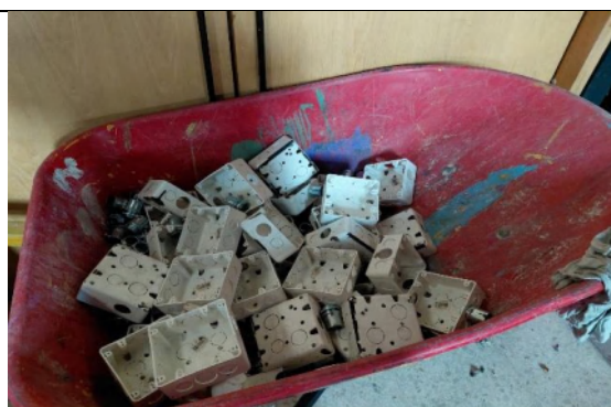
DESMONTE DE CAJAS PLÁSTICAS Y CABLE ELÉCTRICO
