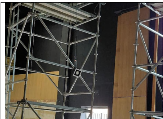
DESMONTE DE FOCOS PANELES DE MADERA TECHO AUDITORIO
