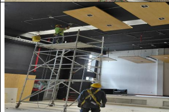
DESMONTE DE CABLE LÁMPARAS Y TUBERÍA EMT DE ½"
