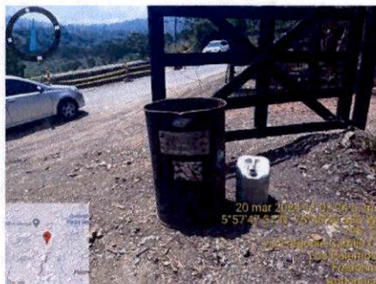
Foto 3. El Contratista implemento caneca de 55 galones para la disposición de los residuos sólidos en el Frente de obra Camilo CE – El Cinco – Fredonia (60AN09).
