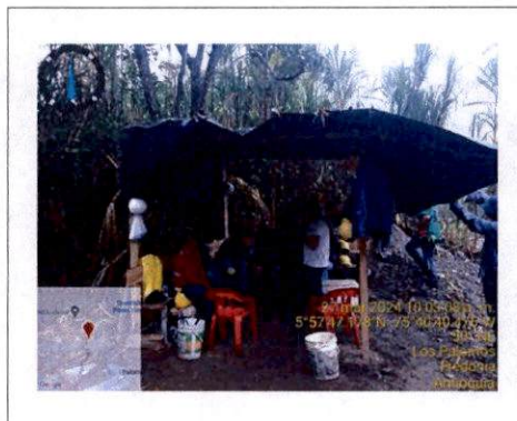
Foto 5. El contratista continuo con la implementación de zona de campamento en el frente de El Cinco- Fredonia (60AN09-1).
