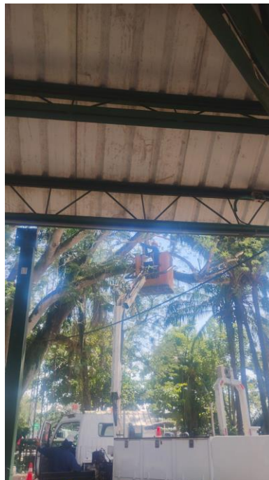
Imagen 4. Identifica actividades de poda de ramas de los samanes con brazo grúa los cuales generan riesgo sobre el techo del auditorio.
