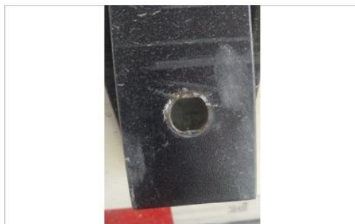
Punto de instalación chapa gaveta.
