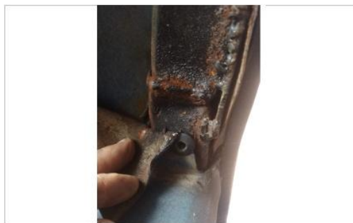
Punto de soldadura parál derecho.
