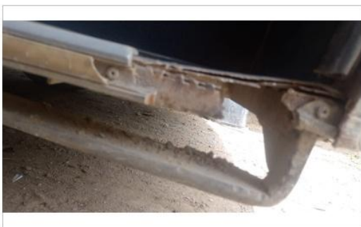
Punto de soldadura de escalerilla.
