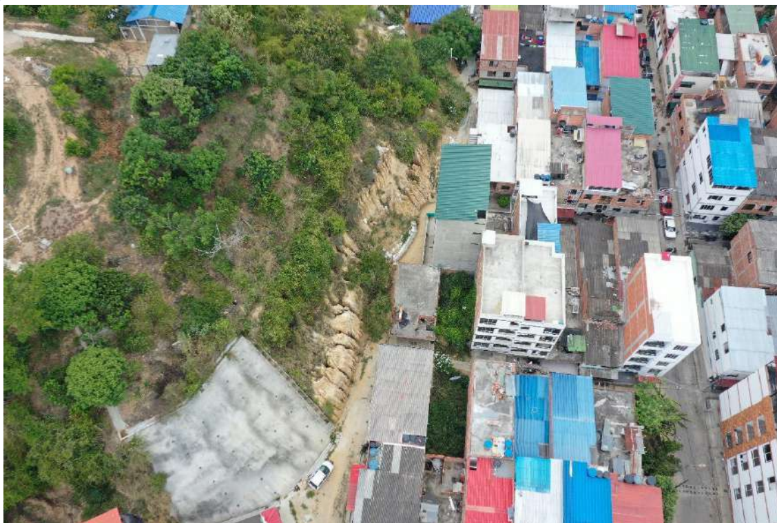
Ubicación del frente de obra Calle 2ª con Carrera 15B, Barrio Villas de los Caballeros, Girón, Santander
