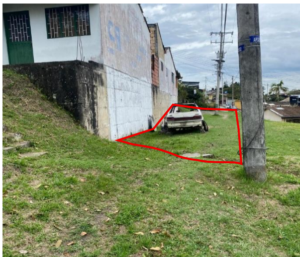
Fotografía 3 y 4. Talud con evidente proceso de socavación el cual se encuentra muy cerca a las viviendas.
