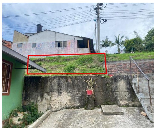
Fotografía 3 y 4. Talud con evidente proceso de socavación el cual se encuentra muy cerca a las viviendas.
