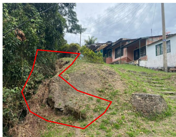
Fotografía 3 y 4. Talud con evidente proceso de socavación el cual se encuentra muy cerca a las viviendas.
