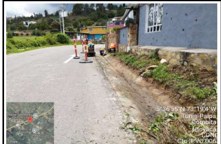
Descripción de la fotografía Corte de pavimento
