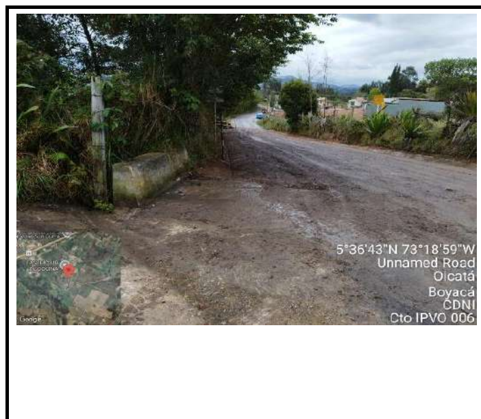
Descripción de la fotografía Limpieza de la cuneta
