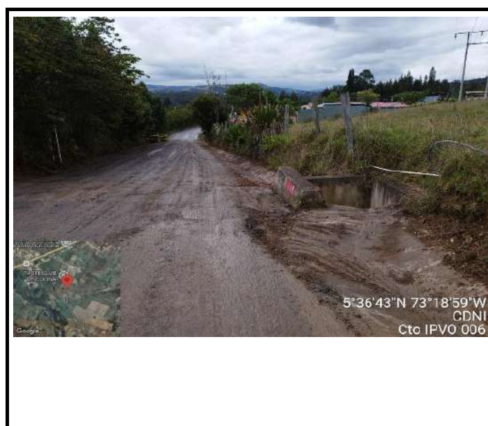
Descripción de la fotografía Limpieza del descole de la cuneta
