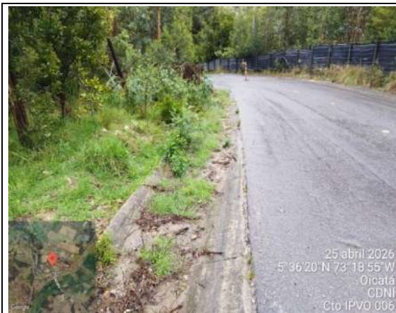
Limpeza de cunetas en concreto
