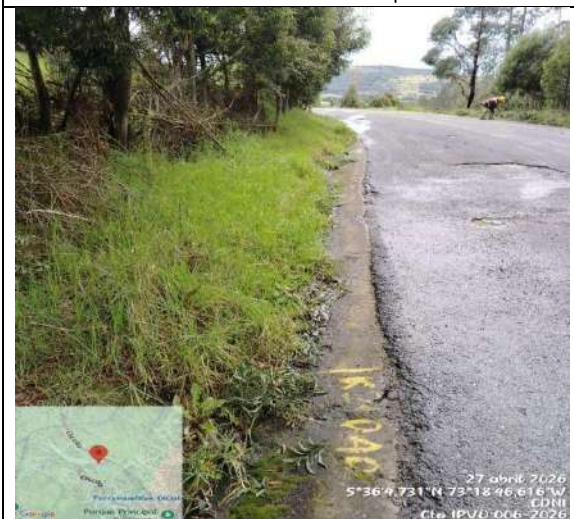
Limpeza de cunetas en concreto
