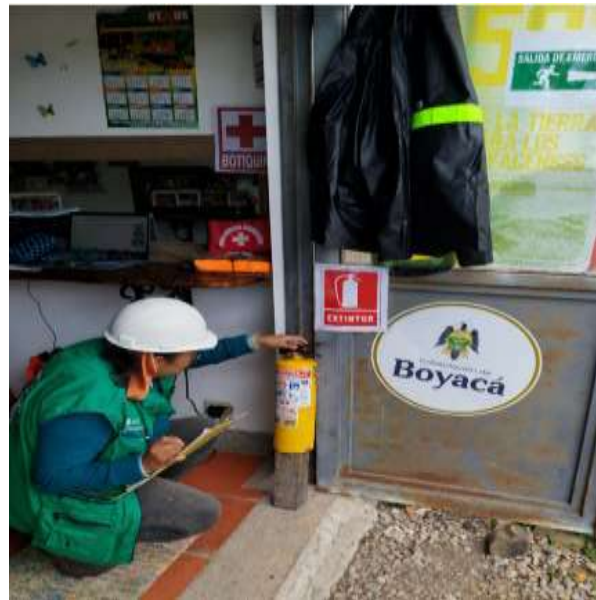
Inspección de extintor
