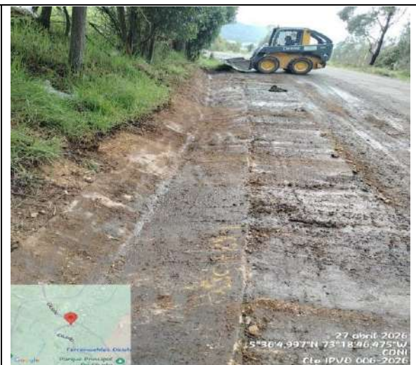
Limpeza de cunetas en concreto
