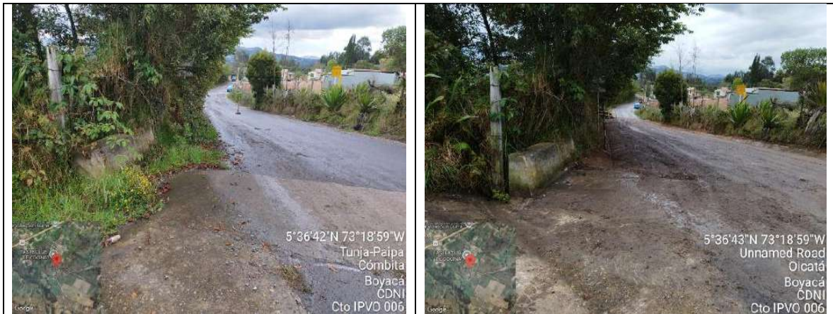
Limpieza de cunetas en concreto
