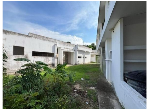
Fotografía 2. Vista estructuras existentes
