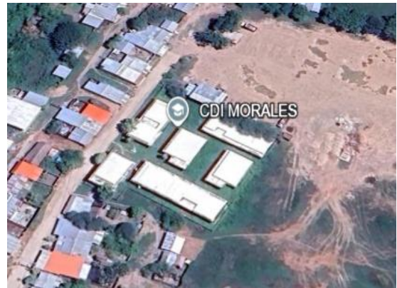
Fotografía 10. Vista área de las estructuras
