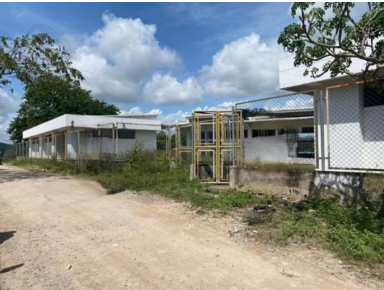
Fotografía 11. Estructura existente y cerramiento
