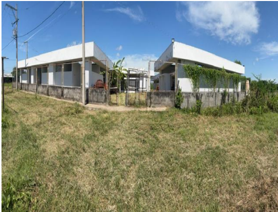
Fotografía 7. Estructura existente y cerramiento
