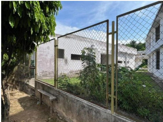
Fotografía 1. Estructuras existentes y cerramiento
