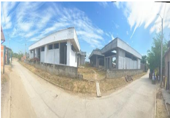
Fotografía 9. Estructura existente y cerramiento
