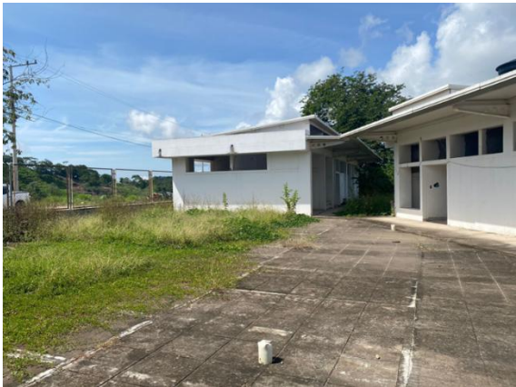
Fotografía 12. Vista de las estructuras
