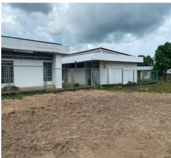
Fotografía 5. Estructura existente y cerramiento
