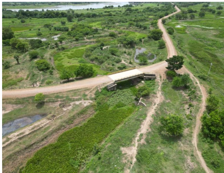
Estado inicial Caño Real del Obispo
