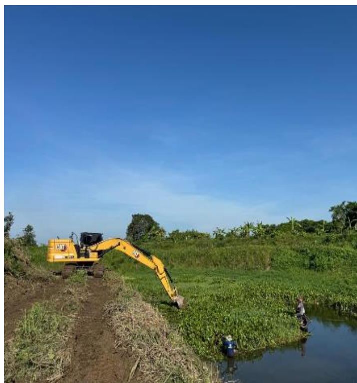
Actividades de Limpieza Mecánica
