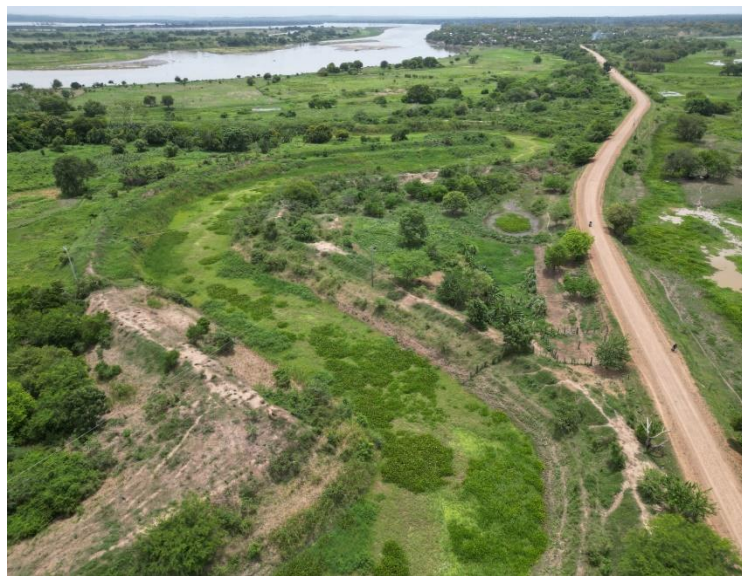
Estado inicial Caño Real del Obispo
