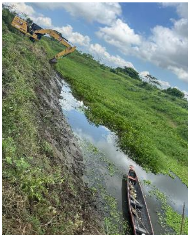
Actividades de Limpieza Mecánica
