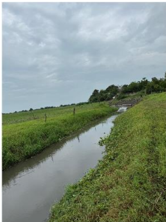
Estado después de la Limpieza
