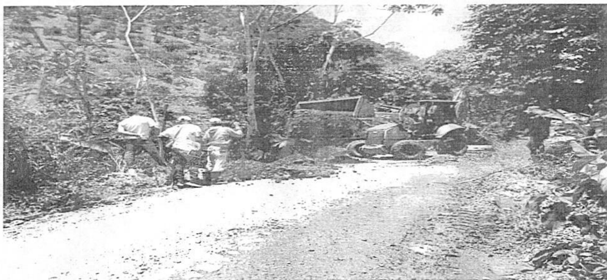
6. OBRAS EN SEDE VILLA SILVIA Y GALERIA DE GAVIONES EN VÍA VIA LA ARABIA - VILLA SILVIA
