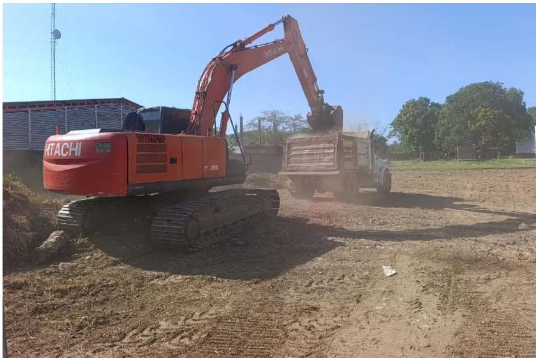
Imagen 5 Descapote y carue de material sobrante
