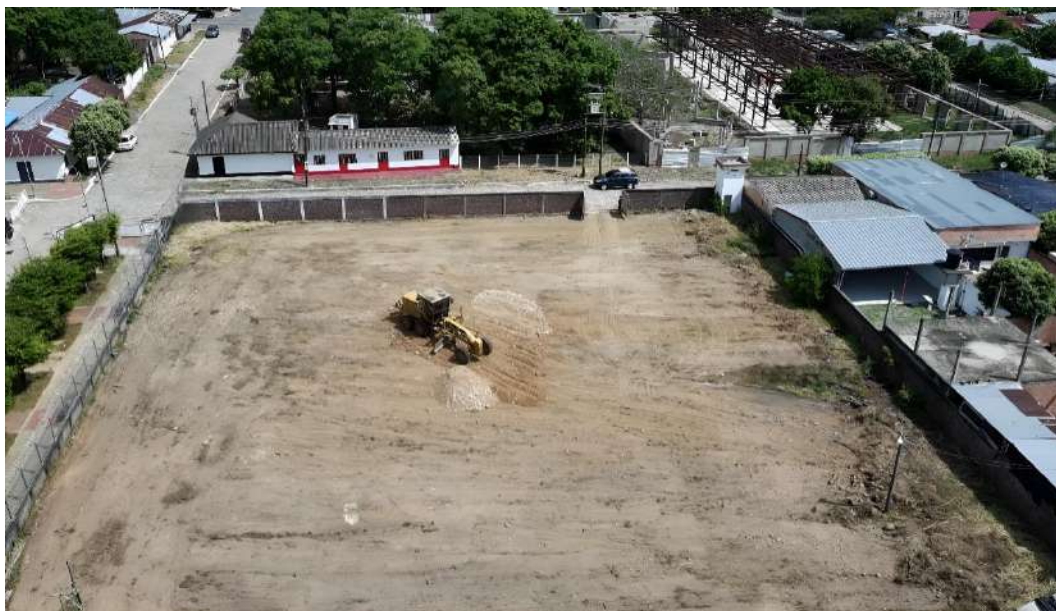
Imagen 10 Transporte de material para mejoramiento de la subrasante
