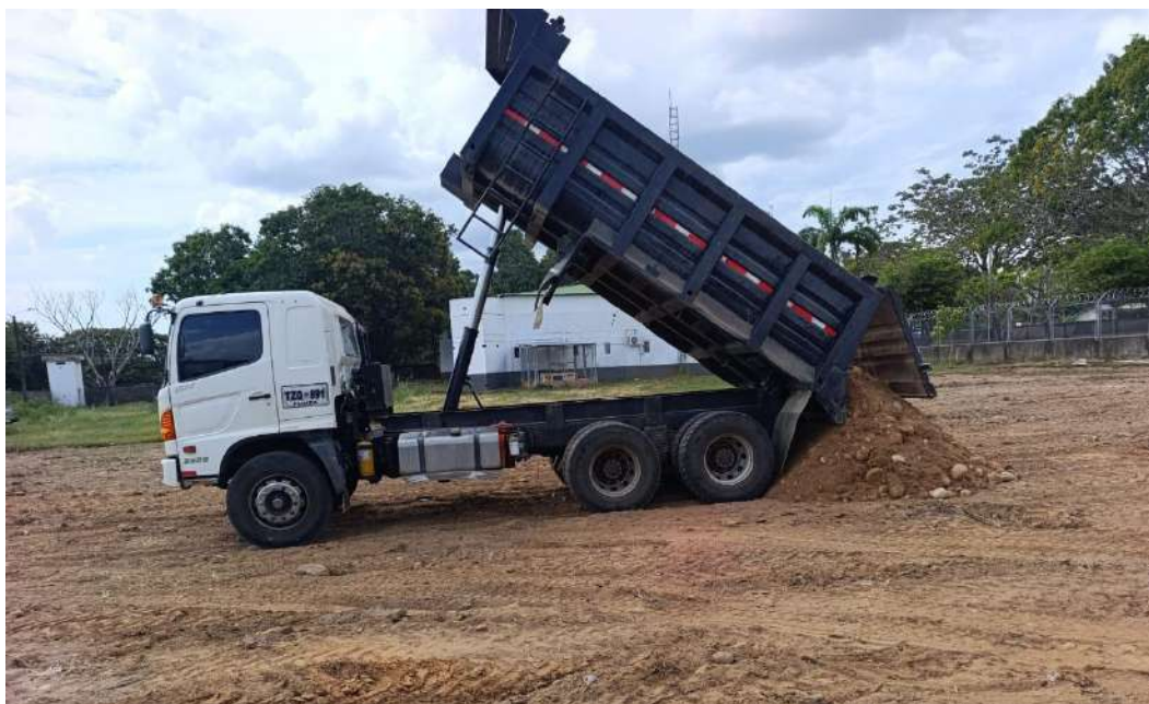
Imagen 8 Transporte de material para mejoramiento de la subrasante
