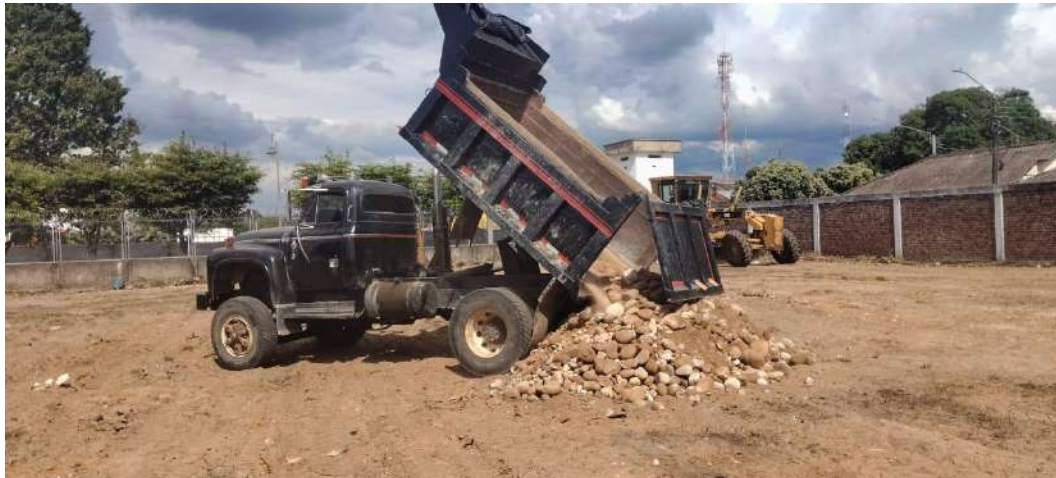
Imagen 9 Transporte de material para mejoramiento de la subrasante
