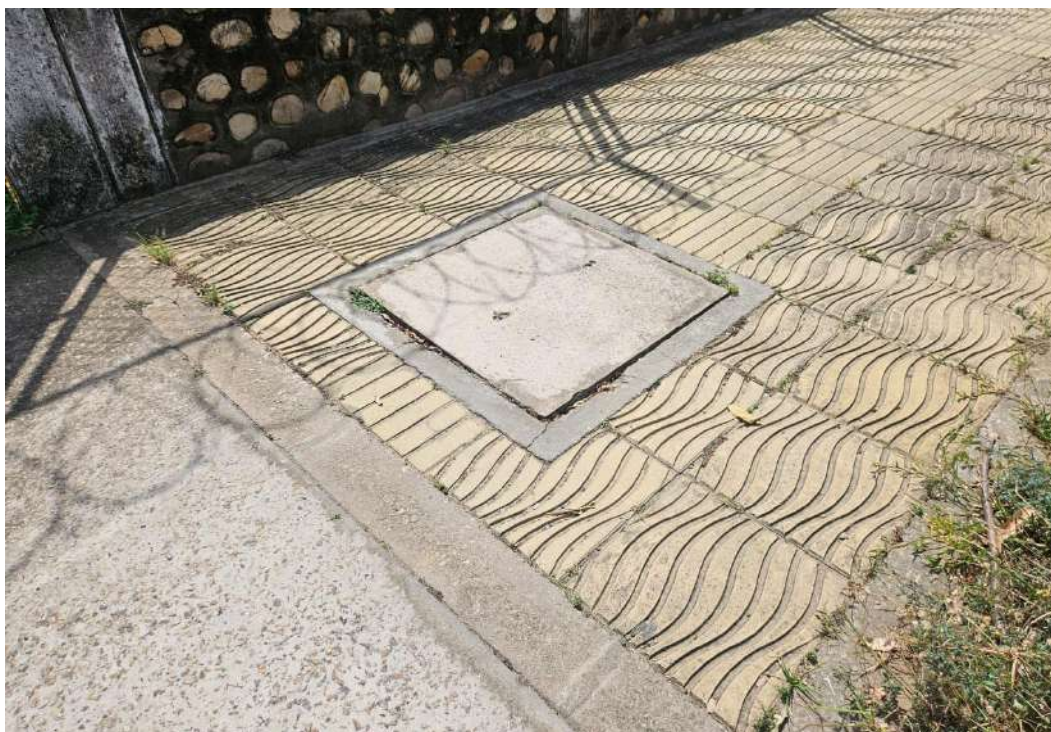
Imagen 11 Caja de inspección / acometida de alcantarillado sanitario debidamente conectado a la red de aguas servidas
