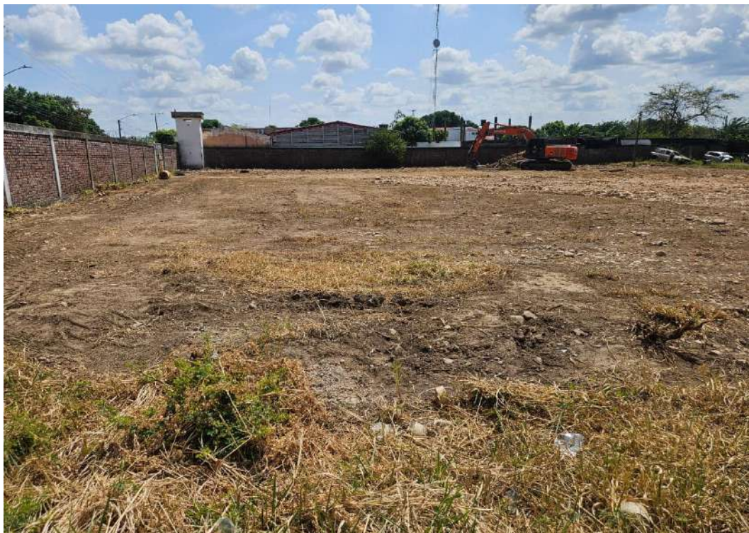
Imagen 5 Descapote y carue de material sobrante
