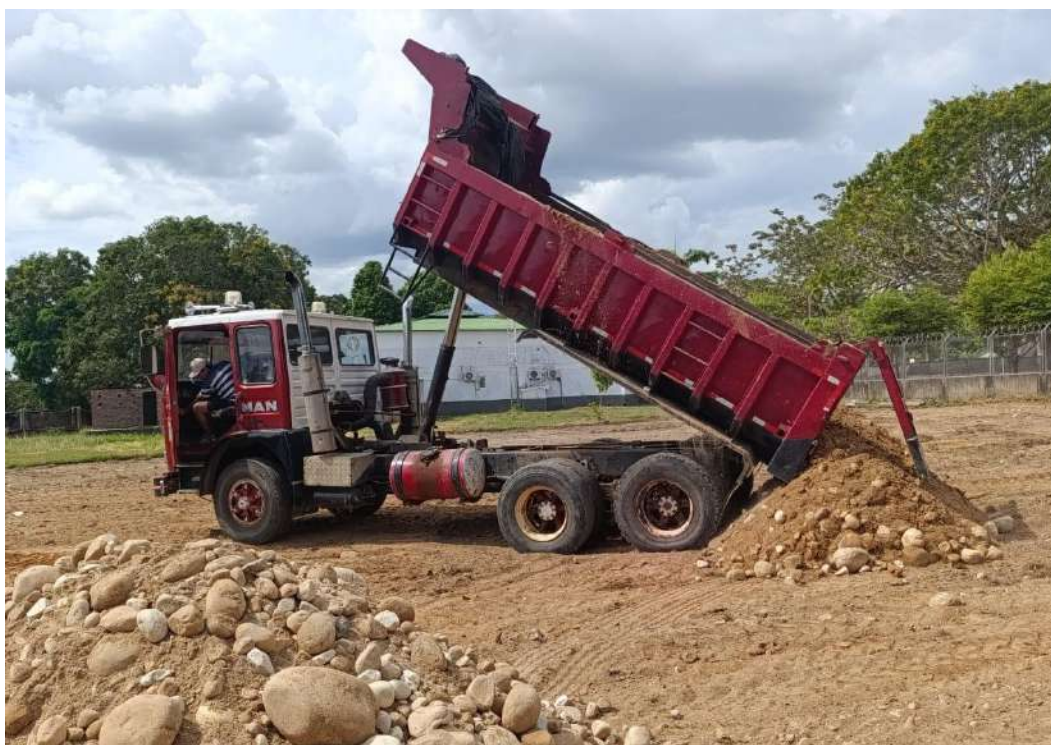
Imagen 7 Transporte de material para mejoramiento de la subrasante
