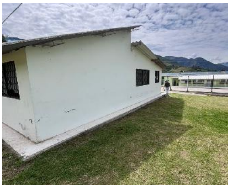
Ilustración 2 - Fachada lateral Centro de Salud - sede Guapuscal Bajo
