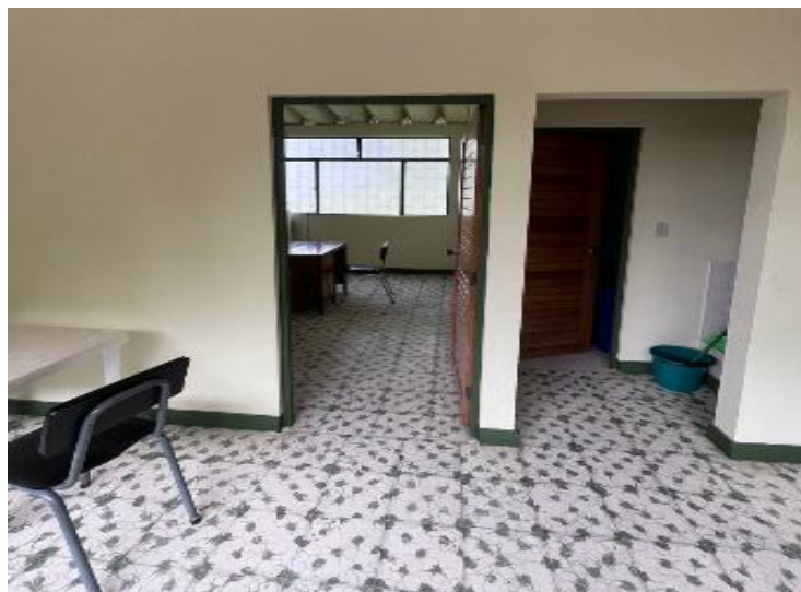
Ilustración 2 – Demolición de enchape de Centro de Salud - sede Guapuscal Alto
