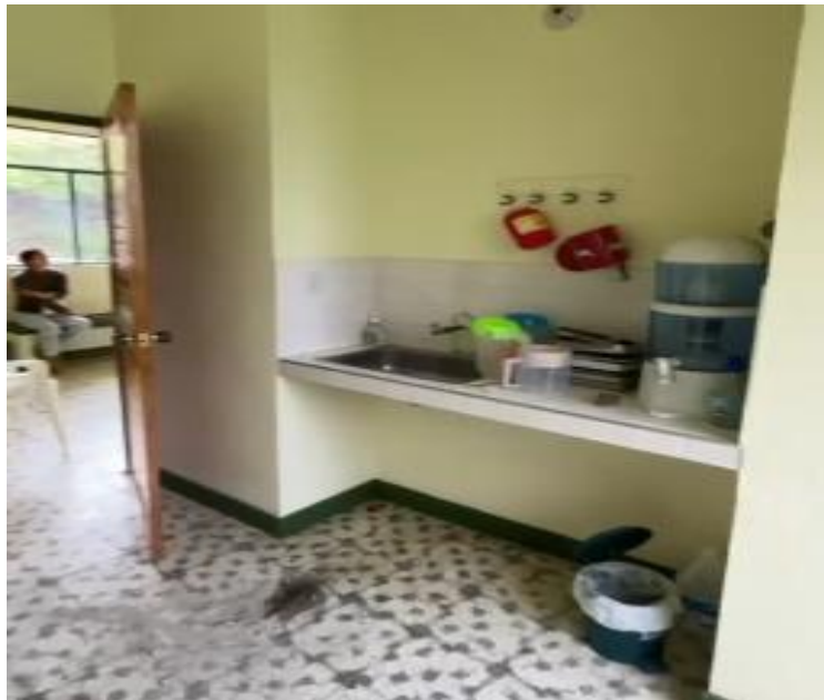
Ilustración 3 – Demolición de muro para habilitar baño para personas con movilidad reducida de Centro de Salud - sede Guapuscal Alto
