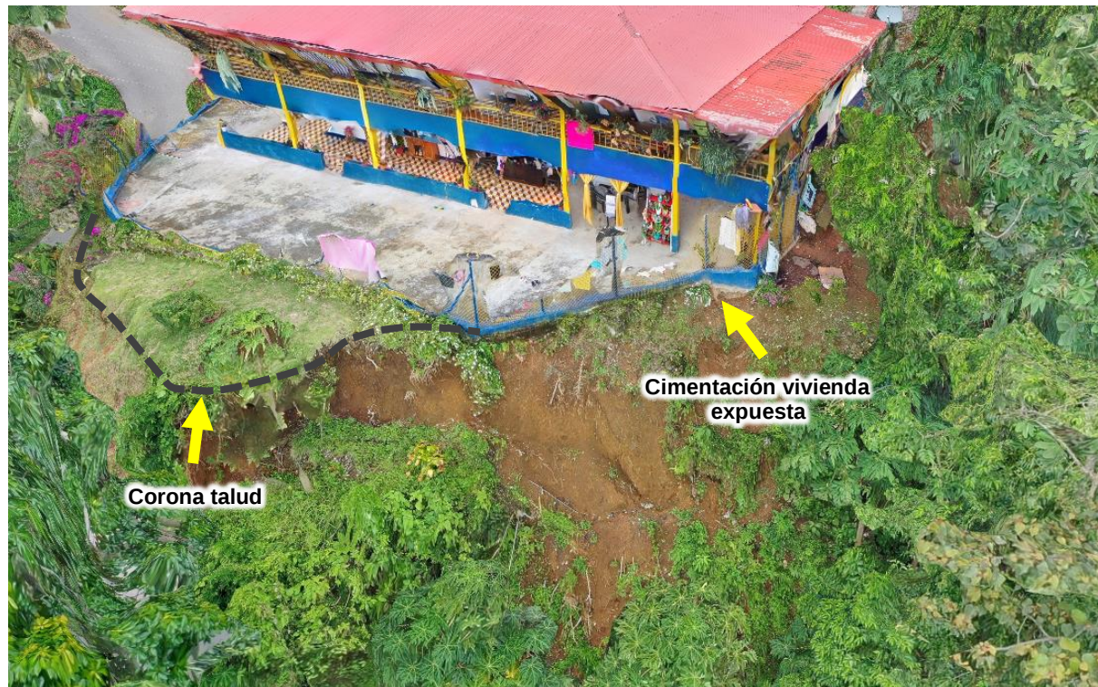
Figura 8. Posición de la vivienda con respecto al movimiento en masa.
